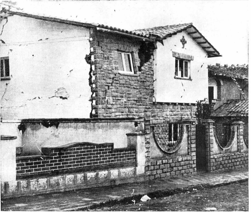
Foto 6. Casa nueva de adobe y piedra en la Avenida Pardo.
