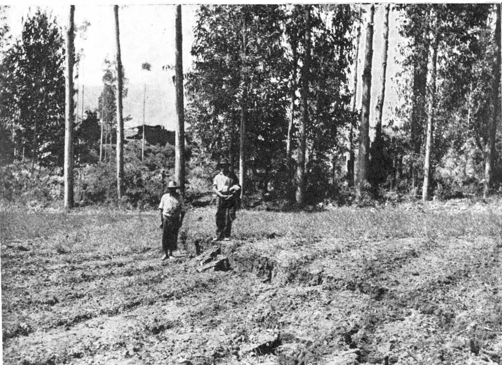
Foto 7. Fisura abierta en terrenos de cultivo en la parte sur de la cuenca del Cuzco, al suroeste de San Sebastián.
