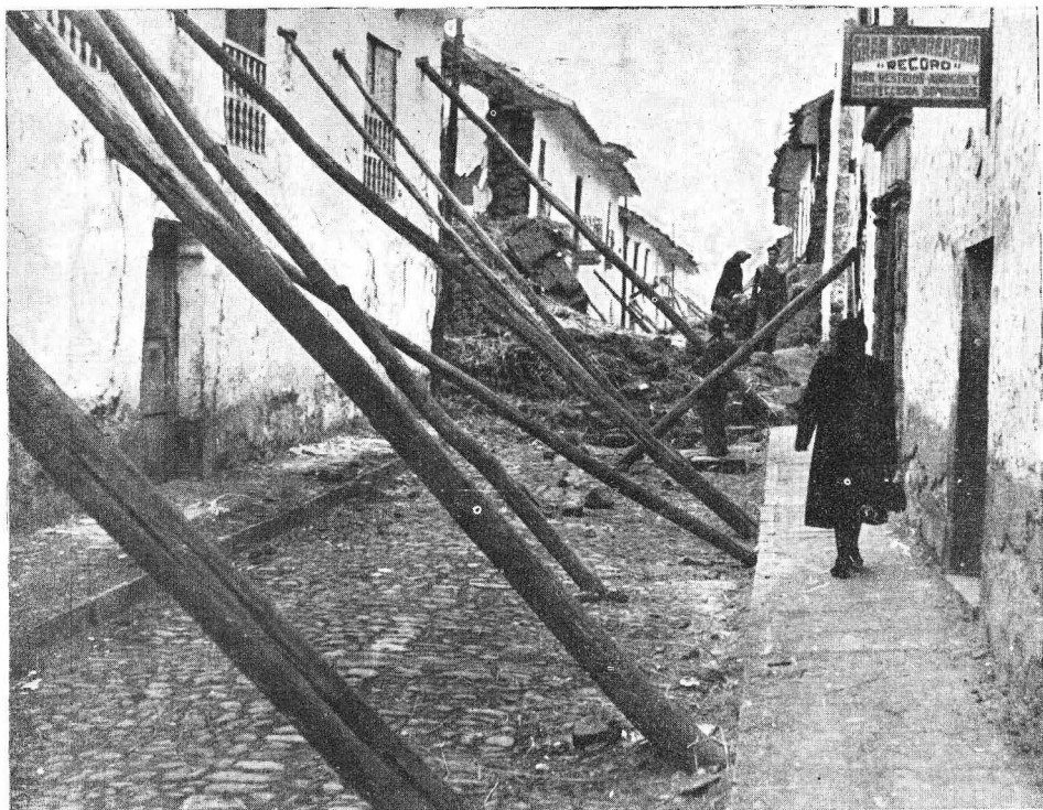
Foto 5. Vista mirando hacia el sur de la Avenida Belén. Las paredes de las casas de adobe han sido apuntaladas con troncos.
