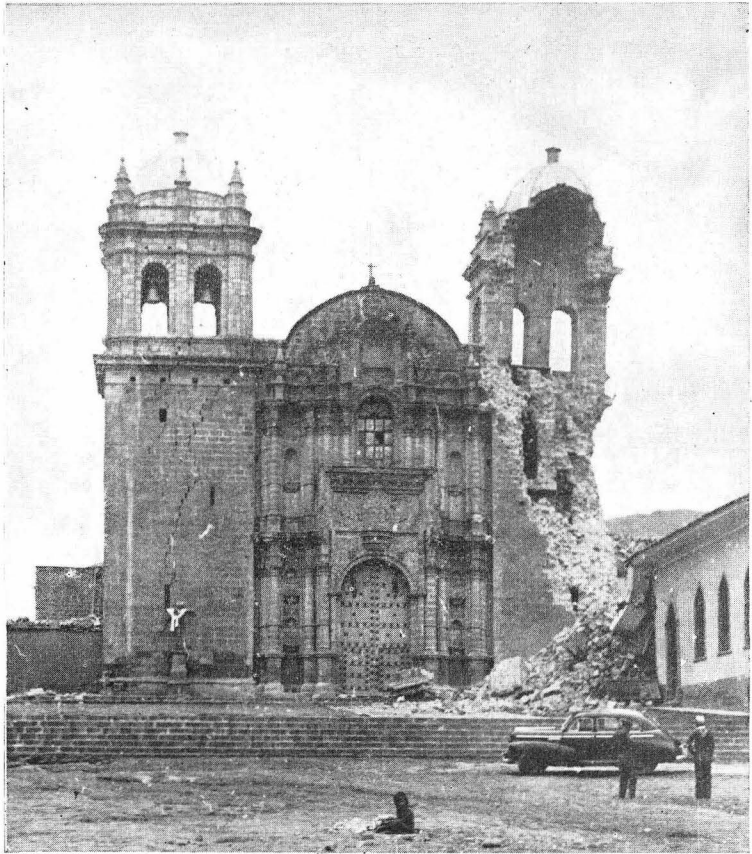
Foto 3. Iglesia de Belén; el campanario oeste se derrumbó durante el temblor.
