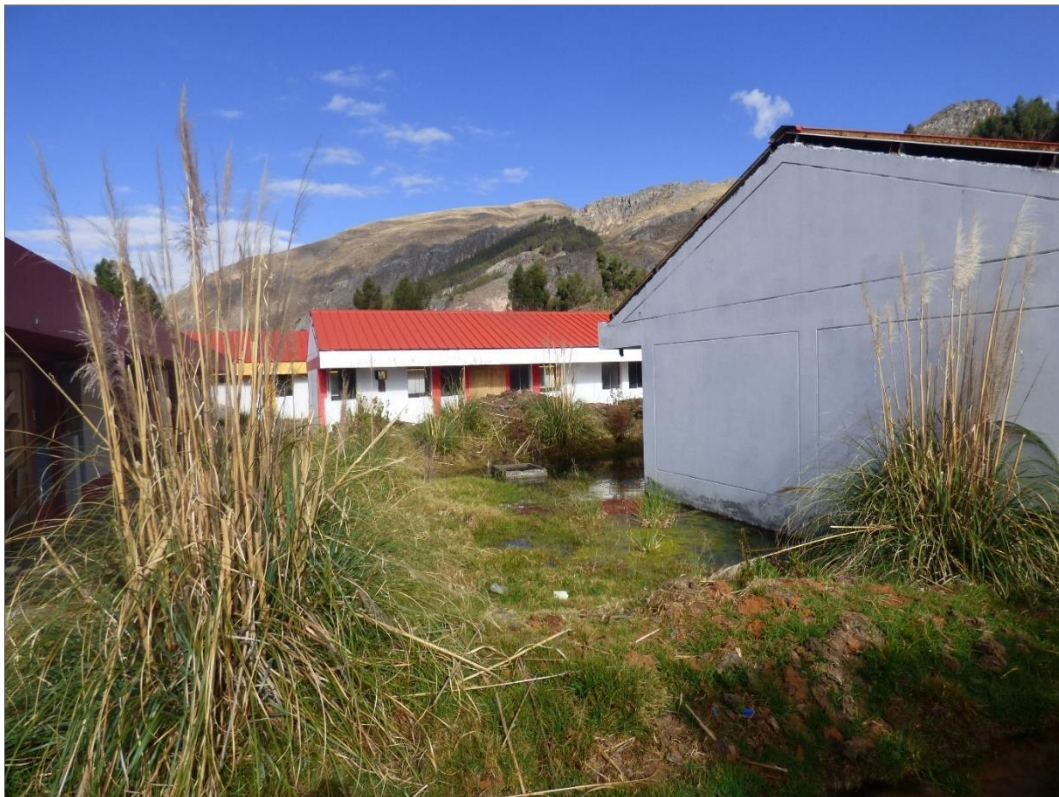
Fotografía 4. Vista de la Facultad de Educación inundada debido a la presencia de manantiales cercanos.
