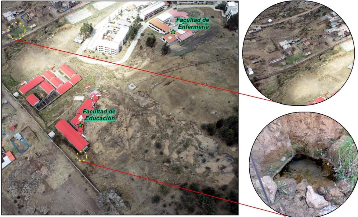
Figura 9. Vista de la acumulación de agua al pie de la ladera, parte de estas aguas se canalizaron y discurrieron en dirección sur, inundando la infraestructura de la Facultad de Educación, aguas abajo de este se infiltra sobre el terreno. Según mencionan los pobladores, a partir de un movimiento sísmico, acontecido el año 2017, se evidenció la surgencia del manantial ubicado en las coordenadas 504615, 8587471.
