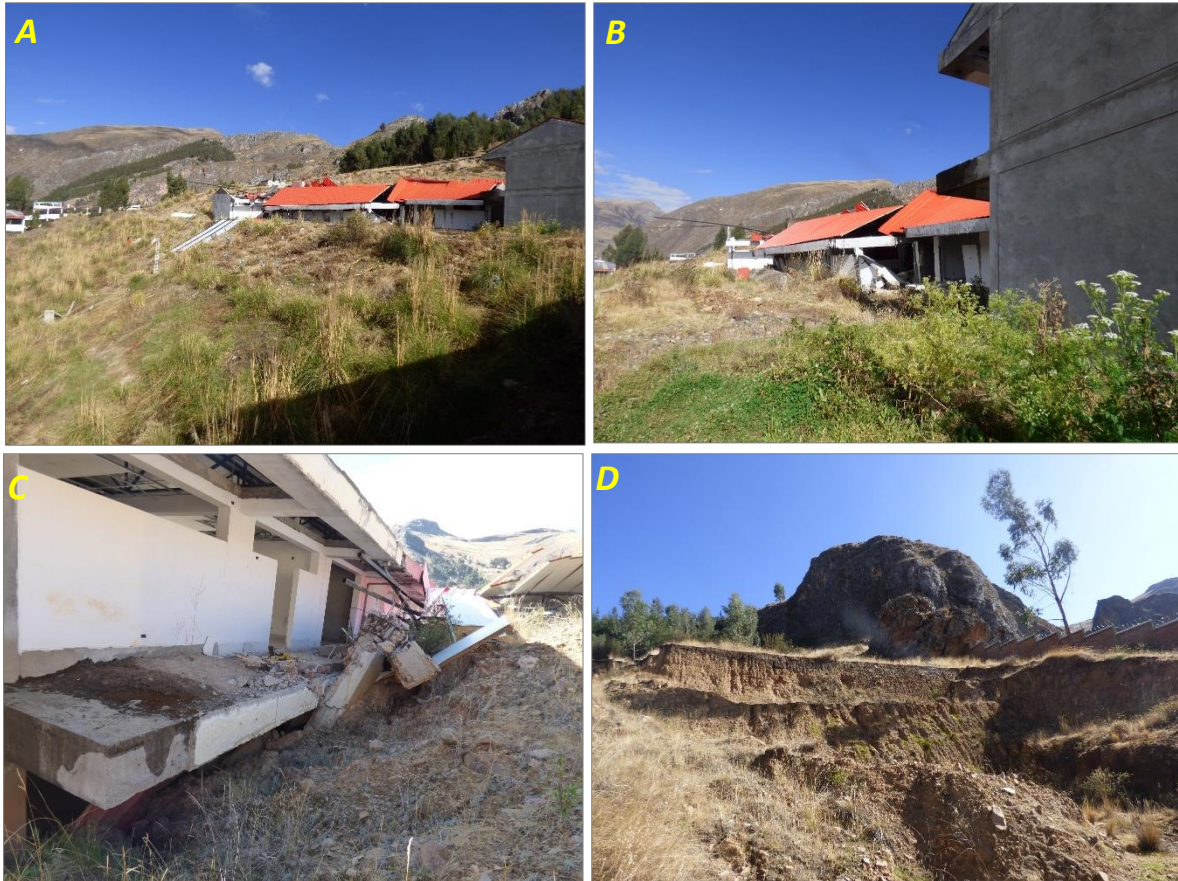
Figura 8. Suelo conformado por bloques, cantos, gravas y gravillas, en matriz areno arcillo limoso y una capa de suelo orgánico.
