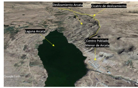
► Fig. 11 Deslizamiento Arcata.
