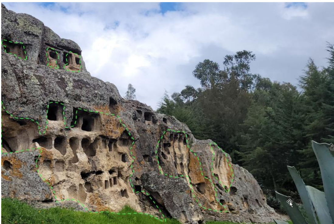
Figura 20. Zonas de moderadamente hasta altamente meteorizadas, con erosión pluvial y eólica en el centro del frontis de las Ventanillas de Otuzco (líneas discontinuas de color verde).
