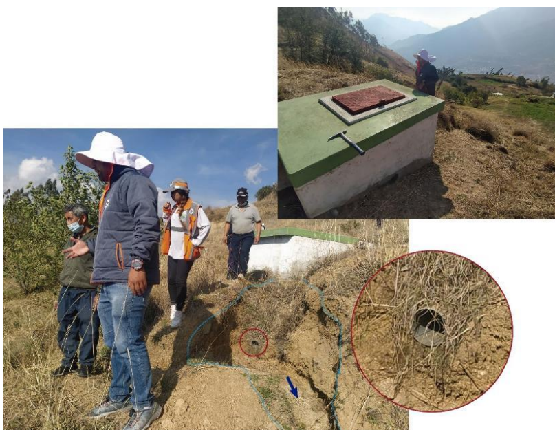
Figura 14. Captación de agua y rebalse de este.
