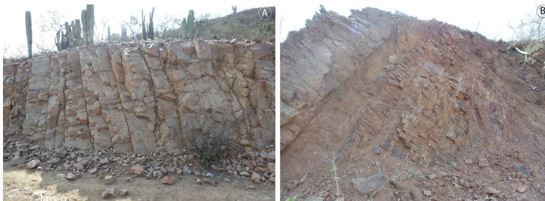
Figura 3.14 A y B) Arenisca cuarzosa masiva muy fracturada. Vista tomada en el punto (UTM 669057, 9266901), mirando al NO del reservorio de Tinajones, donde muestra secuencias masivas de areniscas cuarzosas.
