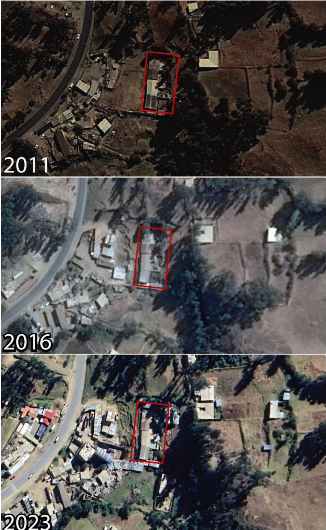
Figura 30. Variación de la ladera por corte del talud en el caserío Lactash (fuente Google Earth)
