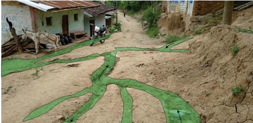
Figura 15. Cárcavas que afectan viviendas, Calle Tupac Amaru, coordenadas: 9434821 N y 629443E).
