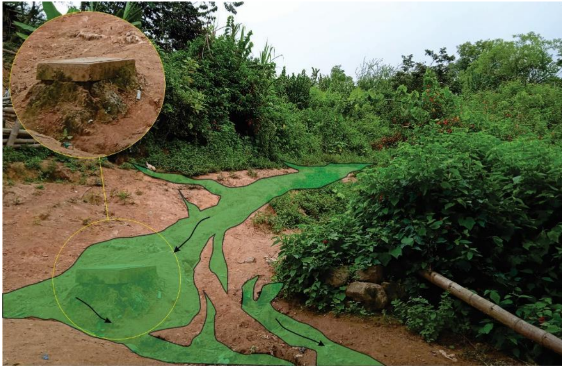
Figura 11. Cárcavas que afectan viviendas, buzones y cajas de distribución de agua, Ca. Palmeras, coordenadas: 9435015 N y 629358E).
