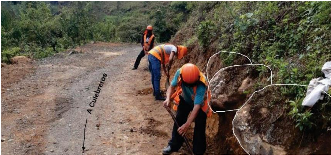
Figura 6. Depósitos de deslizamientos en la vía de acceso a Culebreros, coordenadas 9434992N y 628722E.
