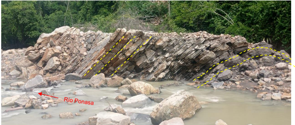
Figura 7. Areniscas y limolitas de la Formación Vivian, se muestran plegadas y muy fracturadas.
