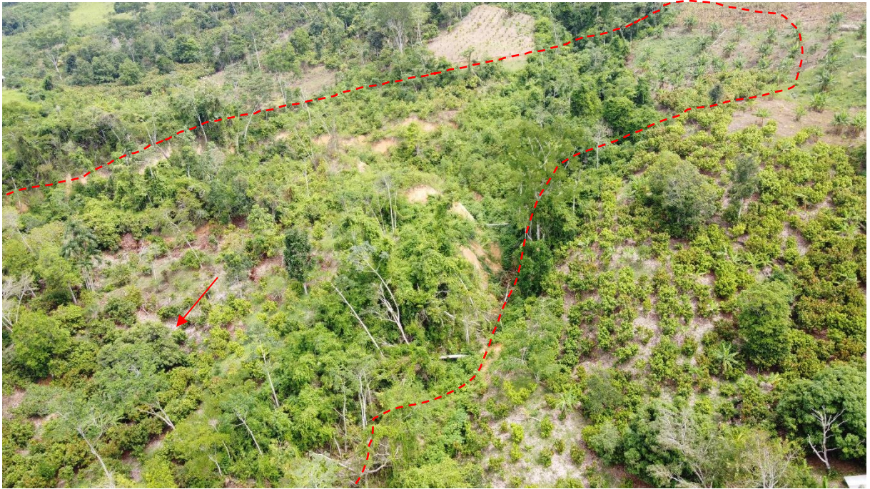
Figura 17. Masa deformada, con presencia de grietas transversales.
