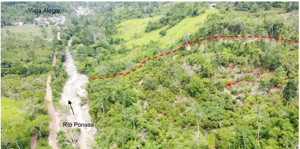
Figura 15. Escarpa lateral derecha y parte de la masa deslizada.
