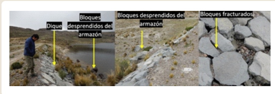
► Fig. 14 Dique de la represa Huisca Huisca.
