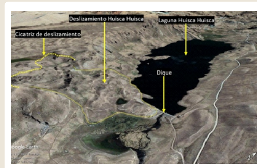
► Fig. 13 Deslizamiento Huisca Huisca.
