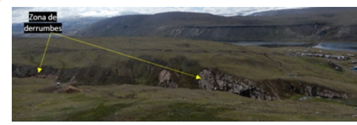
► Fig. 9 Derrumbes en Arcata.
