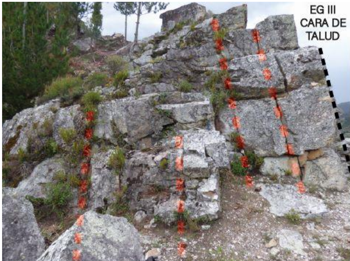
Figura 7: En la cara del macizo se observa el paralelismo de la estratificación con la cara del talud.
