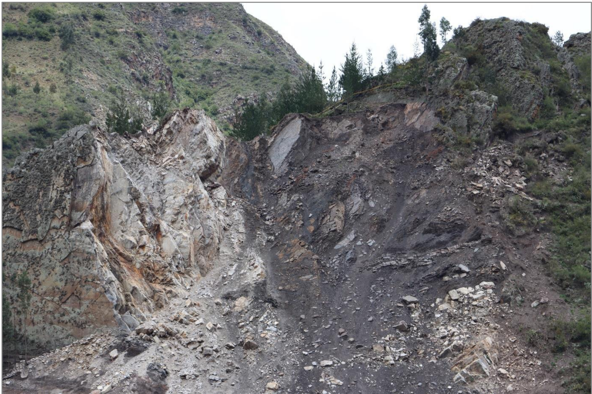
Fotografía 2: Vista de rotura tipo cuña en la ladera del cerro Cruz de Shallapa.
