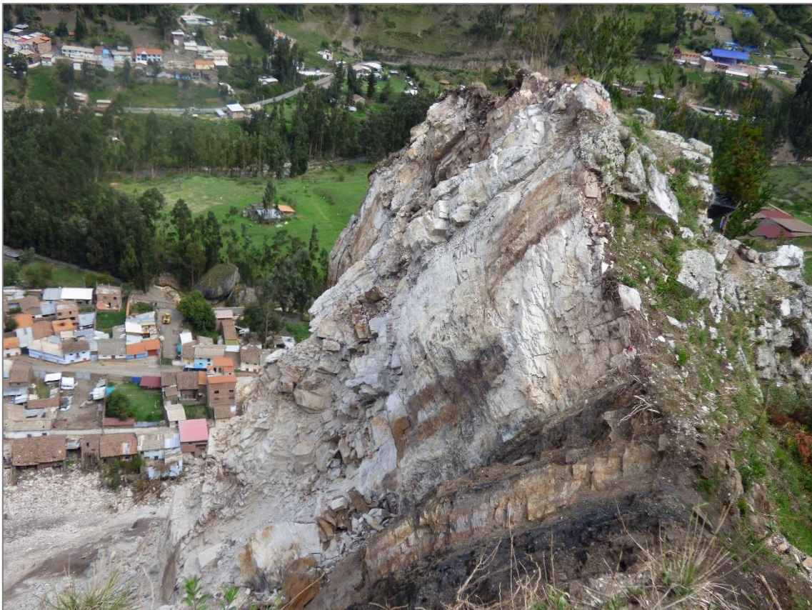
Fotografía 1. Areniscas intercaladas con lutitas y limolitas muy fracturadas.
