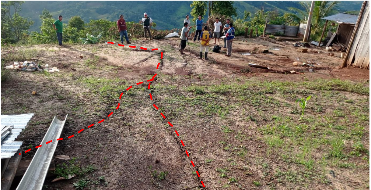
Figura 15. Grietas de tensión en el cuerpo del deslizamiento N°02. Estas presentan una abertura de 0.10 m y profundidad de 0.20 m.
