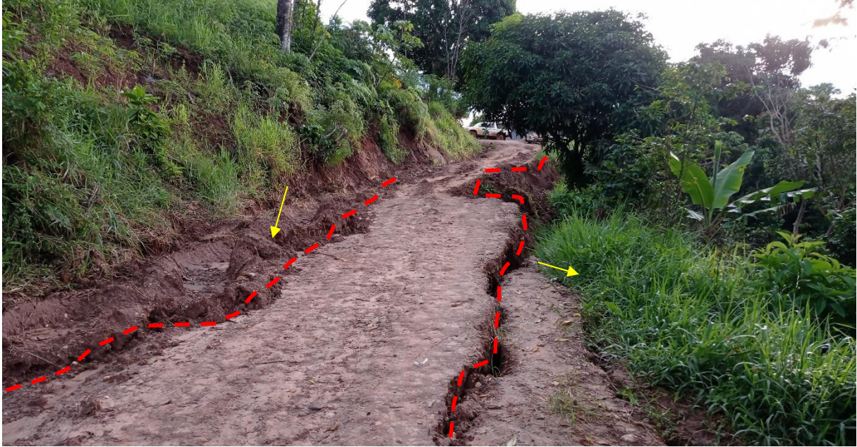
Figura 12. Acceso destruido por el deslizamiento N°01. Presencia de grietas transversales, con una apertura de 0.60 m y una profundidad de 1.50 m
