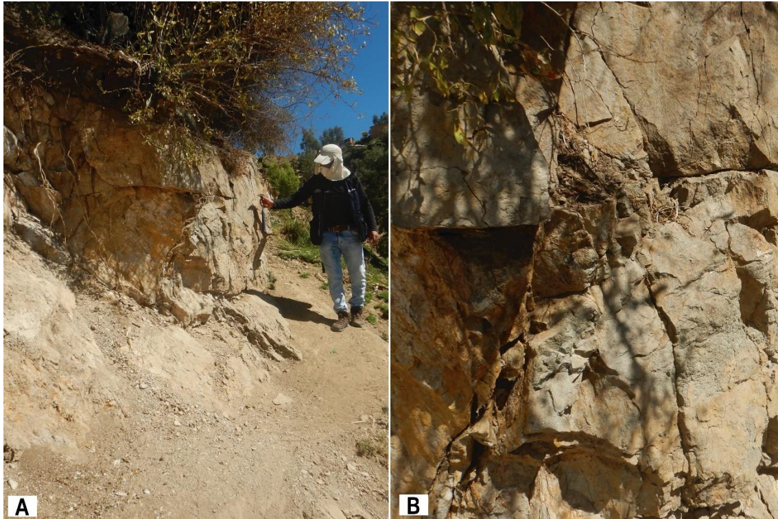
Figura 2: A. Sustrato rocoso conformado por rocas piroclásticas de composición andesítica, del Grupo Calipuy. B. Detalle de las rocas piroclásticas las cuales se encuentran muy fracturadas, con espaciamentos muy próximas entre sí (0.05-0.03 m), abiertas (1,0-5,0 mm) y en superficie se presentan muy alterados y altamente meteorizado. Fuente: Núñez & Sosa, 2022.
