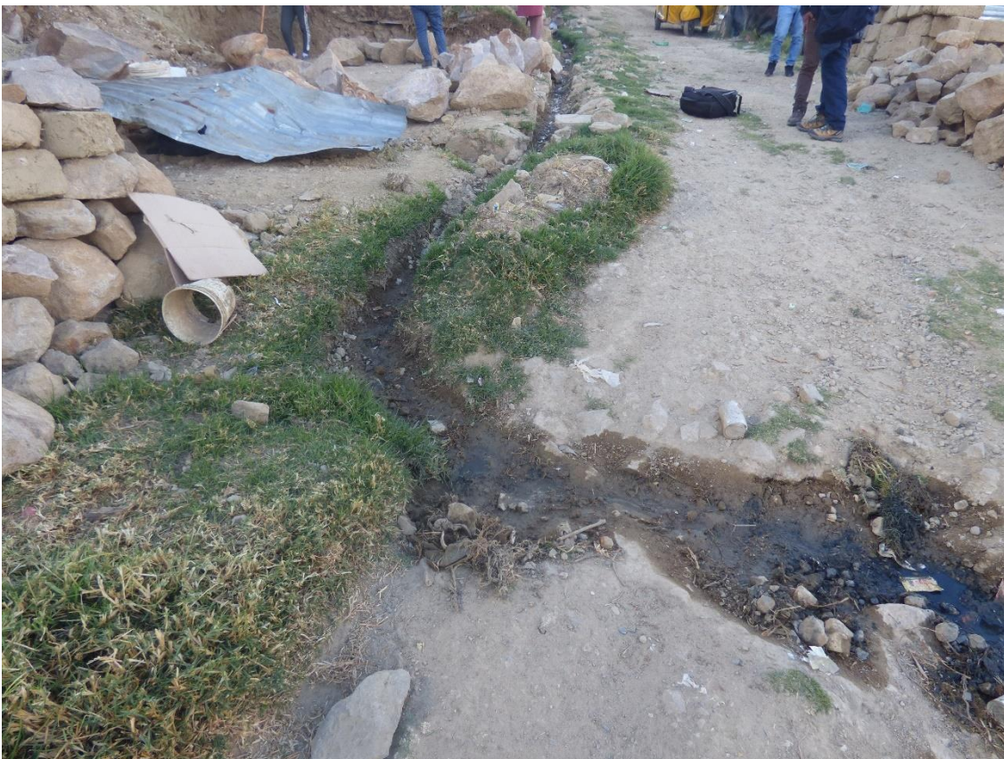
Fotografía 6: Canales de regadío sin revestir, que sobresaturan el terreno.
