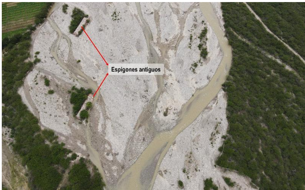
Figura 17. Espigones antiguos que actualmente se ubican dentro del cauce del río Chimín y ya no cumplen su función de contención de avenidas. Ubicación: E: 809447, N: 9166115.
