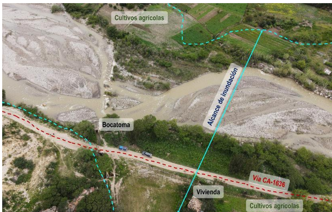
Figura 13. Lugar del perfil B-B', donde se aprecia a la vía vecinal CA-1636, una vivienda, una bocatoma y cultivos susceptibles a inundación fluvial. Ubicación: E: 810811, N: 9166306.
