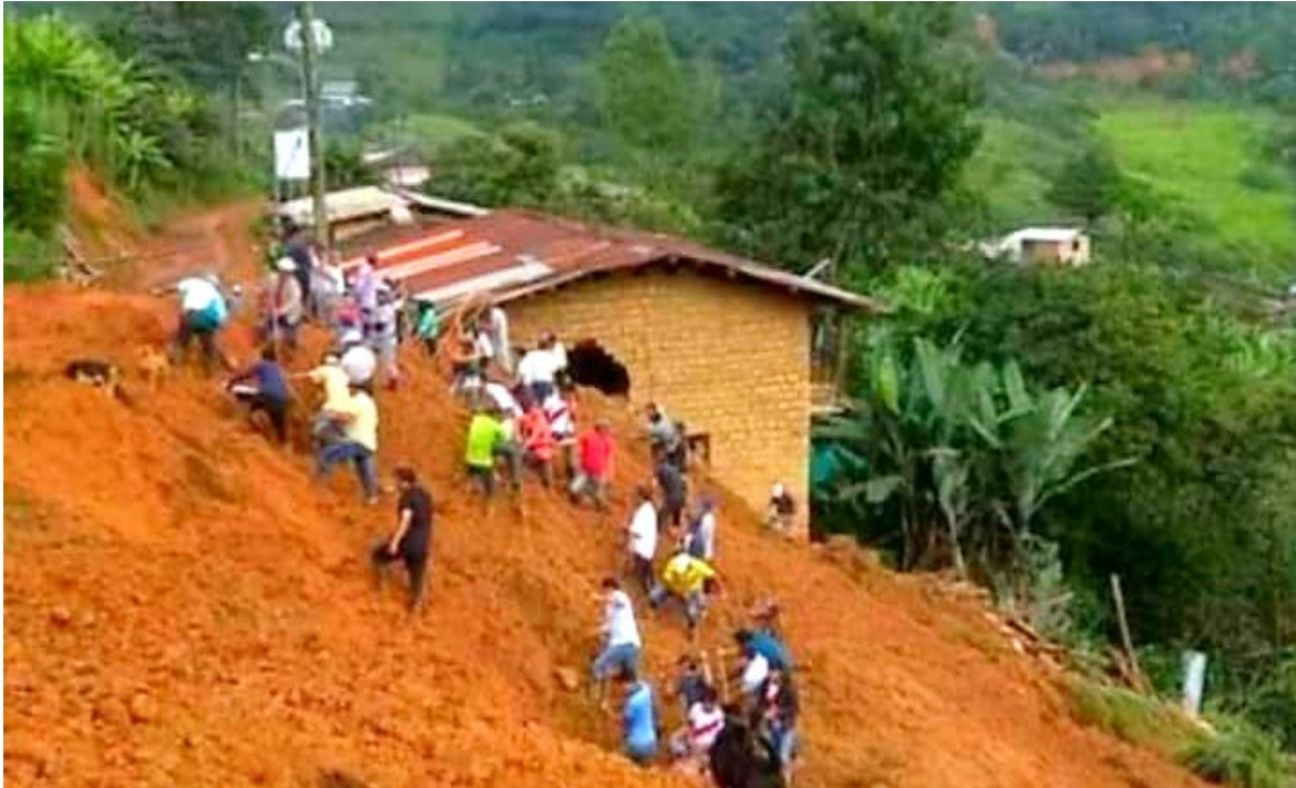
Figura 25. Tramo de 45 m de largo de la trocha carrozable afectada. Fuente: INDECI-Ayabaca.
