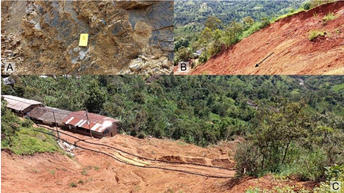
Figura 18. A. Rocas fuertemente fracturadas. B. Estrías de desplazamiento. C. Trocha carrozable afectada ubicada en el cuerpo del deslizamiento.
