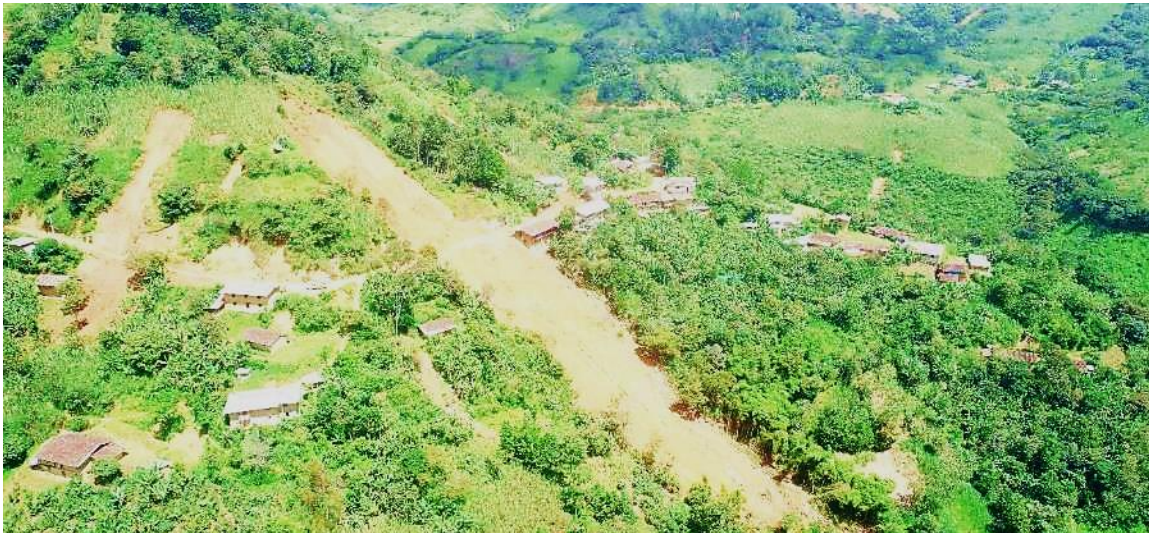
Fotografía 5. Vista de los depósitos coluviales originadas por el deslizamiento en el CP. Ambasal.
