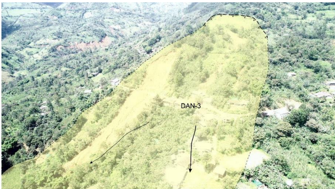
Figura 13. Vista aérea del deslizamiento antiguo (DAN-3).
