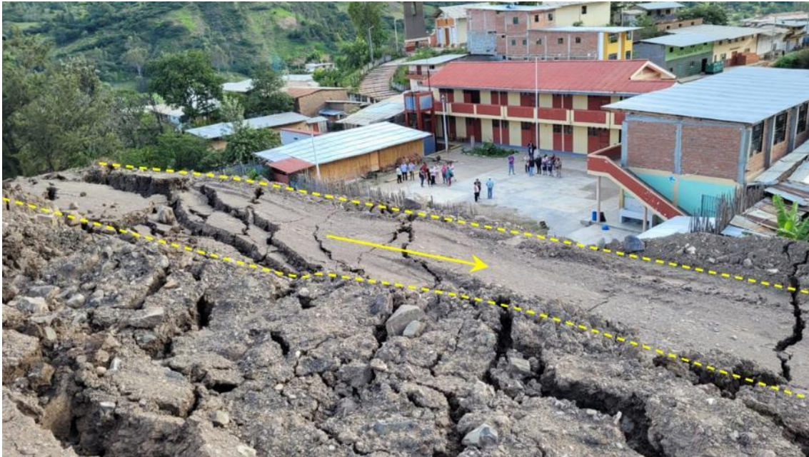
Figura 15. Grietas afectan trocha carrozable de ingreso a la localidad de Sallique. Coordenadas UTM WS-84 -17S, Norte: 9374221 – Este: 686490.
