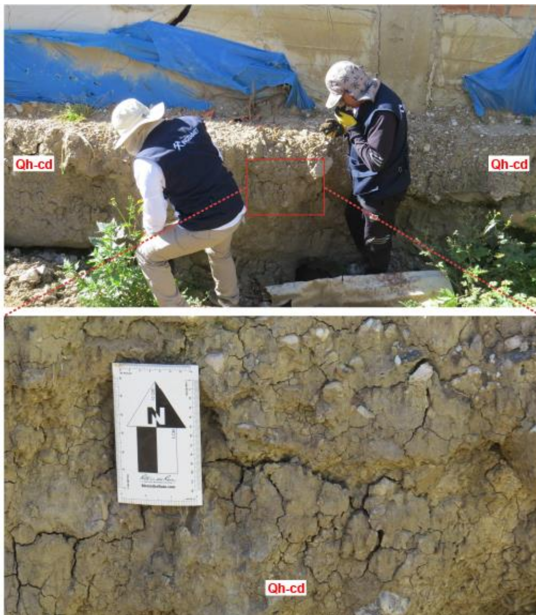
Fotografía 3. Ventana a detalle de material coluvio-deluvial. Las casas colapsadas se encuentran ubicadas en este tipo de material.
