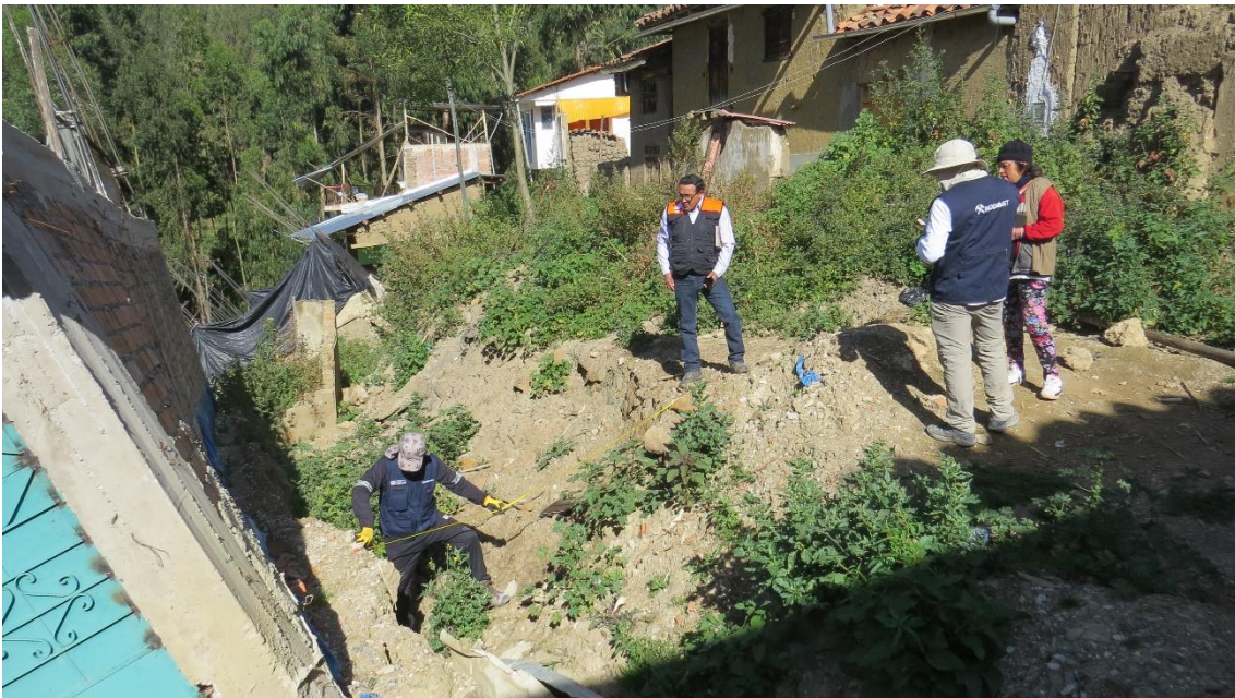
Fotografía 12. Se aprecia el escarpe principal del deslizamiento.
