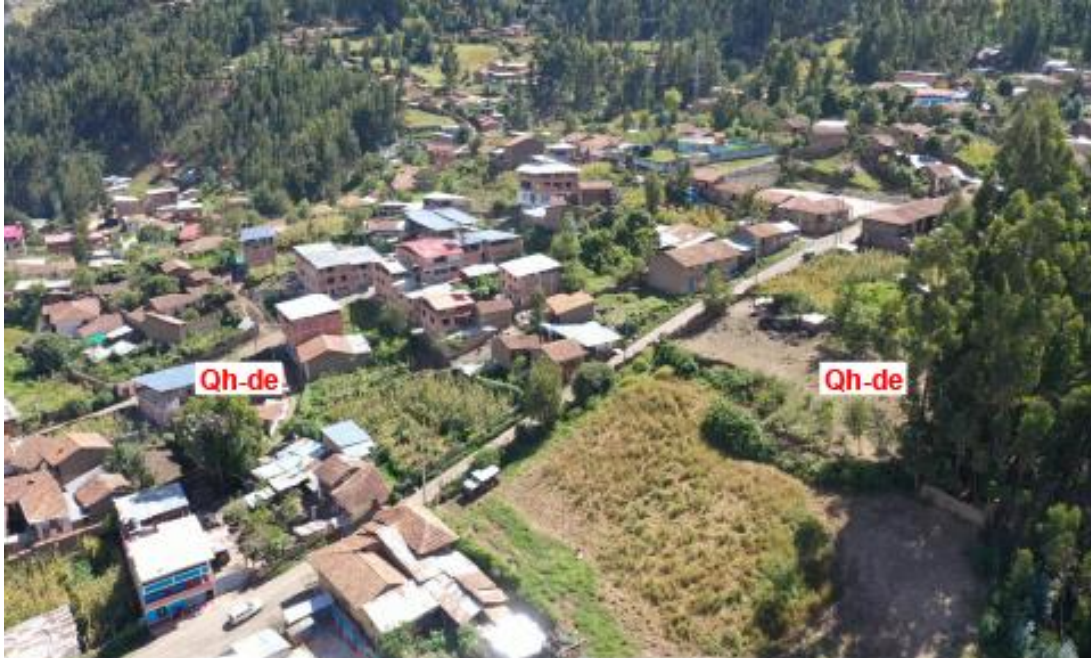
Fotografía 4. Vista aérea donde se observa que el distrito de Pomabamba está ubicado en un depósito deluvial efecto de la erosión de la montaña del flanco Este, la pendiente menor al 20%, el material que lo compone y la morfología develan el tipo de suelo de la localidad.
