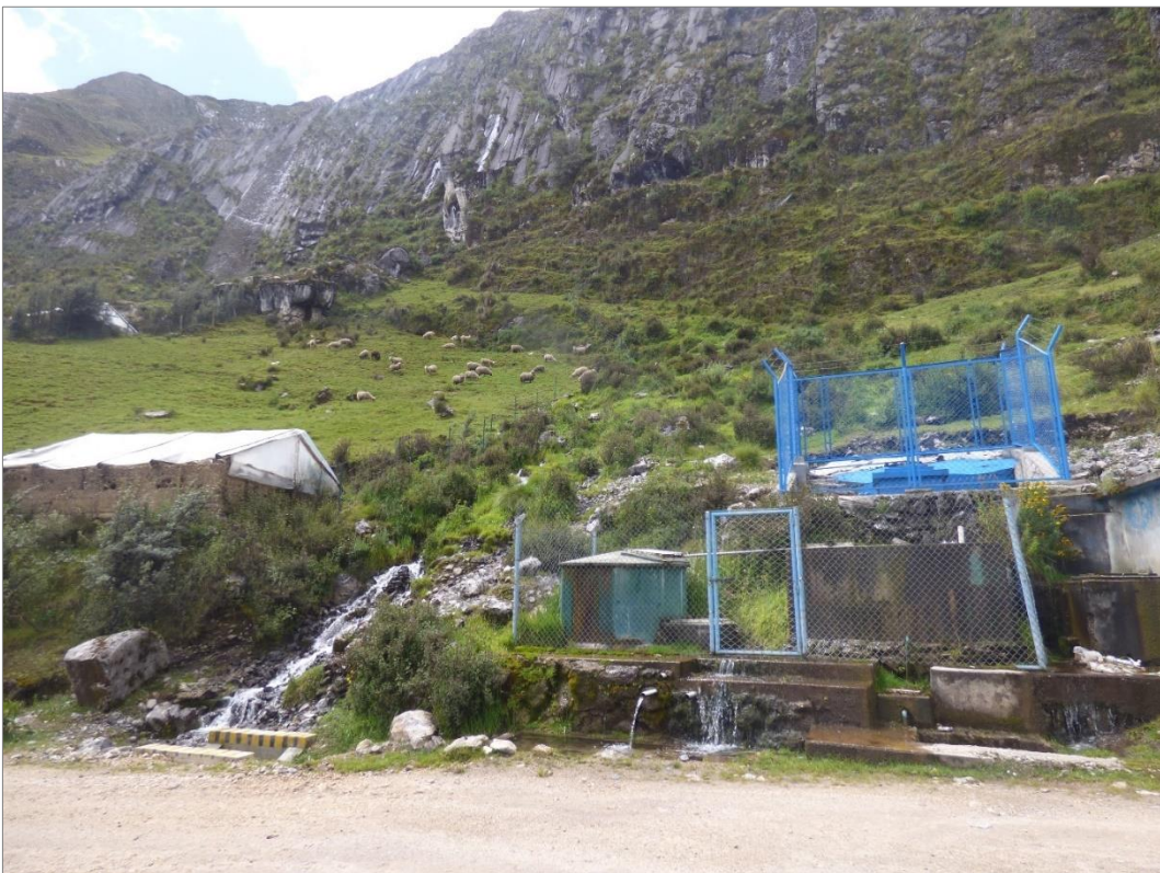
Fotografía 8. Desde la ladera noreste que delimita Chipta, en temporada de lluvias desciende bastante cantidad de agua que atraviesa el sector referido, lo que podría contribuir en la saturación e inestabilidad del terreno.
