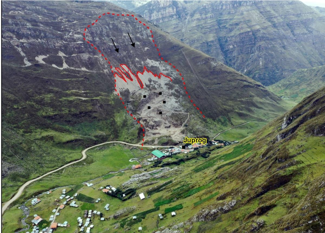
Figura 13. Vista del derrumbe al suroeste del sector Juprog. En líneas rojas entrecortadas se aprecia el evento antiguo y en líneas continuas el evento reactivado. Se observan cortes de talud que estarían inestabilizando el derrumbe.
