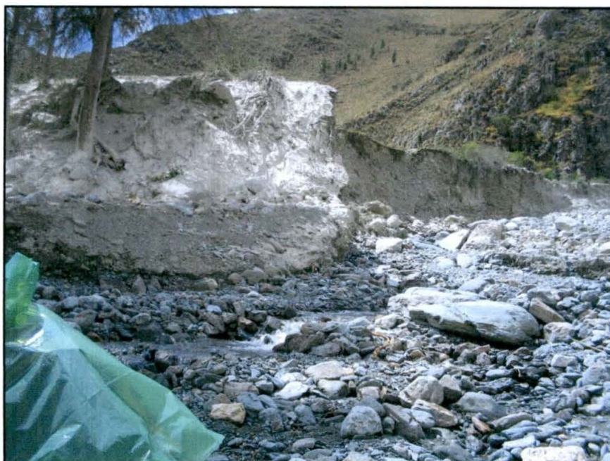
Foto 17: Margen derecha de la Quebrada Runtumayo, se observa la erosión así como la altura y desborde de los flujos del aluvión
