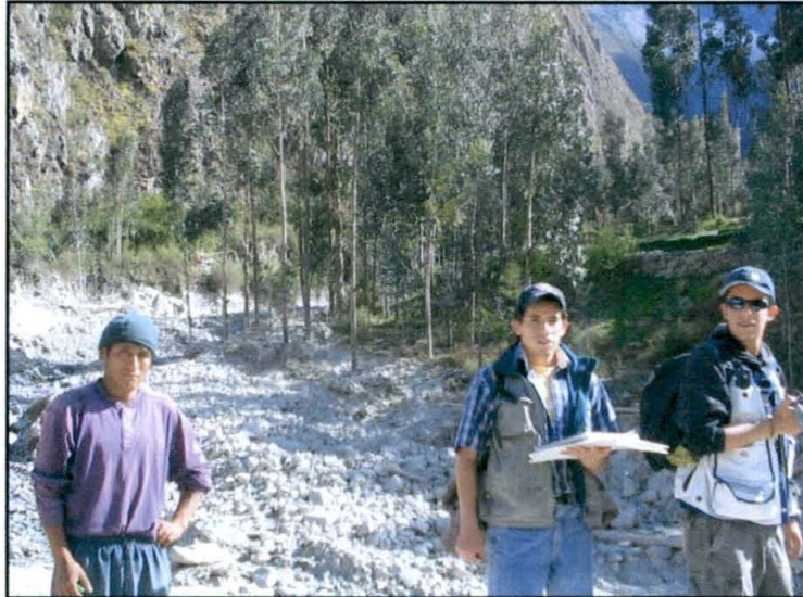
Foto 14: Margen izquierda de la Quebrada Runtumayo, se observa plantaciones de eucaliptos, algunos fueron destruidos.
