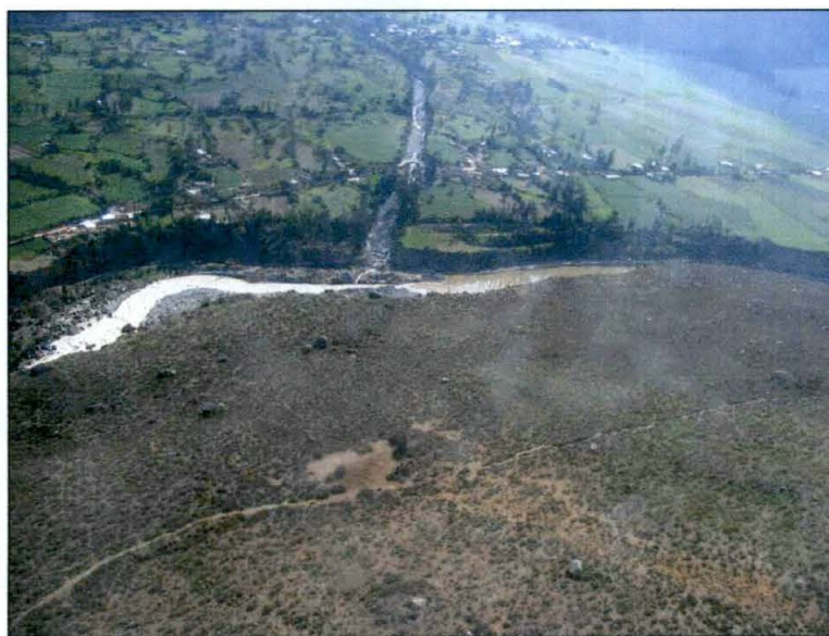
Foto 3: Vista aérea mostrando la desembocadura de la Quebrada Runtumayo en el Vilcanota. Además se aprecia el cono aluvial con agricultura.
