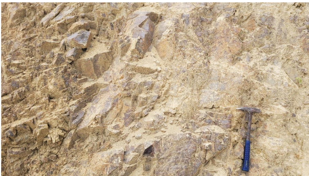
Fotografía 1: Talud donde se observa el macizo de composición andesítica, muy fracturado y altamente meteorizado. Coordenada UTM WGS-84, 17S: E: 737396; N: 9309138.
