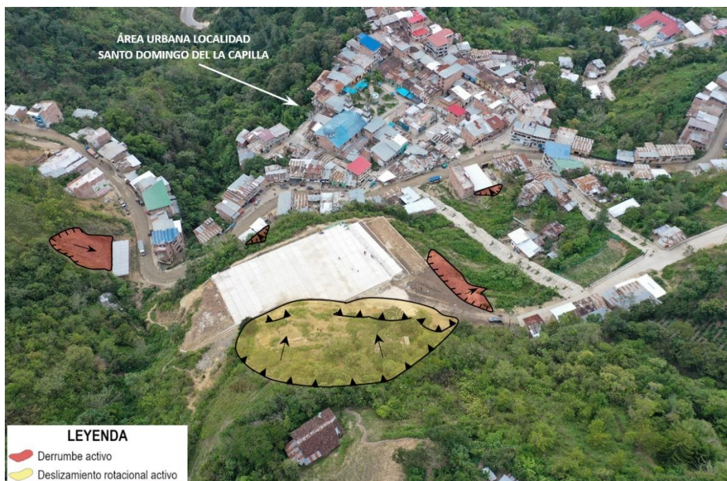
Figura 6. Vista panorámica del deslizamiento, en la parte baja se puede apreciar la plataforma de concreto construida con fines de funcionamiento de mercado local; así mismo las viviendas expuestas al peligro por deslizamiento. Coordenadas UTM WS-84 -17S, Norte: 9309136 – Este: 737430.
