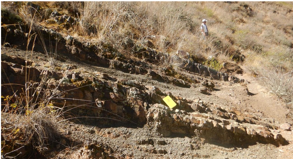
Fotografía 3. Vista de intercalación de areniscas con lutitas, que se encuentran fracturadas y moderadamente meteorizadas.
