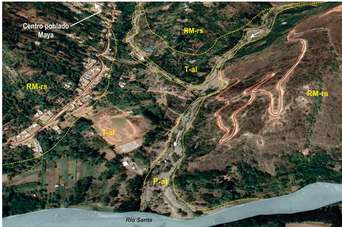
Figura 11. Vista panorámica de la subunidad de vertiente aluvio-torrencial (P-at) formado por la acumulación de material proluvial relacionado a flujos de detritos (huaicos). Es evidente que la geoforma de cono de deyección que presenta la quebrada Punyarure que ha represado en algún tiempo atrás al río Santa.
