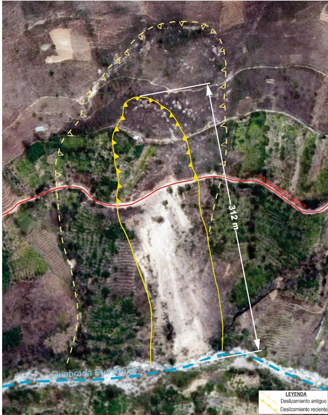
Figura 12. Vista panorámica del deslizamiento, se aprecia la reactivación del deslizamiento con línea continua amarillo intenso, así como el deslizamiento antiguo con líneas entrecortadas. Ubicado en la margen izquierda de la quebrada Punyarure.
