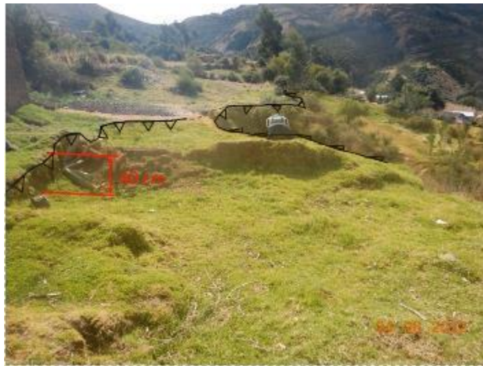
Figura 4: Escarpas de deslizamientos activados el año 2011.
