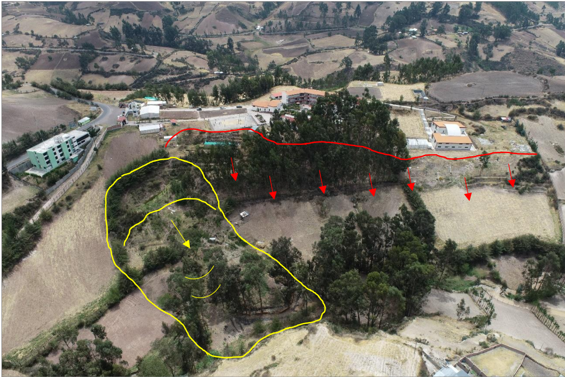
Figura 9. Vista del deslizamiento reactivado el año 2007, presenta un salto de 1.50 m, 40 m de ancho en la zona media y aproximadamente 110 m entre la corona y pie del evento, que destruyó una infraestructura metálica.
