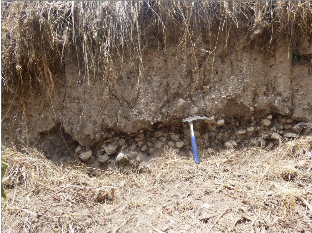
Fotografía 3. Presenta estructura masiva y textura arenoso. Son suelos inestables, presentan malas características geotécnicas y se consideran no competentes, susceptibles a la generación de movimientos en masa.
