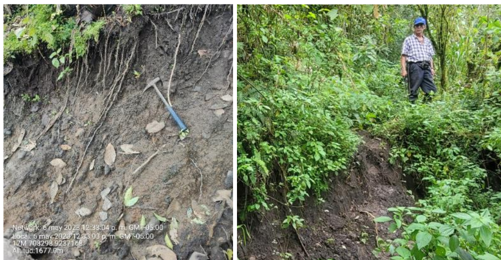
Figura 10. Vista de los dos escarpes del deslizamiento DRA1, el de mayor salto vertical (izquierda) se ubica en la parte media, el menor (derecha) se ubica en la parte alta.
