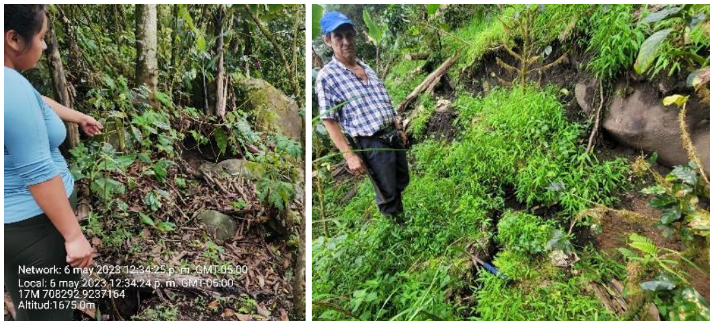
Figura 12. Bloques rocosos ubicados dentro del cuerpo del deslizamiento.
