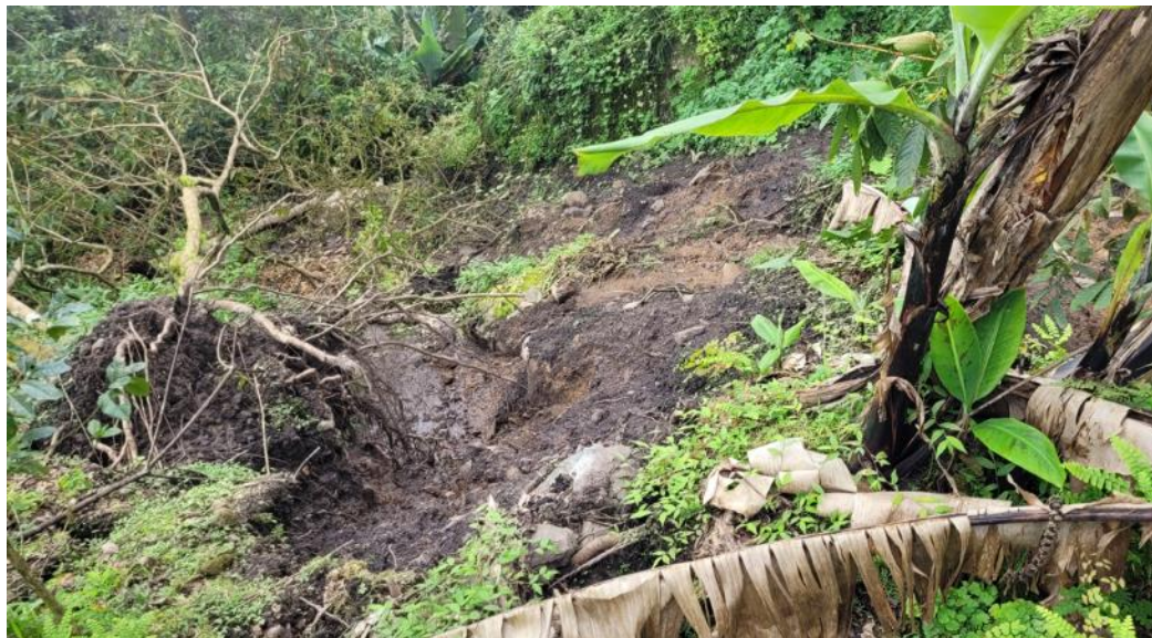
Fotografía 2. Suelos coluvio deluviales compuestos por limos y arcillas ubicados en los sectores con movimientos en masa. Coordenadas: E: 708308, N: 9237167.
