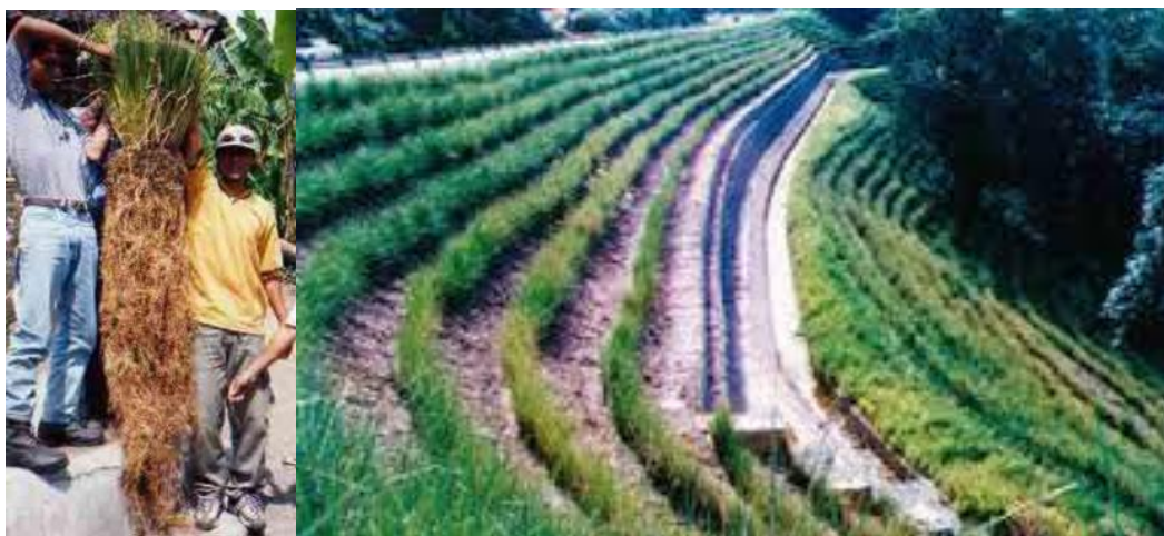
Fotografía 10. Ejemplo de bioingeniería con arbusto (vetiver) en taludes de materiales sueltos.
