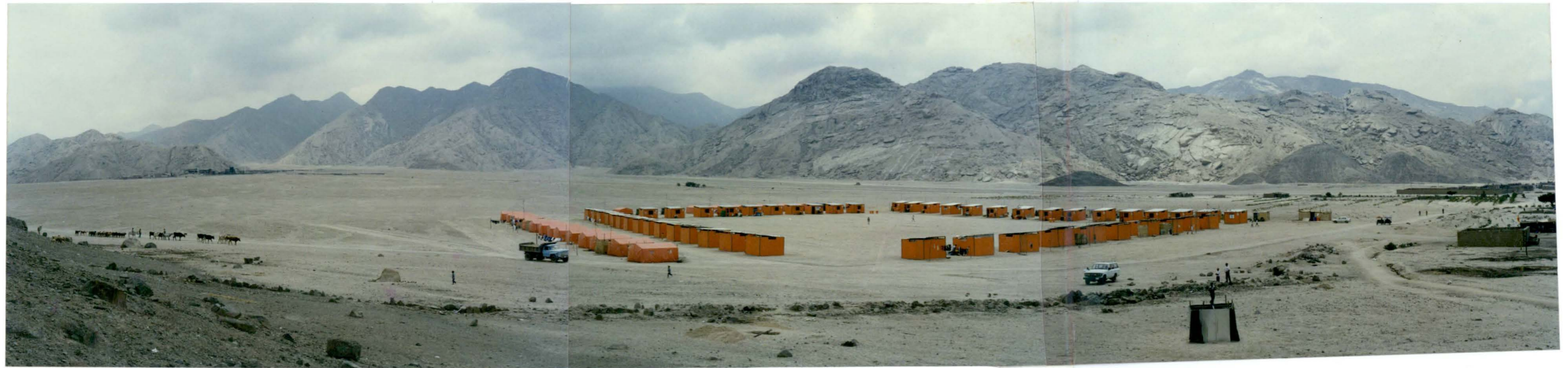
FOTO N° 9.- Vista panorámica del área de Santa Elvira de Chambara, sin huellas de haber sido afectado por fenómenos de geodinámica externa, que puedan comprometer su seguridad física. Instalación de módulos provisionales para los damnificados por el huayco.
