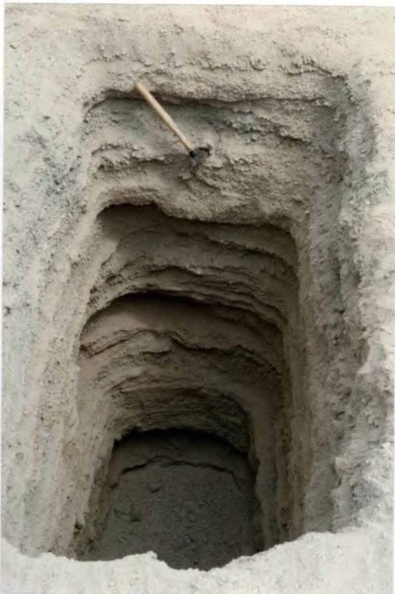
FOTO N° 8.- Suelo proluvial de gravas, arena y finos, que constituirá como terreno de fundación de Santa Elvira de Chambara.
