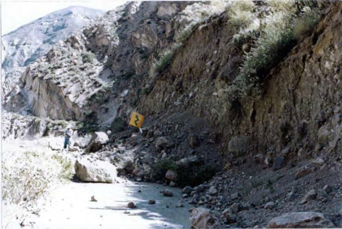
Foto N° 9: Derrumbe del talud de corte en depósitos proluviales medianamente consolidados.
