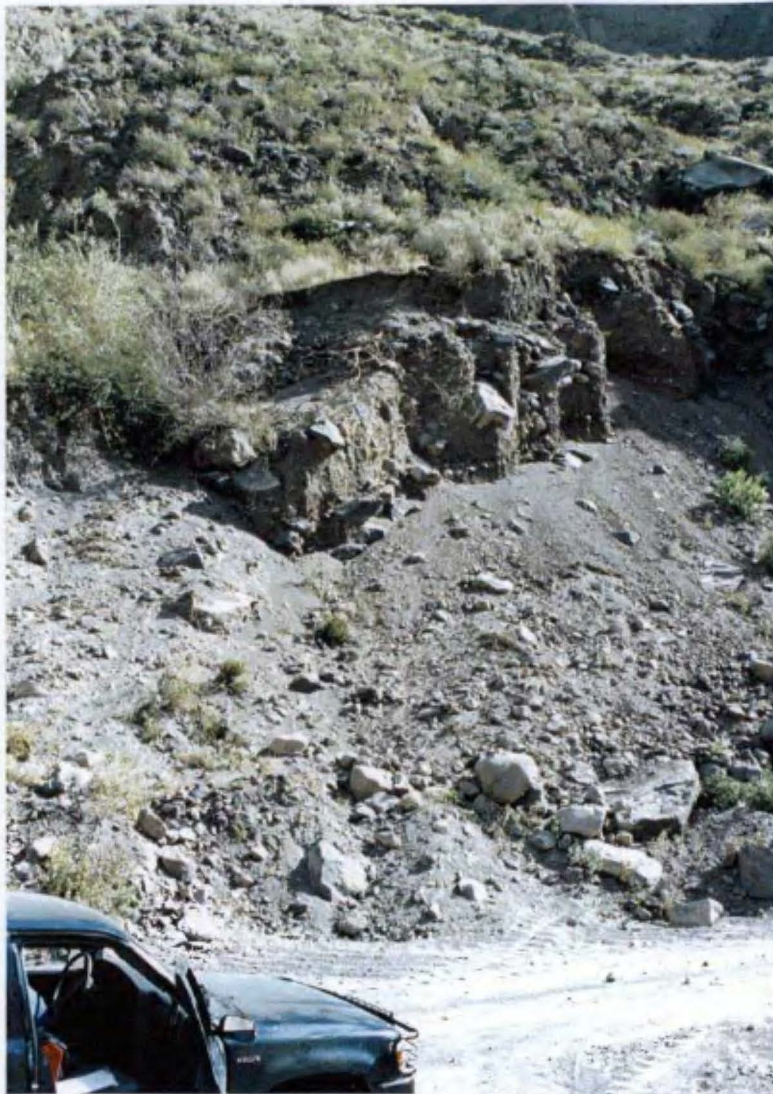
Foto N° 3: Asentamiento, producido por el sismo del 23/06/01, en depósitos coluviales y proluviales, que afectan el talud de corte de la carretera. Localizado cerca de la entrada de Charcani VI. Puede reactivarse.
