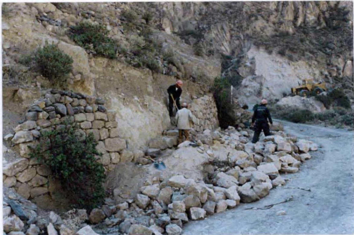
Foto N° 7: Colapso de muros secos (pircas de piedra), por el sismo del 23/06/01. Problema que afectó a la mayoría de los muros secos en la vía de acceso a Charcani V.
