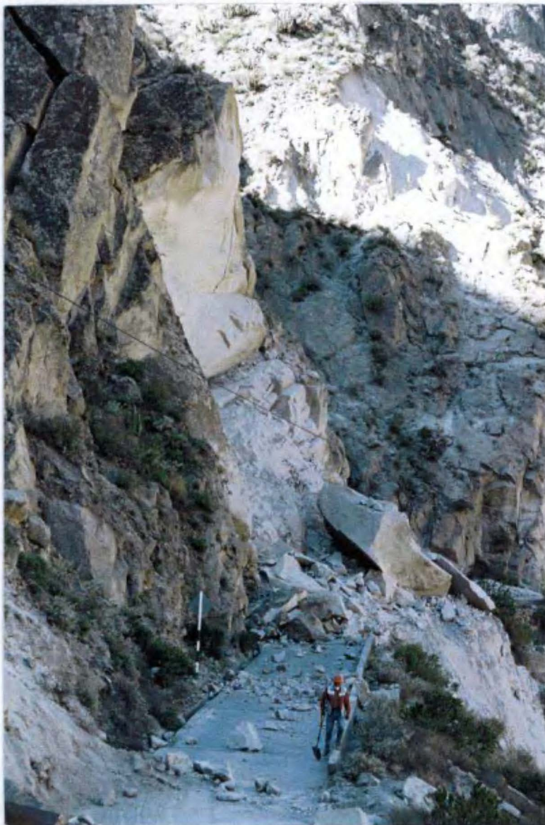
Foto N° 7: Colapso de muros secos (pircas de piedra), por el sismo del 23/06/01. Problema que afectó a la mayoría de los muros secos en la vía de acceso a Charcani V.
