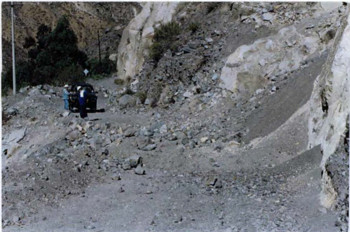
Foto N° 2: Derrumbe producido por el sismo del 23/06/01 y reactivado por la réplica del 05/07/01. Afecta la carretera afirmada que conduce a las instalaciones de las Centrales Hidroeléctricas de Charcani. Este derrumbe se produjo en depósitos coluviales y proluviales poco consolidados, que yacen sobre depósitos piroclásticos. Zona crítica.
