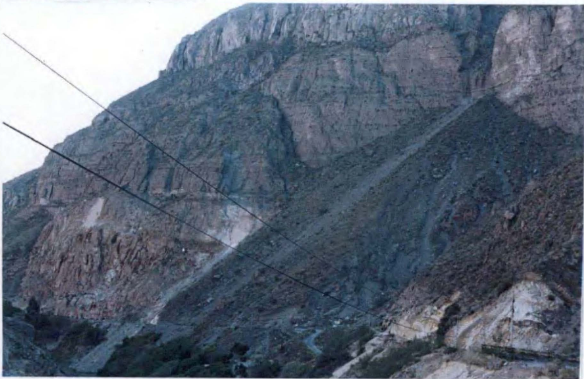
Foto N° 4: Aspectos morfoestructurales típicos de la margen derecha del río Chili. Se presentan rocas volcánicas (tobas) muy fracturadas (abiertas después del sismo), con taludes verticales de hasta 250 m de altura. Además se tienen depósitos coluviales y proluviales poco consolidados con taludes naturales de 45° de pendiente promedio. Zona inestable; a la izquierda se nota las huellas del derrumbe descrito en la Foto N° 2 (A).
