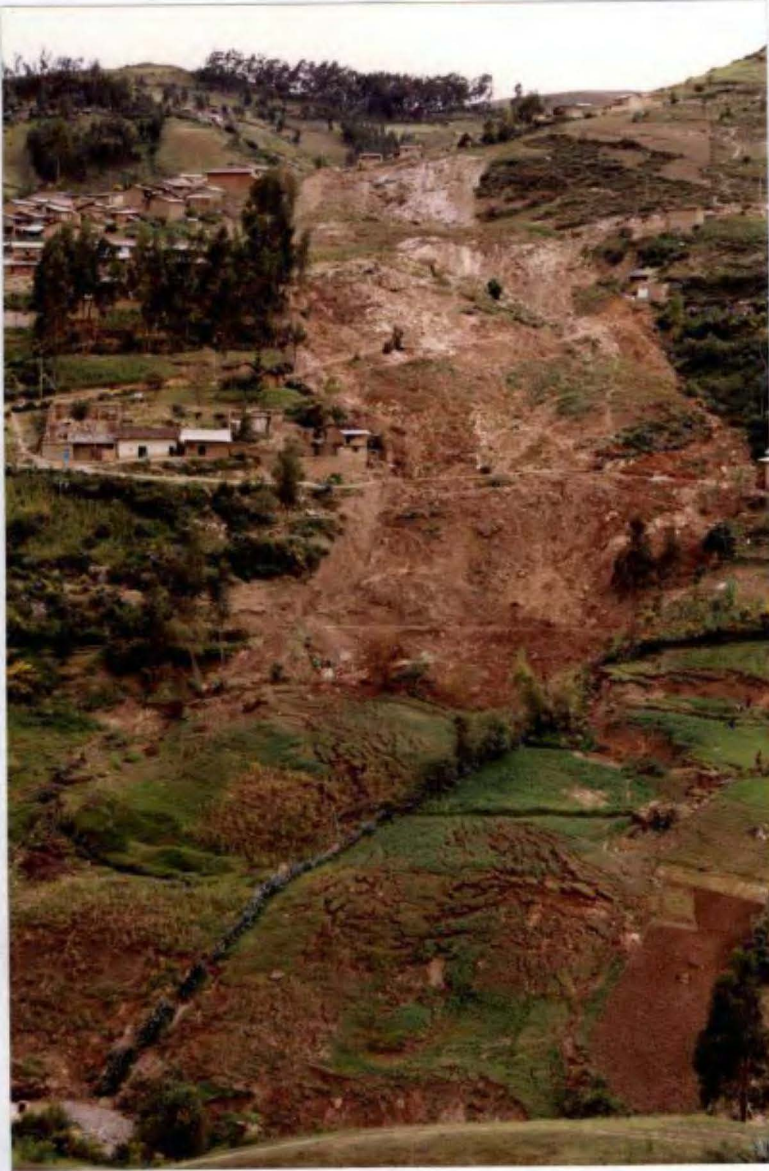
FOTO N° 1 Vista panorámica del deslizamiento activo en las laderas del Barrio Urubamba Sector 2, que destruyó viviendas, obras viales e infraestructura básica.
