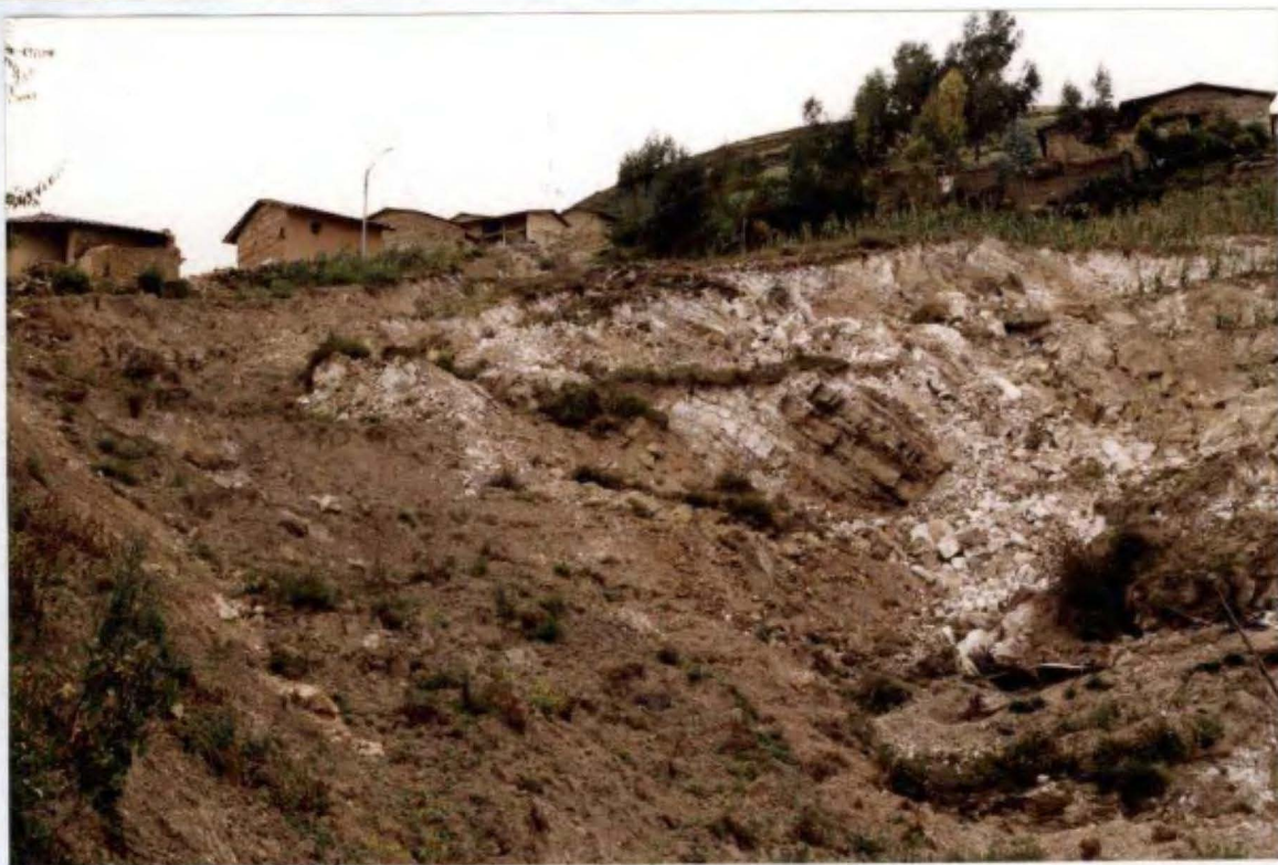
FOTO N° 2 Escarpas en la zona de arranque y corona del deslizamiento, en suelos inconsolidados y rocas muy fracturadas y alteradas.
