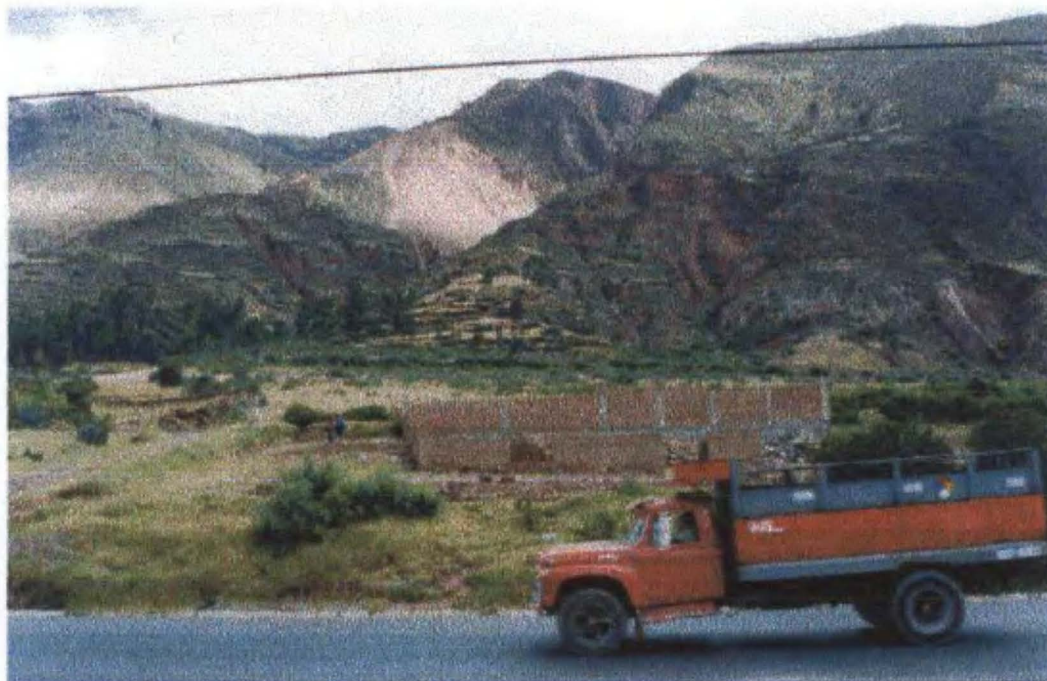
FOTO N°8.- Viviendas en construcción de material noble ubicadas en el cono de deyección de la quebrada Hatum Wayq'o, zona por donde podría desplazarse un nuevo huayco.
