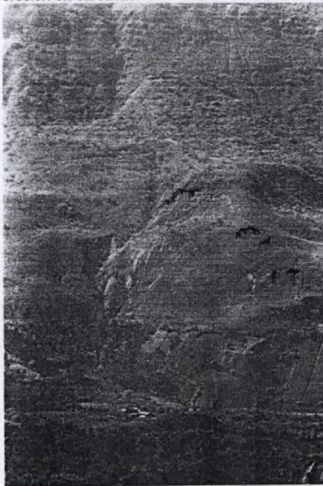
Foto N° 9 Vista panorámica de la localidad de Compín, donde se evidencian procesos geodinámicos de deslizamiento, derrumbe y erosión en cárcavas. ésta última en el lado derecho de la foto (2001), quebrada Compín.
