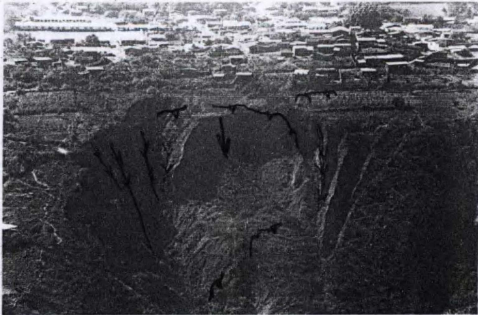
Foto N° 8 Vista del poblado de Compín, donde en su talud inferior se produjo un deslizamiento en 1998 que afectó un área importante de frutales, nótese igualmente el proceso de erosión en cárcavas.
