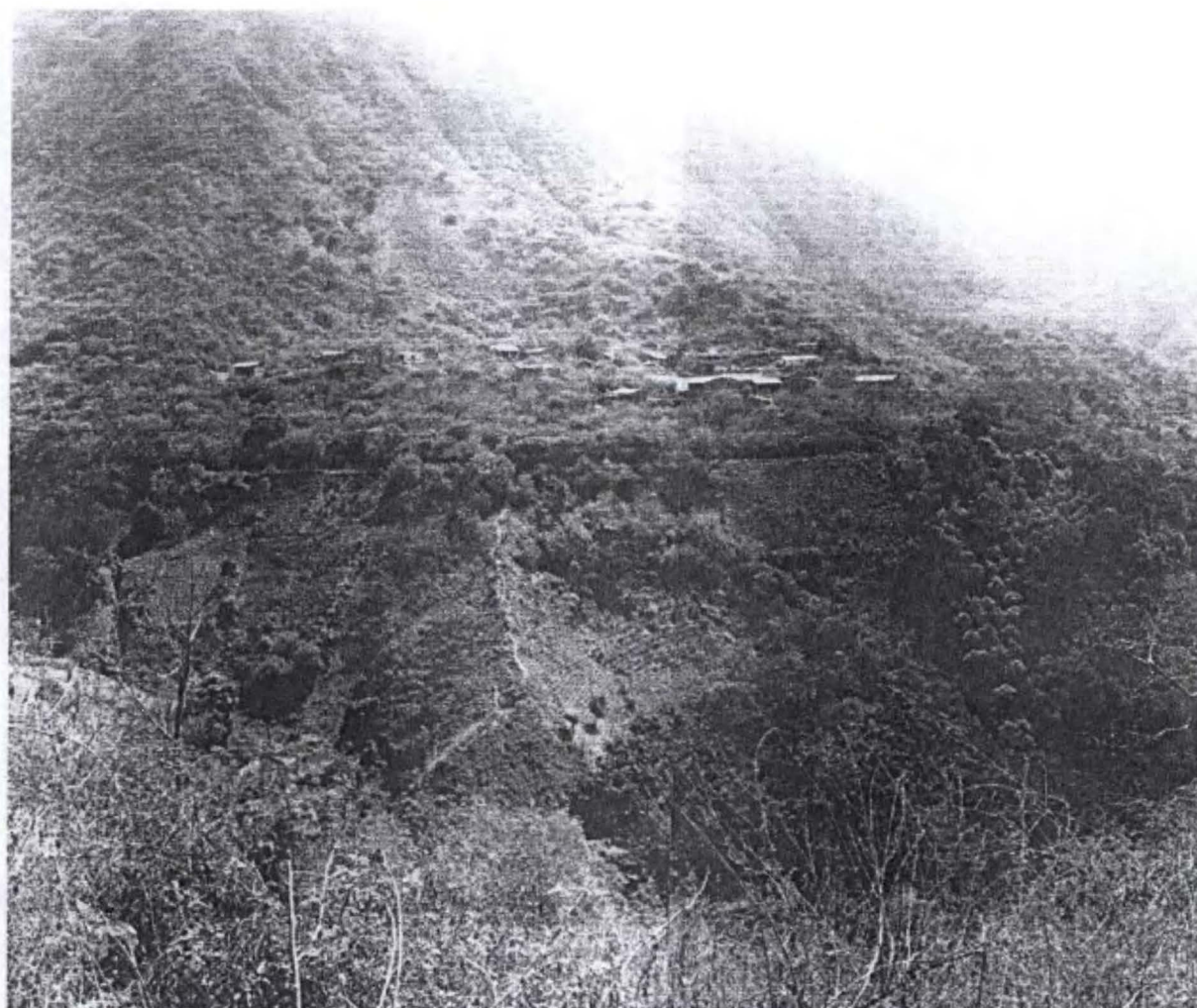
Foto N° 7 Vista de la ladera inferior del cerro El Arco, limitada por dos quebradas, lugar donde se asienta el caserío de La Laja y su área agrícola, en la que se tiene indicios del proceso de un deslizamiento. Nótese la forma de la ladera (cóncava en el lado izquierdo mostrando una escarpa reciente de deslizamiento, y convexa en el lado derecho, pendiente variable, suelo superficial. Se distingue también el canal de regadío que discurre por media ladera. Hacia la parte superior proceso de caída de rocas.
