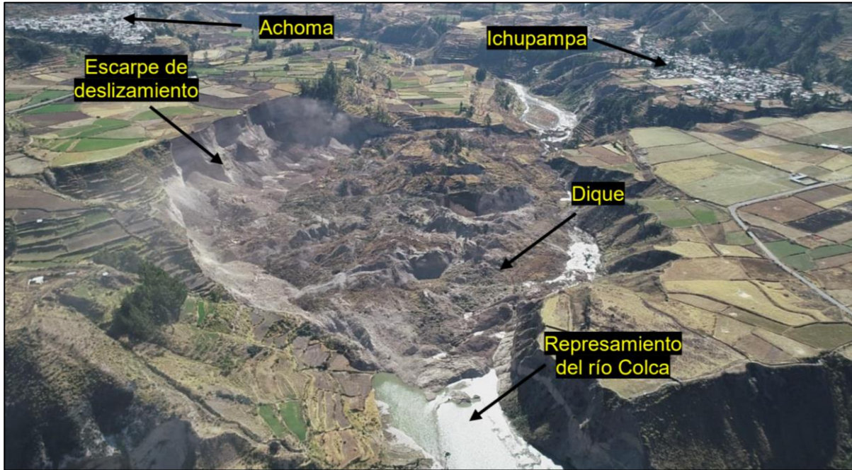
Figura 6. Vista al Noroeste donde se observa el deslizamiento de Achoma. (Informe técnico A7066 - INGEMMET)
