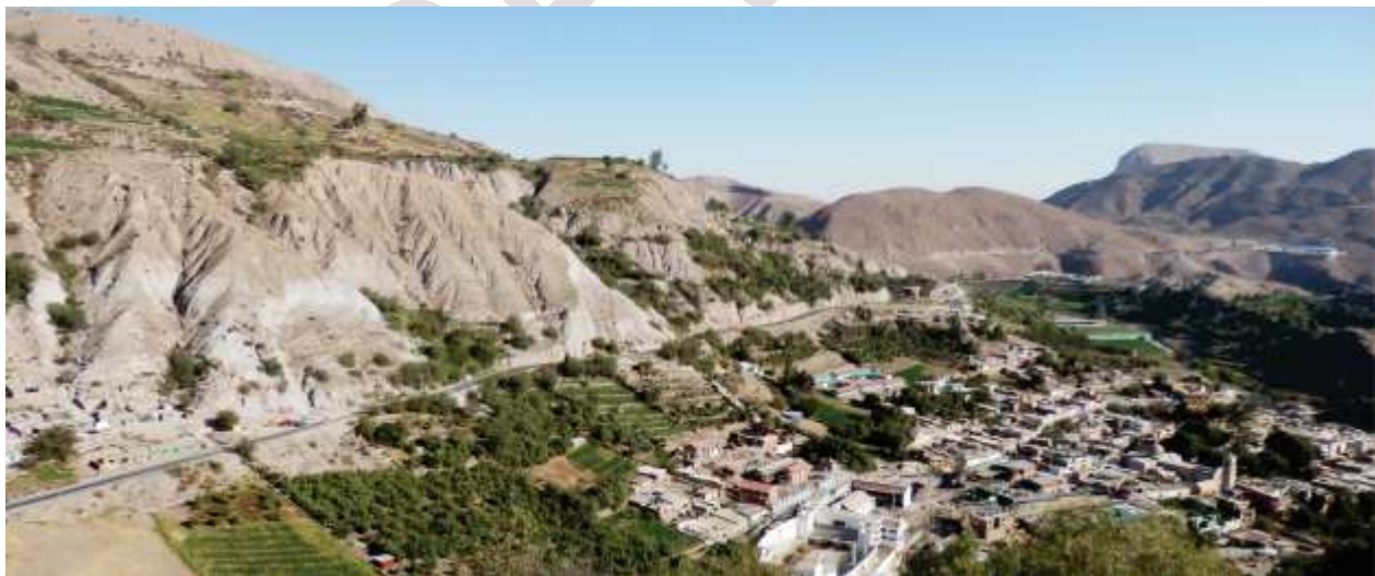
Fotografía 9.5 Erosión de laderas cruzan los poblados La Banda, Torata y la carretera Binacional.
