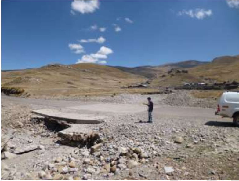
Fotografía 5.2 Quebrada que corta la carretera hacia Velille, en el sector de Tarucamarca.
