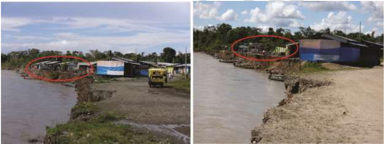
Figura 8.11 Vistas del sector Sarayacu, como producto de la erosión fluvial-inundación colapsaron 27 viviendas. La inundación llegó hasta el sector Virgen de la Candelaria, km 338 de la carretera Interoceánica.
