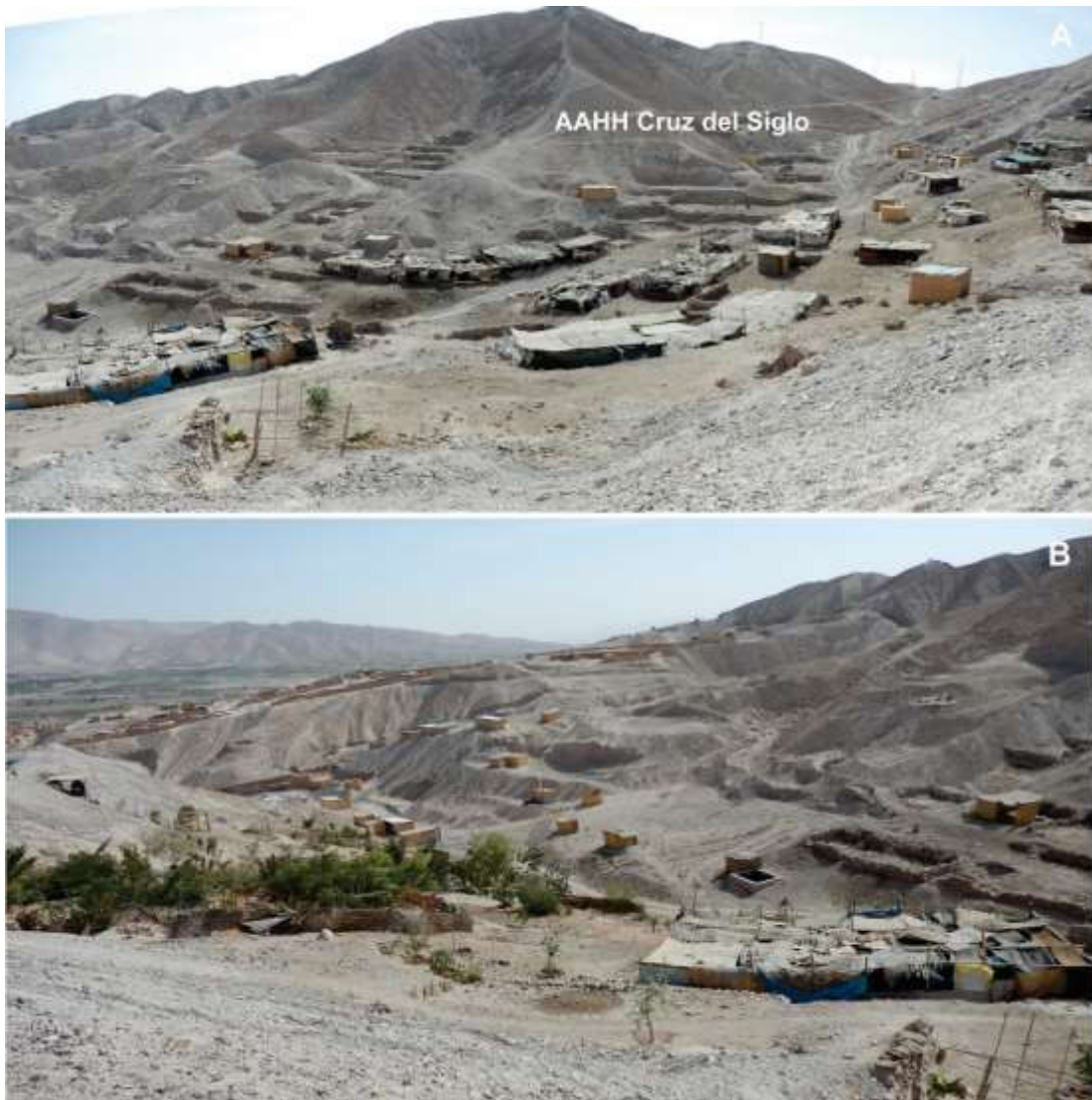
Figura 9.12 Erosión en cárcavas y derrumbes en cabecera de la quebrada San Antonio (A y B), viviendas y chancherías del AA.HH. Cruz del Siglo se encuentran en el cauce de quebradas.
