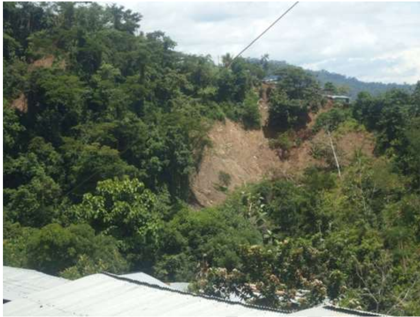
Fotografía 4.12 Sector del Mirador. Se observan viviendas en el borde de zona de derrumbe.
