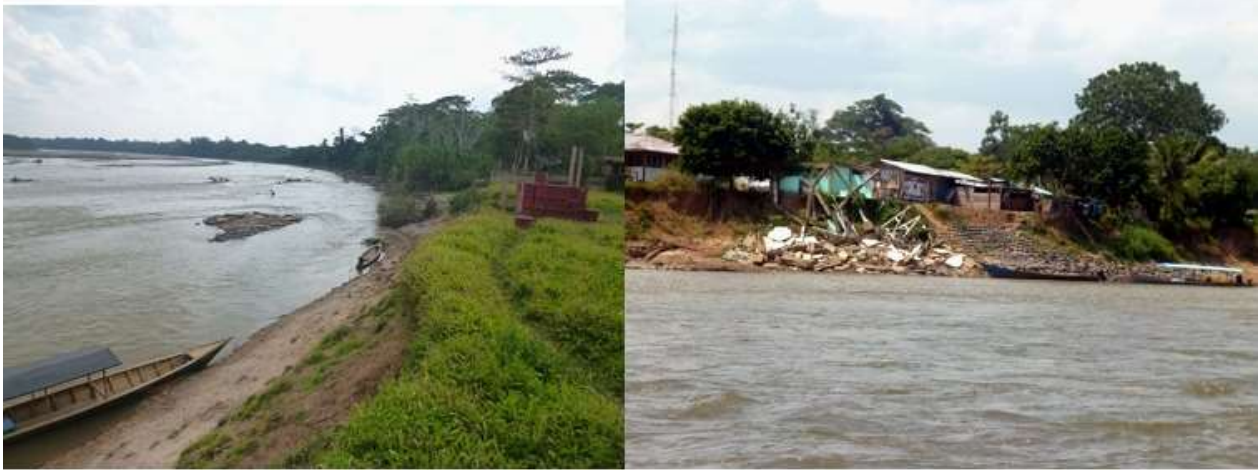
Figura 8.17 Proceso erosivo en la margen izquierda del río Madre de Dios en el distrito de Boca Manu, produjo la pérdida de terrenos en la plaza principal y la destrucción de la comisaría del distrito.
