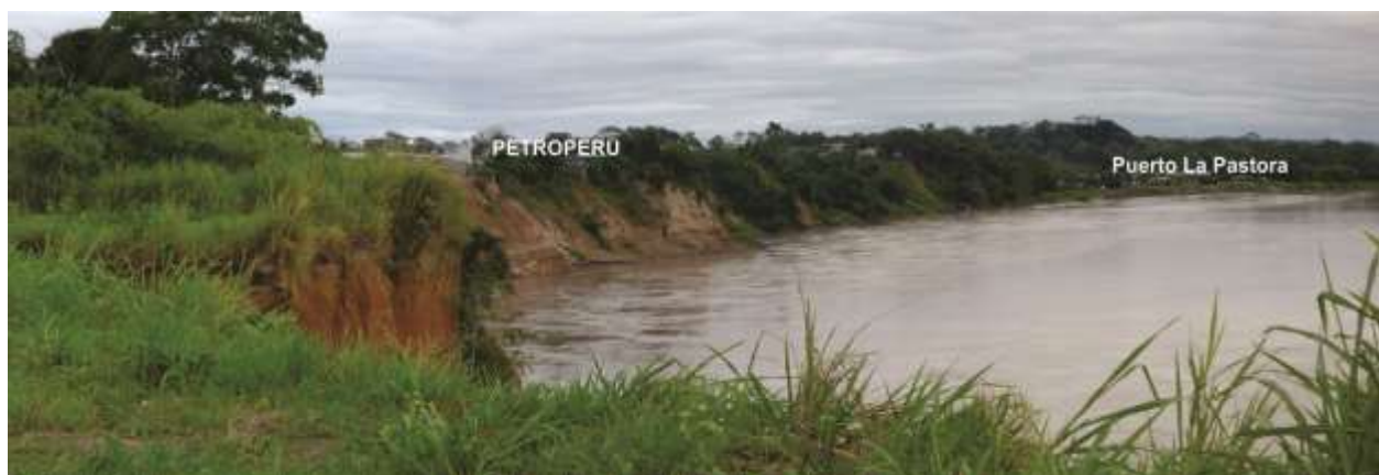
Figura 8.5 Vista de erosión fluvial en la margen derecha del río Madre de Dios en el sector Petroperú, afectando un tramo de 1.2 km de longitud.
