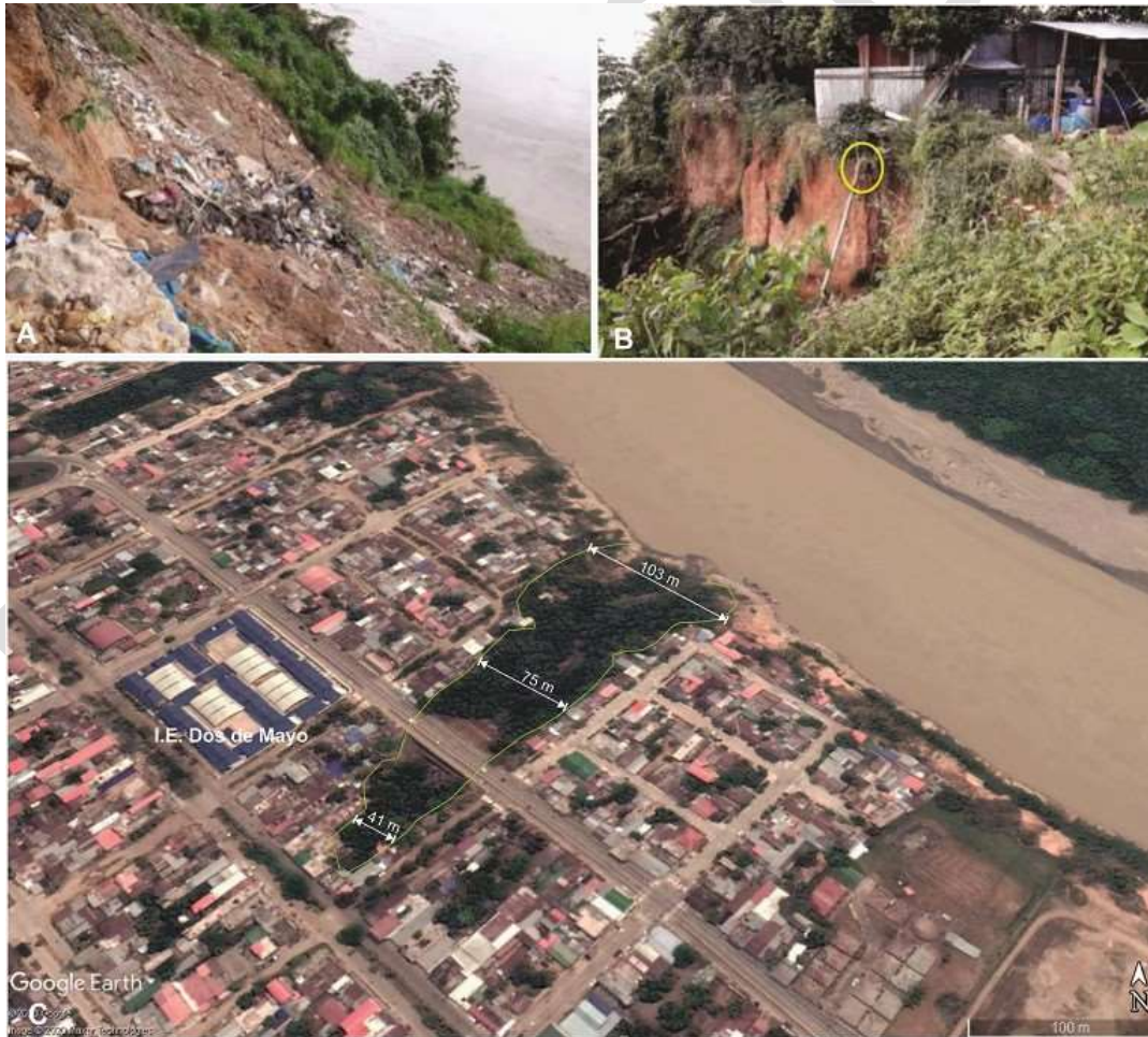
Figura 8.4 A) Erosión fluvial en la margen derecha del río Madre de Dios. B) Formación de pequeños surcos generados por la escorrentía superficial y la filtración de agua de las tuberías que se encuentran en pésimas condiciones. C) Dimensiones de la cárcava El Balcón.
