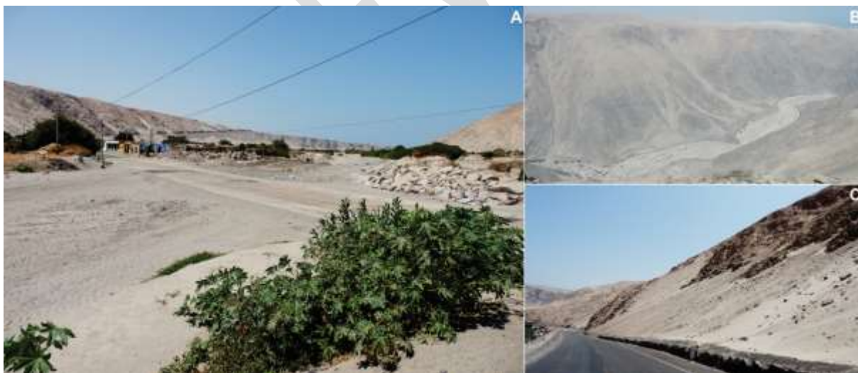
Figura 3.4 Huaicos en quebrada Pescadores, todos los años acarrea huaicos, obstruyendo la carretera Panamericana Sur, en el km 755+000
