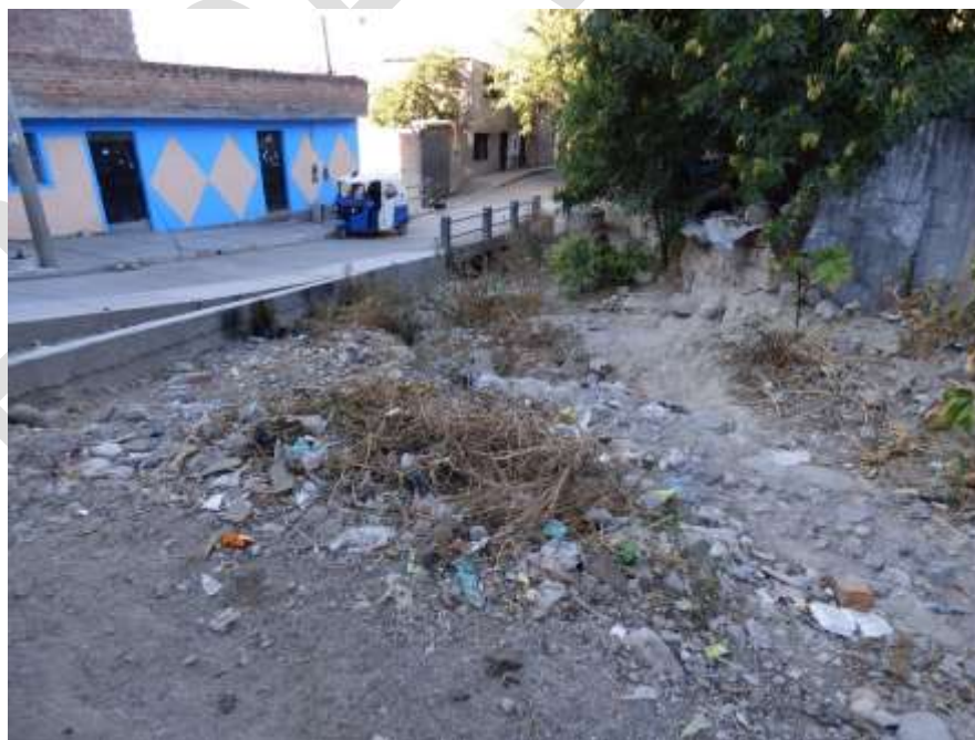
Fotografía 4.1 Material proluvial producto de flujos de detritos que boquea el puente en el barrio de Santa Ana
