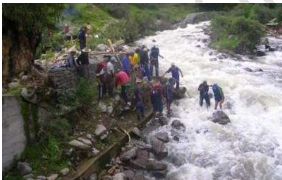
Fotografía 2.3 Pobladores de Totora-Oropesa tratando de reforzar defensas ribereñas en la margen derecha del río Oropesa (Fotografía cortesía del GORE Apurímac, enero del 2004).
