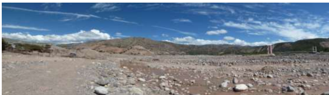
Fotografía 6.21 Puente vehicular que permite el acceso hacia Llamoctachi, quedó en medio del cauce del río Cachi, debido a la intensa erosión sufrida en ambas márgenes.
