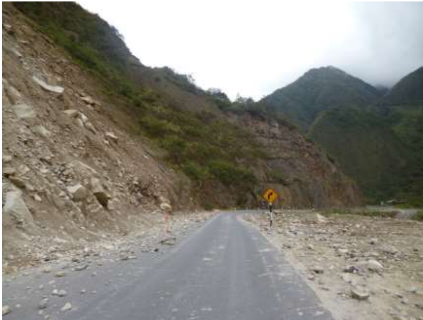
Fotografía 5.27 Detritos caídos obstaculizan el tránsito por la carretera Interoceánica en el Km. 148+500.
