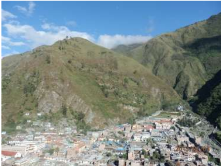
Fotografía 10.5 Vista panorámica del poblado de Sandia donde se puede observar zona de huaicos, derrumbes y talud de roca muy fracturada.
