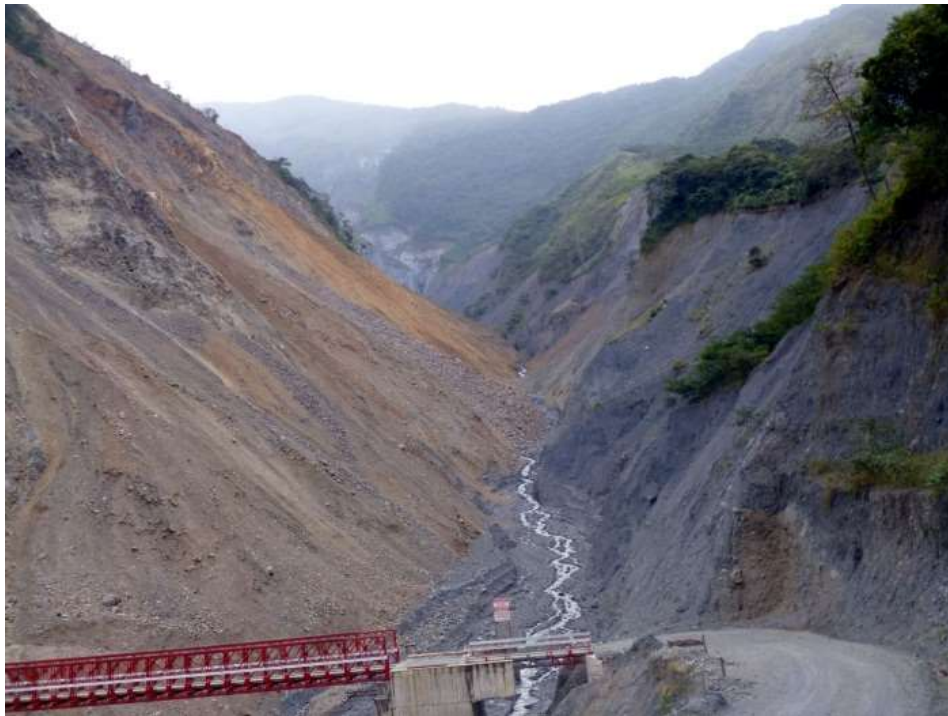
Fotografía 5.25 Flujo de detritos en la quebrada de Puente mayo, sector de Mesacancha.
