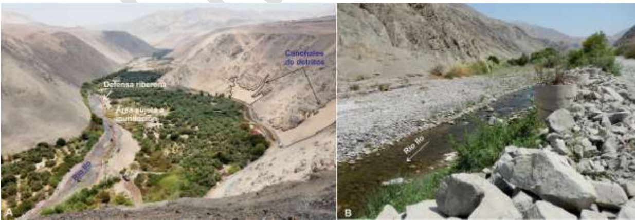
Figura 9.9 Área sujeta a inundación y erosión fluvial en ambas márgenes del río Ilo, también se observa derrumbes en talud superior de la carretera Ilo-Osmore, que se da en forma de canchales de detritos. A) En el sector Loreto Viejo se han colocado diques de material arrimado y pilotes de concreto, muro de gaviones, en aproximadamente 120 m de trocha en la margen izquierda del río Ilo para evitar que desborde y afecte terrenos de cultivos (B).
