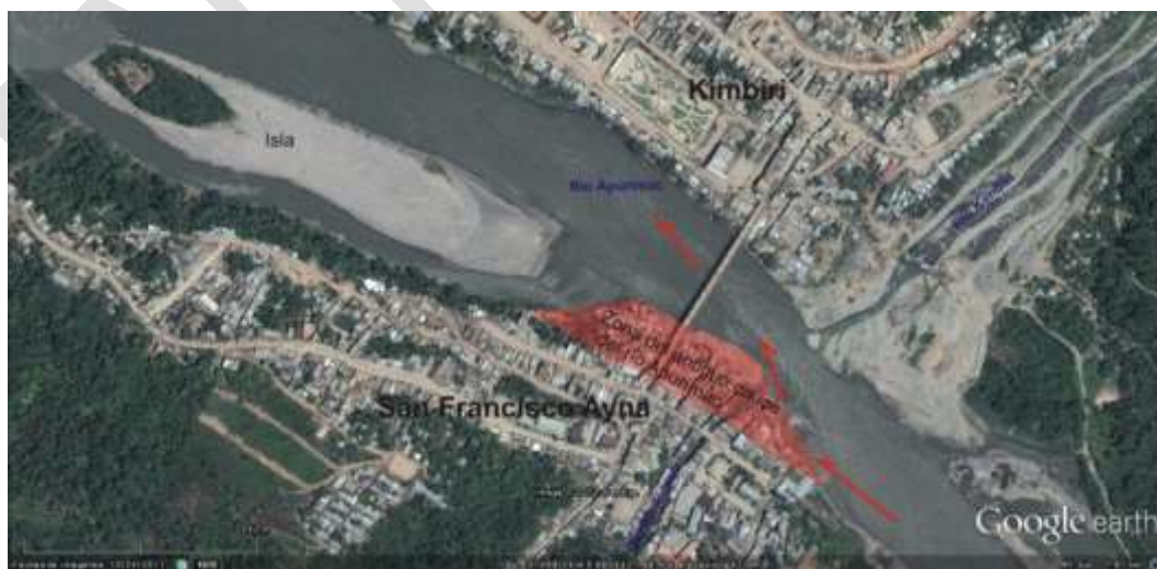
Figura 4.3 Erosión en el puerto de Ayna.
