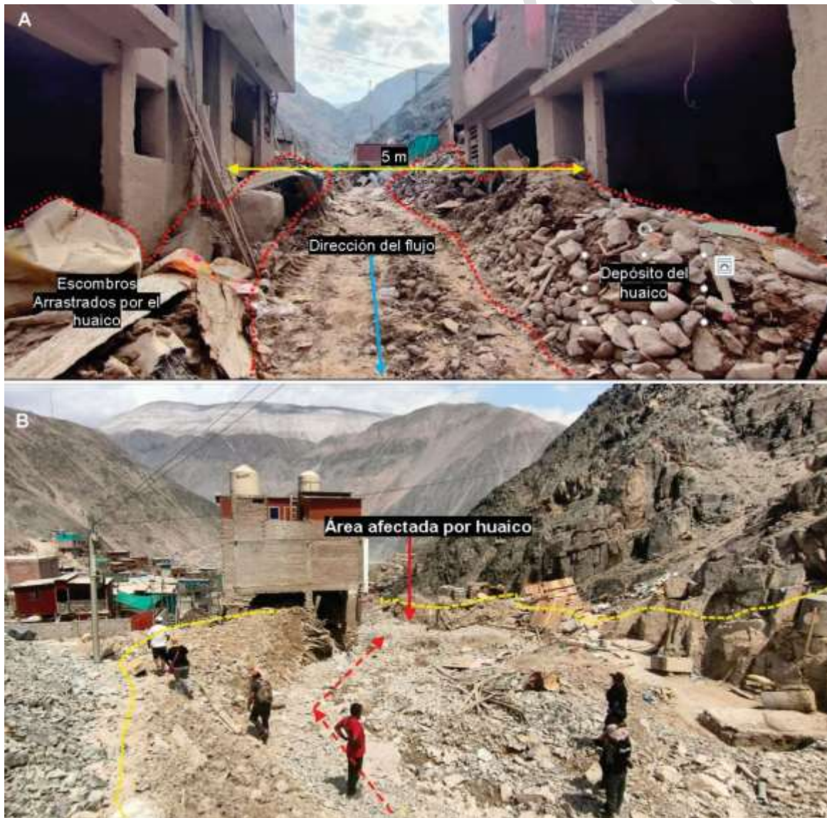
Figura 3.9 Viviendas afectadas por el huaico del 5 de febrero de 2023 (A), Área inundada por huaico y zonas erosionadas (B), ambas en el sector Posco Misky.
