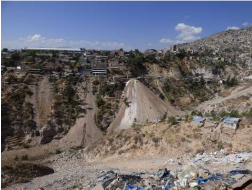
Fotografía 4.6 Botaderos de desmonte, en la margen derecha de la quebrada Picota y viviendas construidas en el borde de la quebrada con pendiente muy escarpada.
