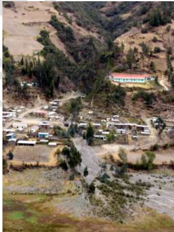
Fotografía 5.32 Flujo de detritos que baja por la quebrada Mecllaypata en la margen izquierda del río Paucartambo, puede afectar viviendas del poblado de Mecllaypata.
