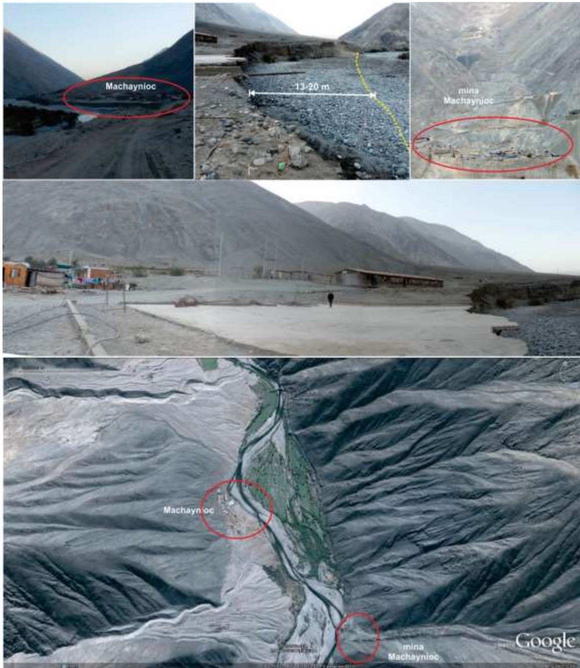
Figura 3.2 Vistas del sector Machaynioc afectado por erosión fluvial en la margen derecha del río Machaynioc. El poblado se encuentra sobre depósitos de flujos antiguos como se muestra en la imagen del Google Earth.
