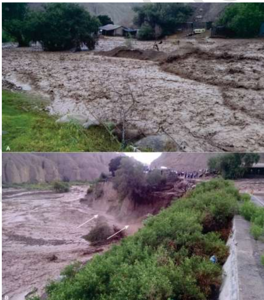
Figura 11.9 Flujo de lodo y erosión fluvial en la quebrada Pachana, sector Pachana del 26 de marzo de 2015 (Fuente: Defensa Civil de Ilabaya, 2015).
