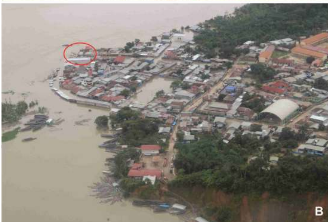
Figura 8.9 Vistas aéreas tomadas el 05 de febrero de 2012 en Puerto Laberinto. A) Debido a la erosión fluvial de 200 m de longitud, colapsó un grifo. Se colocó costales de arena a fin de mitigar dicho proceso. B) Vista más cercana de puerto Laberinto (tomada por Indeci, 2012).
