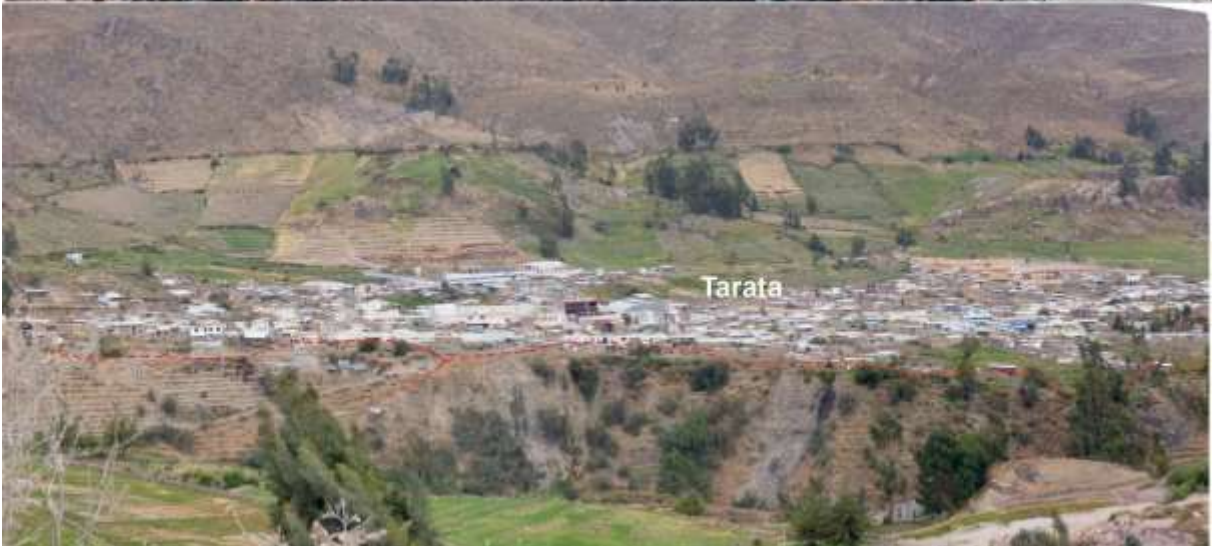
Figura 11.16 Derrumbes en acantilados en la margen izquierda del río Tarata, viviendas del poblado Tarata se encuentran muy cerca del borde.
