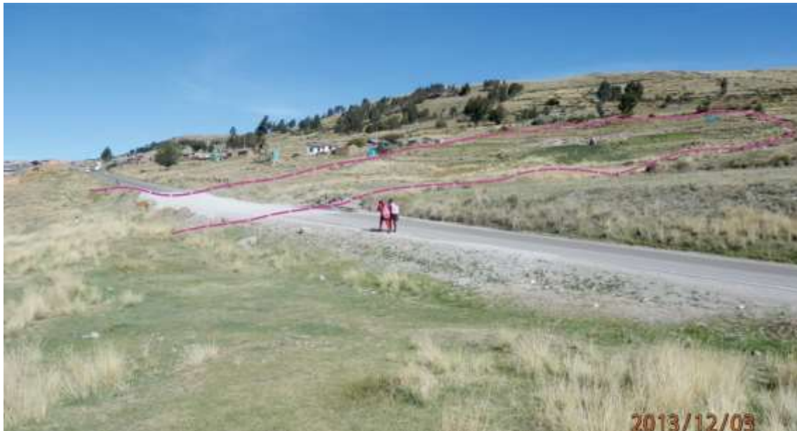
Figura 10.5 Vista del sector Cruzpata es susceptible a reptación de suelos y hundimiento, afecta tramo de carretera Juli-Pomata, km 1+500.
