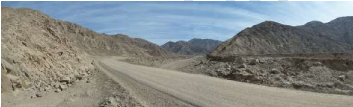
Fotografía 7.1 Tramo Culebrillas, trazado en cauce de quebrada que se activa excepcionalmente y puede ser afectada por flujos de detritos
