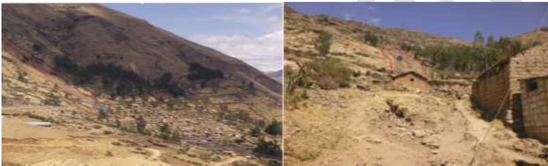
Figura 2.6 Movimiento complejo; avalancha antigua sobre la cual nace un flujo de detritos. Se observa la dirección del flujo y como esta impacta con las viviendas (poblado del distrito de Huayllati, provincia de Grau).
