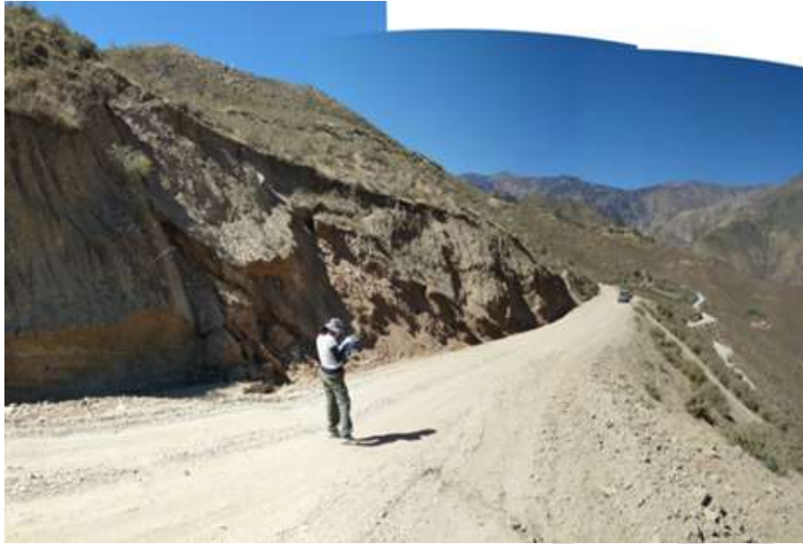
Fotografía 6.11 Primeras evidencias del deslizamiento en la carretera, manifestado como asentamientos en la plataforma de la carretera.
