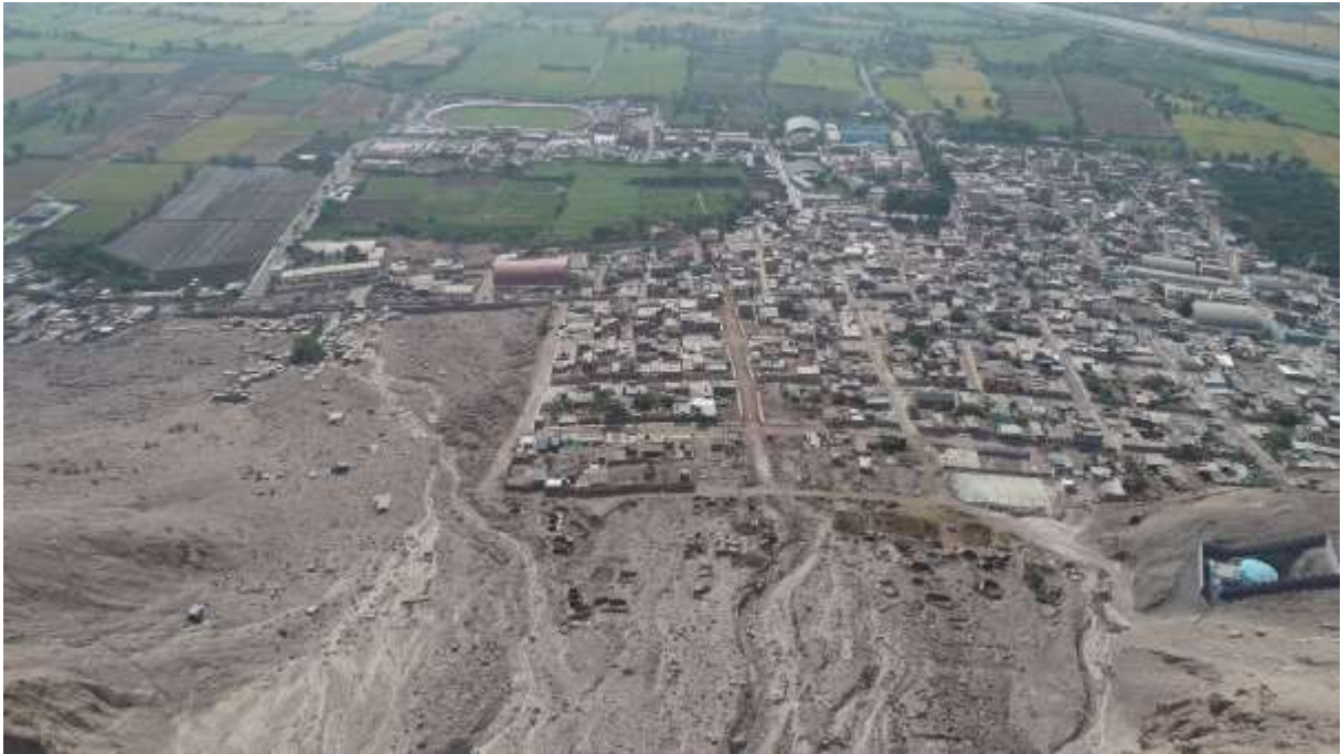
Fotografía 3.1 Viviendas de Aplao se ubican sobre un abanico por donde constantemente cae material de las laderas superiores.
