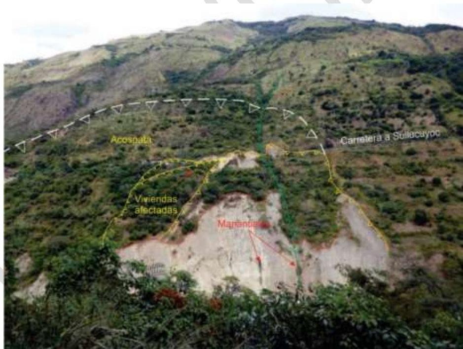
Figura 5.8 Vista del deslizamiento de Acospata.
