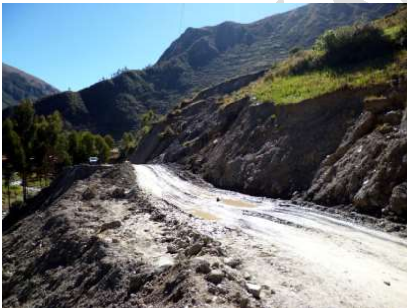
Fotografía 5.30 Asentamientos en la carretera producidos por reactivación de deslizamiento flujo en el sector de Huyloc.
