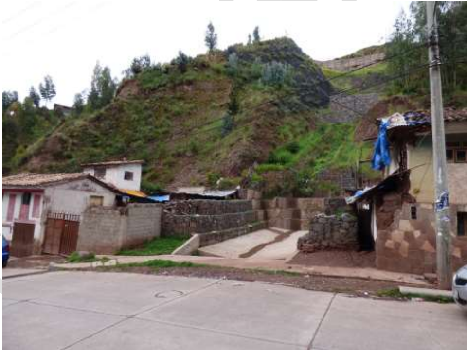
Fotografía 5.15 Evidencia de derrumbes donde fallecieron personas en el 2011.
