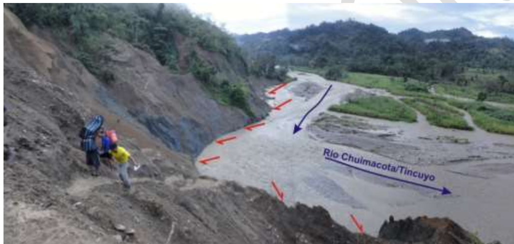
Figura 4.6 Llochegua: derrumbe del sector de Barranca afectó la carretera Llochegua-Chihullo; se muestra el área inestable. Las flechas de color rojo indican el sentido de la erosión del río; las de color azul, el sentido de corriente del río Chuimacota.
