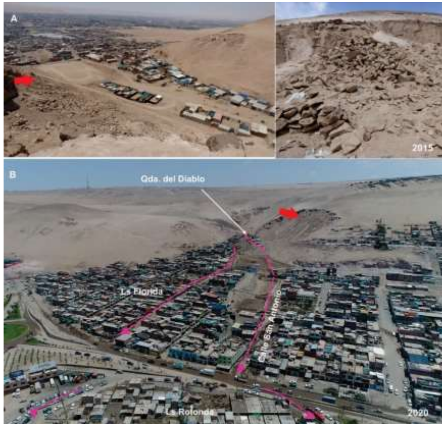
Figura. 11.13 A) Viviendas del sector La Florida ubicadas dentro del cauce de la quebrada del Diablo, en la margen izquierda de la quebrada presenta derrumbes y caída de rocas en el cerro Intiorko; B) Vista aérea realizada con dron, donde se observa la zona afectada por el flujo de lodo en la quebrada del Diablo del 21/02/2020 (Instituto geológico Minero y Metalúrgico, 2020).
