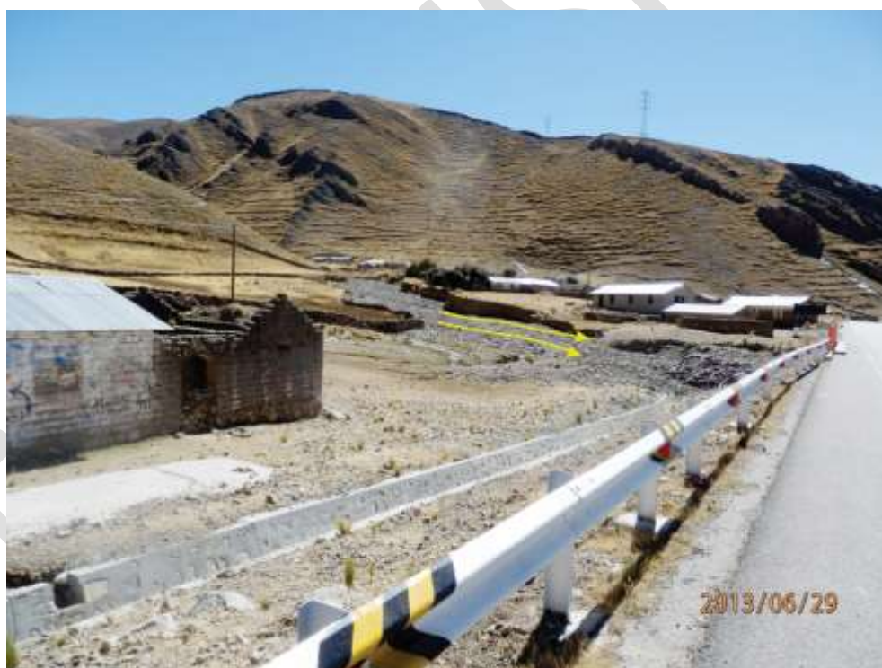
Figura 10.2 Sector Ccatuyo, susceptible a flujo de detritos (huaico) y erosión. Afectaría viviendas que se encuentran asentados dentro del abanico antiguo.
