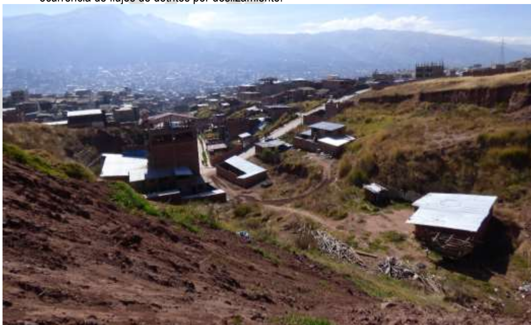
Fotografía 5.6 Vista de aguas abajo de cárcava ocupada por viviendas de la A.P.V. El Chaparral; se observan pequeños derrumbes en la parte alta de la cárcava.
