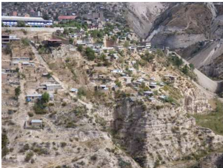
Fotografía 4.8 Cortes de talud y construcción de viviendas en área inadecuada. Sector ADV Juan Velasco Alvarado
