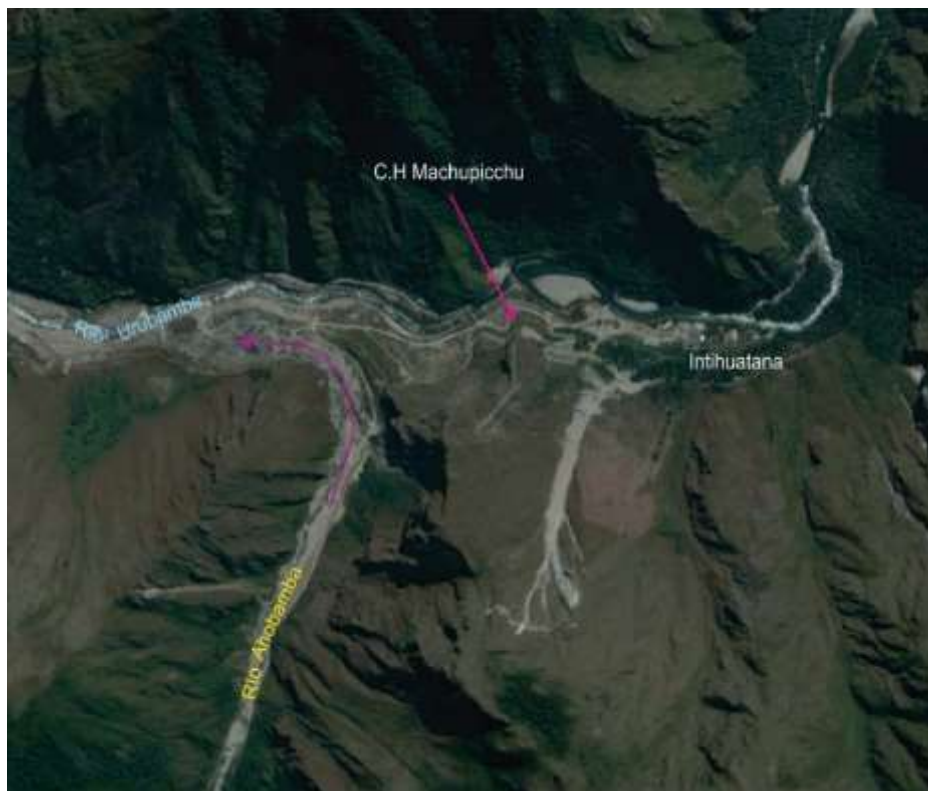
Figura 5.6 Vista del río Urubamba donde se encuentra la C.H de Machupicchu, también se puede observar el cauce del río Ahobamba, por donde discurrió un aluvión que represo el río Urubamba y provoco daños en la central hidroeléctrica.
