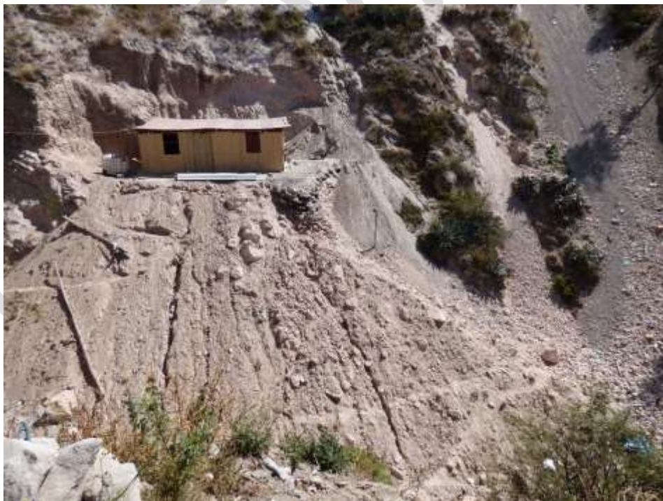
Fotografía 4.3 Corte de talud para la construcción de viviendas, que desestabiliza el área en el AA.HH. San Juan de La Picota y condiciona a la ocurrencia de flujos
