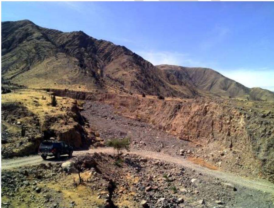
Fotografía 7.6 Quebrada Gramadal, carretera a Tibillo. Falta construir un badén o pontón.
