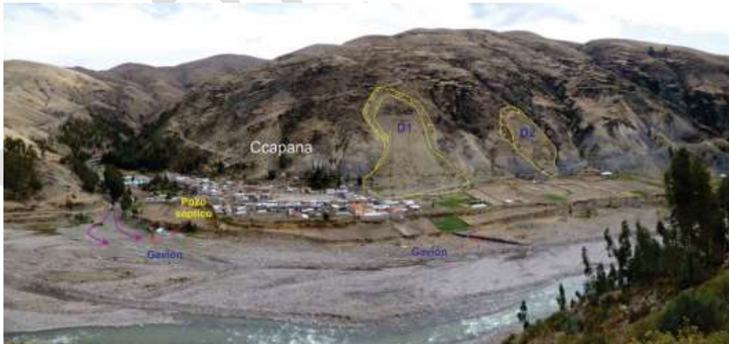
Figura 5.9 Poblado de Ccapana, se ha señalado los deslizamientos, se tienen también erosión fluvial en la margen izquierda del río Mapocho.
