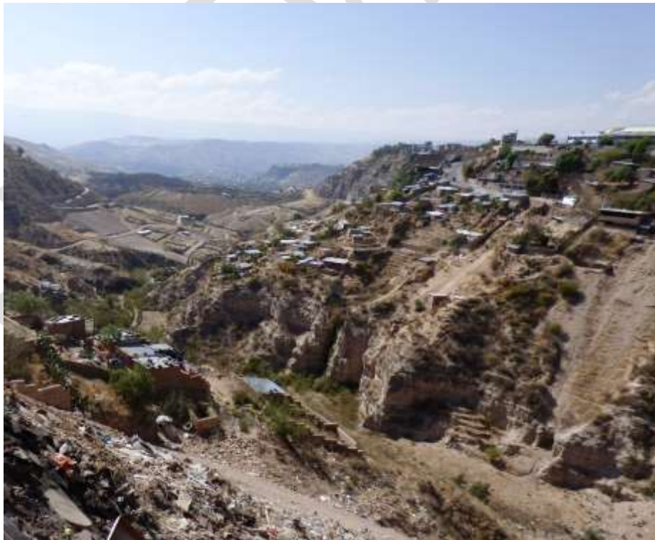
Fotografía 4.7 Viviendas del sector Zona de invasión de la ladera de Los Forestales construidas en talud inestable
