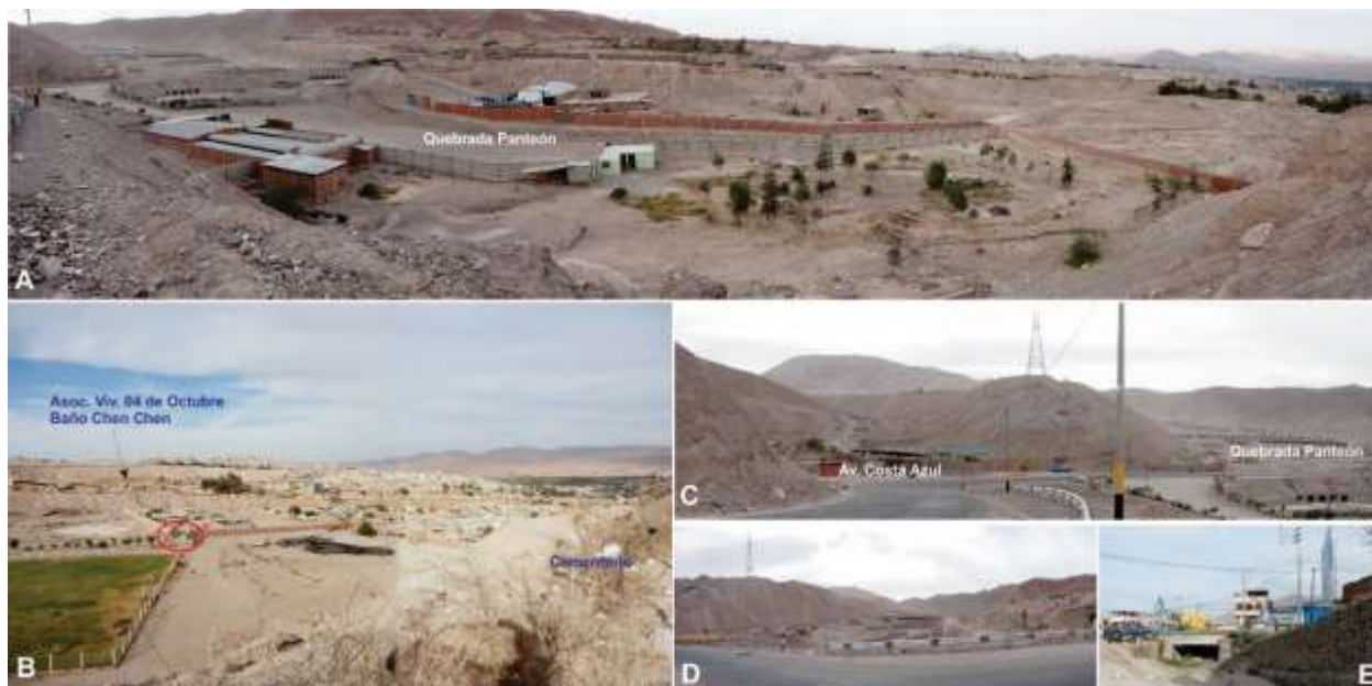
Figura 9.19 A) Vista panorámica de la quebrada Cementerio o Panteón. B) Flujo de detritos en el 2012 se llevó muro de una de las instalaciones de la Universidad José Carlos Mariátegui, señalado con un círculo de color rojo, el cual se encuentra en pleno cauce de la quebrada Panteón. C) Se observan viviendas ubicadas en el cauce de quebradas afluentes a la quebrada Panteón, a la altura del km 4+880. D) Cabecera de la quebrada Panteón cruza carretera asfaltada, en el km 5+180. E) Aguas abajo de la quebrada Panteón, en el sector Pedregal-La Victoria, se ha colocado un pontón para proteger la carretera Binacional.
