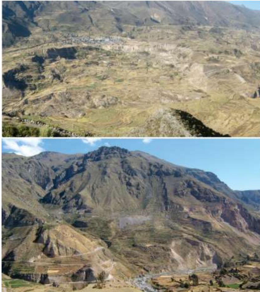
Figura 3.16 Deslizamiento rotacional de Maca-Chacaña que afecta al distrito de Maca y la carretera hacia Cabanaconde (arriba). Reactivación de deslizamiento por construcción de carretera entre Maca y Lari (abajo).
