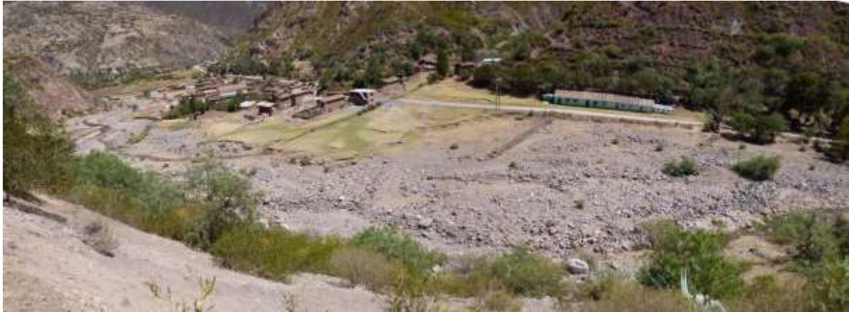
Fotografía 5.34 Valle del río Paruro y del poblado de Cusibamba bajo asentado en su margen izquierda cerca a la desembocadura en el río Apurímac, afectado por procesos de erosión fluvial y huaicos, se han colocado espigones con gaviones para evitar que el poblado sea afectado.
