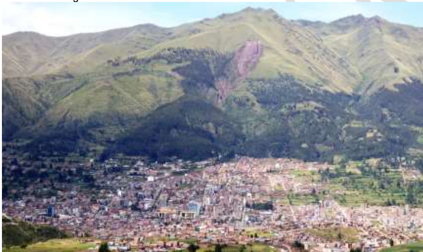
Fotografía 5.5 Viviendas de los sectores de Santa María, Huaynapicol y Larapa que podrían ser afectadas en caso de ocurrencia de flujos de detritos por deslizamiento.
