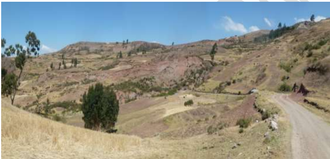
Fotografía 6.14 Deslizamiento en el Cerro Lirioyoc, sector de Libertad, cerca de Marcas, produce asentamientos en la plataforma de la carretera.
