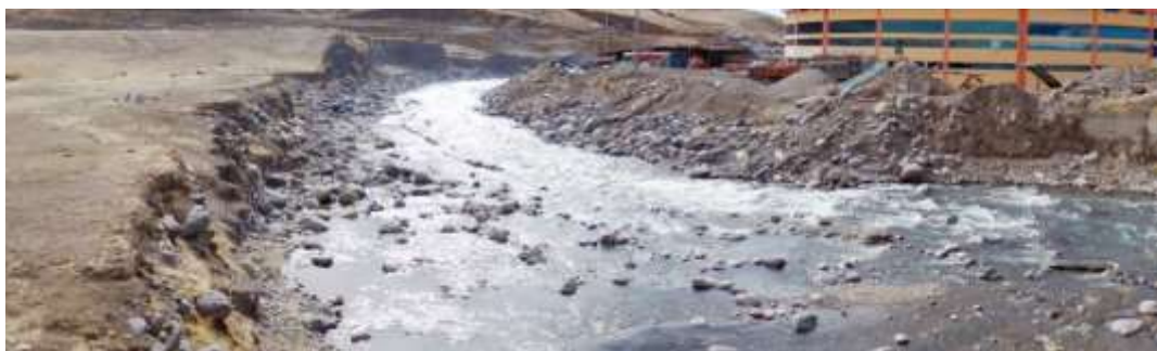
Fotografía 10.1 Sector Macusani, susceptible por inundación y erosión fluvial. Con la presencia de lluvias intensas, afectaría viviendas y el coliseo que se encuentra cerca al cauce.
