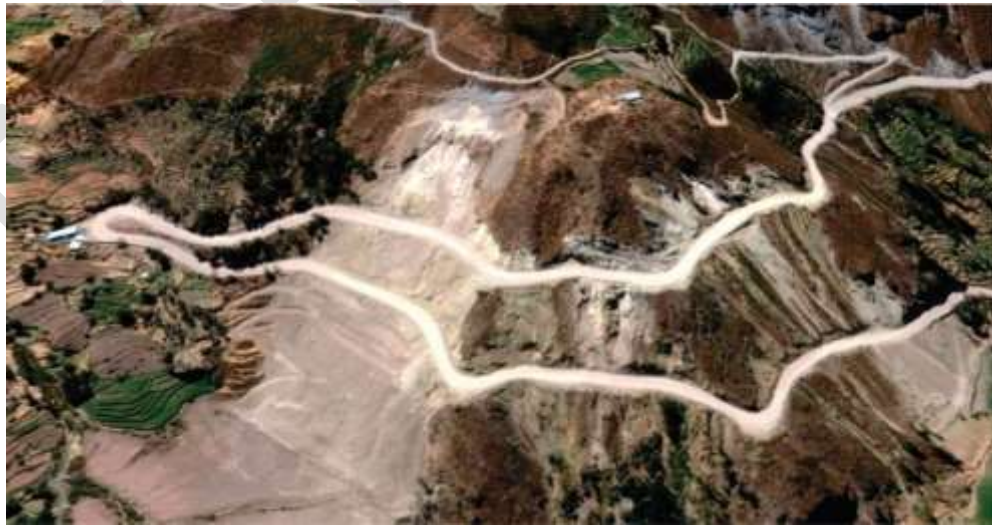
Figura 3.13 Carretera de acceso entre Cotahuasi y Chuquibamba (Km 8+100) afectada y susceptible a derrumbes por corte de talud para su construcción. Imagen Google Earth.
