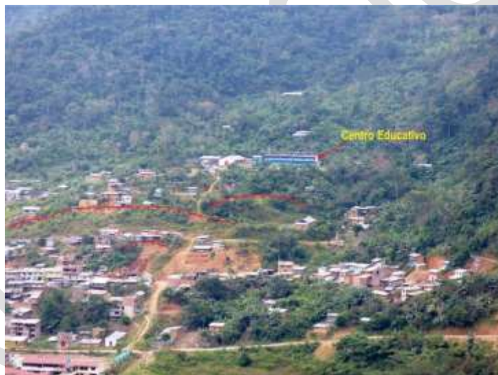
Figura 10.9 Vista del poblado de Putina Punco. Se observa deslizamiento confinado que afectó viviendas e infraestructura.
