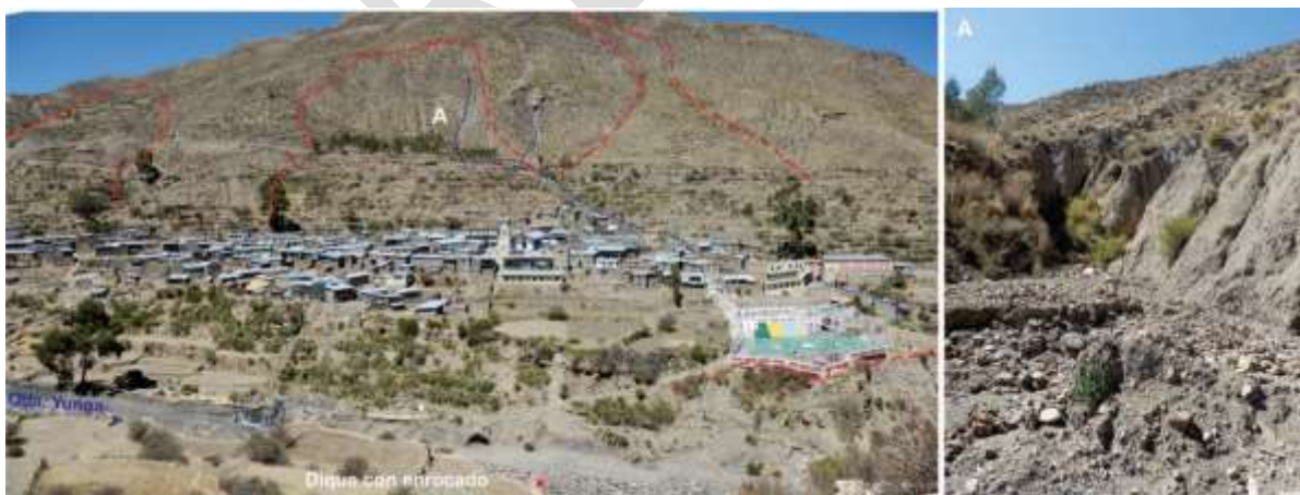
Figura 9.4 El poblado de Yunga se encuentra asentado sobre depósitos antiguos de remoción en masa, algunos se reactivan en forma de erosión de laderas por donde discurren huaicos como se puede apreciar en la ampliación (A) debido al abundante material suelto en las laderas del cerro Machapata. En líneas de color azul se observa la trayectoria del huaico del 16 de diciembre del 2012 que afectó al poblado de Yunga. También presenta erosión fluvial en la margen izquierda de la quebrada Yunga, su cauce tiene un ancho máximo de 20 m, se ha colocado un dique con enrocado de aproximadamente 230 m de longitud, con presencia de derrumbes reactivados por socavamiento del pie del talud de la ladera o terraza, infiltraciones naturales y de riego.
