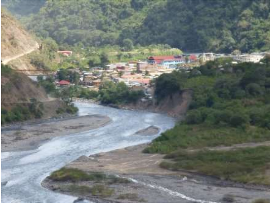
Fotografía 5.23 Erosión fluvial en la margen izquierda del río Yanatile. Puede afectar viviendas asentadas cerca de su cauce.
