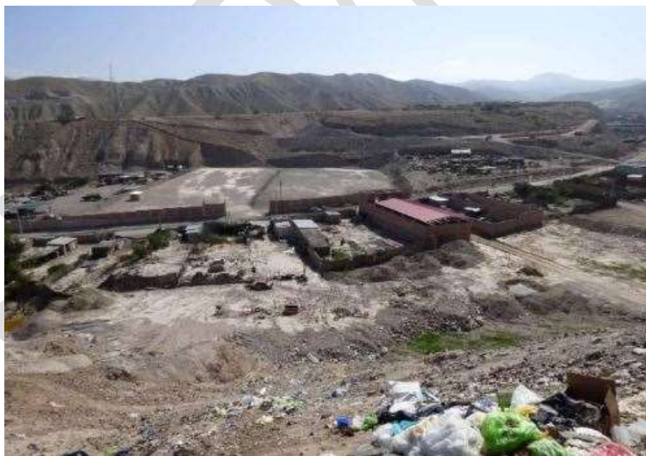
Fotografía 9.7 Vista con dirección al norte, se puede observar el cauce de la quebrada Panteón en la cuenca media, ocupada por viviendas y otras infraestructuras; es posible ver en color crema claro la zona afectada por el flujo de detritos del 26 de febrero del 2020.
