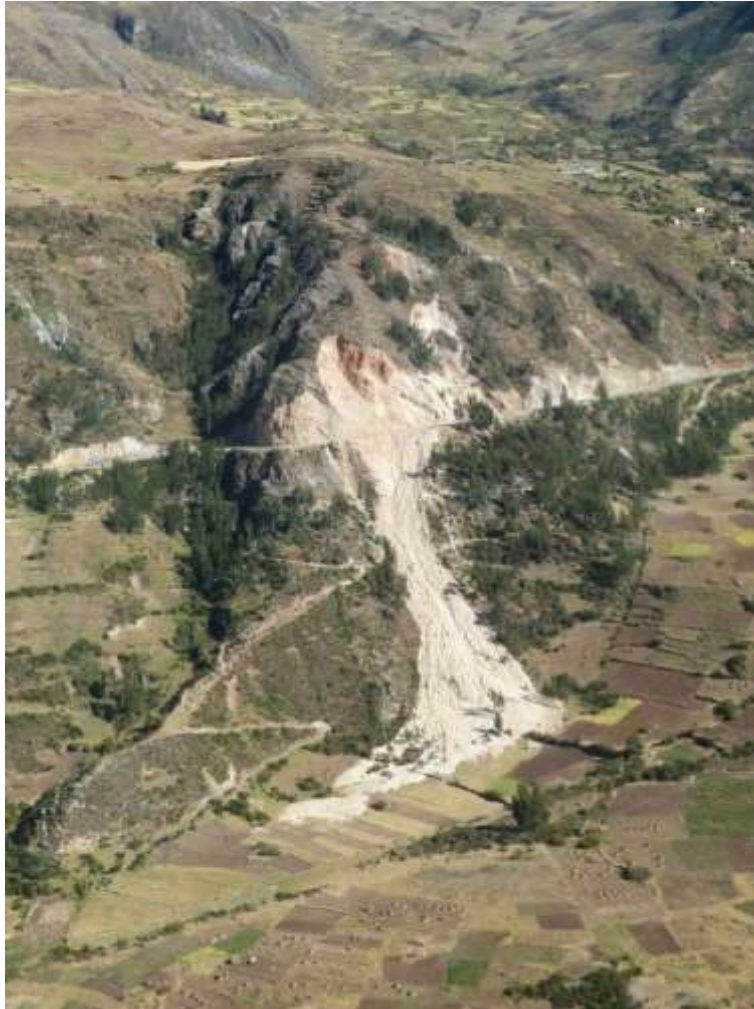
Fotografía 6.4 Derrumbe que cortó la plataforma de la carretera entre Cachi y Puente Palca (02/2010).
