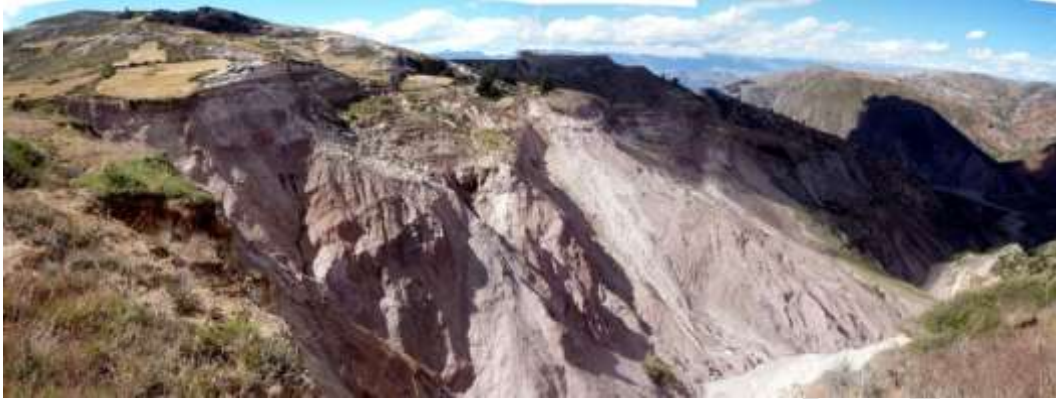
Fotografía 6.18 Cabecera de la quebrada Illacasca afectada por un deslizamiento activo.
