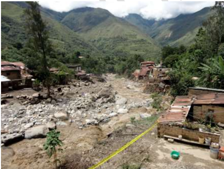
Fotografía 5.24 Destrucción de viviendas asentadas cerca del cauce de la quebrada Calquiña en Huyro.
