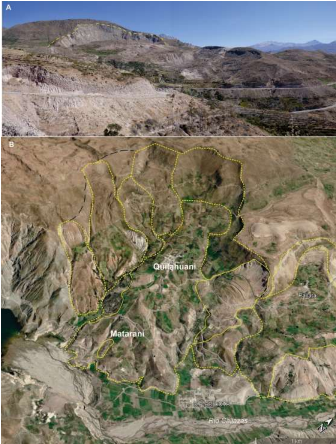
Figura 11.5 A Vistas de la escarpa del deslizamiento de Quilahuani,- B) Imagen del Google Earth, se observa que el poblado se encuentra en el cuerpo del deslizamiento con presencia de algunas reactivaciones a manera de derrumbes y deslizamiento como en el sector Matarani al pie del deslizamiento de Quilahuani, en la margen derecha del río Callazas.
