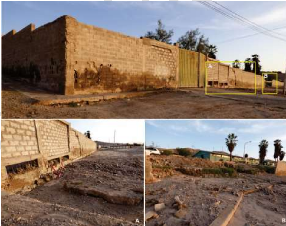
Figura 9.17 A) Vista del cuartel Los Ángeles, Samegua B) y C) Ampliación de la vista del cuartel y el daño ocasionado por el huaico del 26/02/2020 donde se observa muros colapsado por el empuje del flujo cerca del Instituto José Carlos Mariategui.
