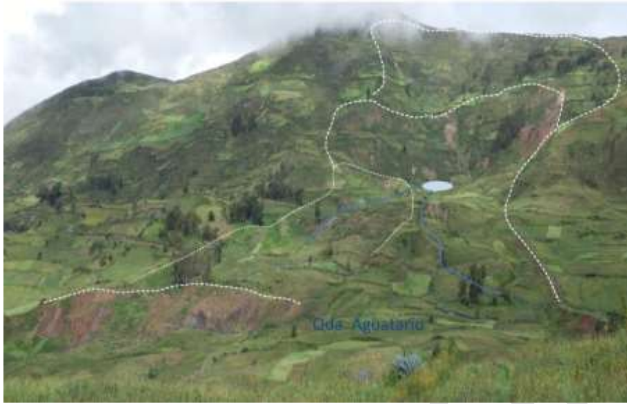
Figura 6.4 Deslizamiento rotacional de escarpas múltiples y sucesivas en el sector Yanayacu-Cutmo, distrito de Locroja.
