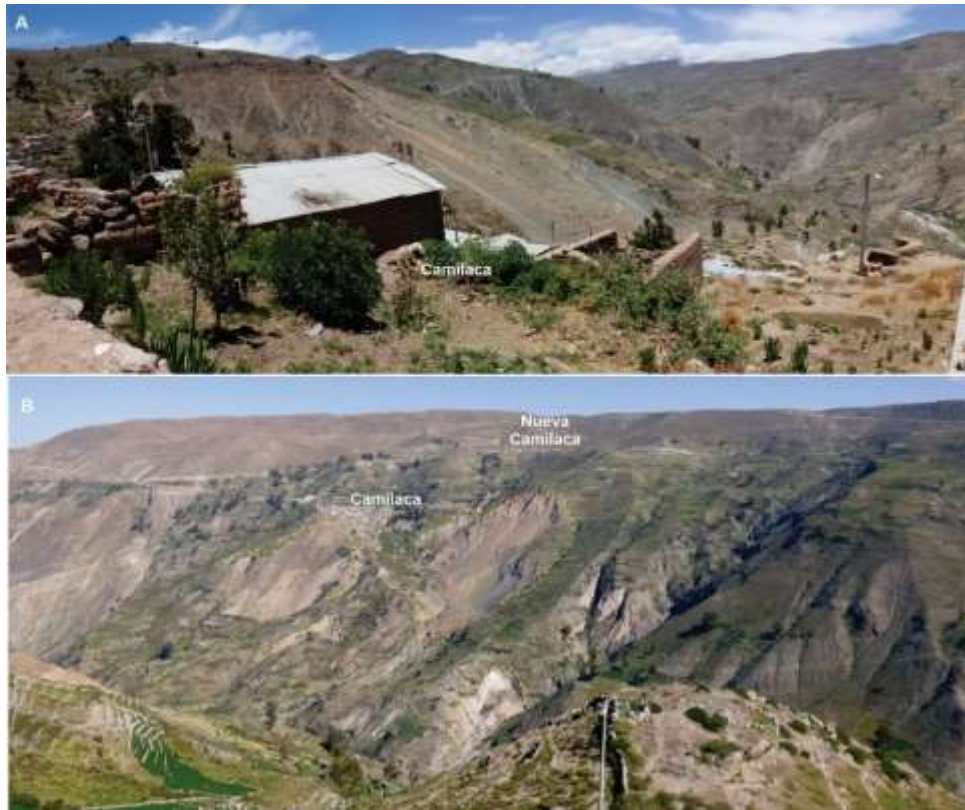
Figura 11.3 Deslizamiento y derrumbes en la margen derecha del río Camilaca, sector de Camilaca
