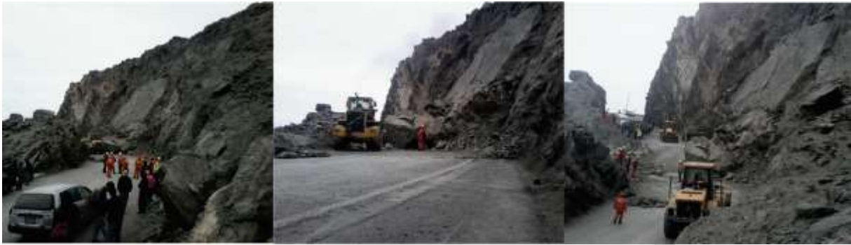
Figura 3.5 Caída de rocas en el km 766 de la carretera Panamericana Sur, sector La Planchada, distrito de Atico.
