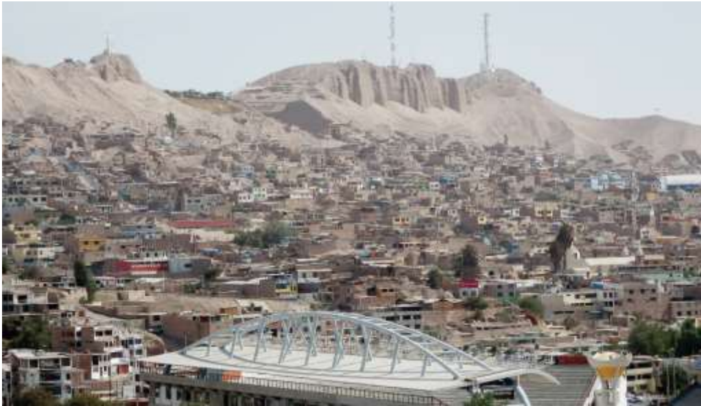
Figura 9.13 Derrumbes y erosión en cárcavas en la parte alta de la ciudad de Moquegua. En época de lluvias excepcionales discurren huaicos y flujos de lodos por estas cárcavas.
