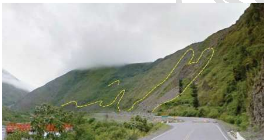
Figura 10.3 Sector Michinichi, susceptible a derrumbes. Detonadas por lluvias intensas que presenta el sector. Afecta tramo de carretera Ollachea-San Gabán.
