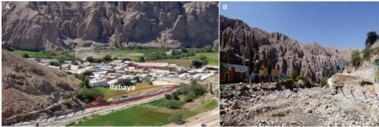
Figura 11.10 Área sujeta a erosión fluvial e inundación en ambas márgenes del río Colocaya, sector Ilabaya.
