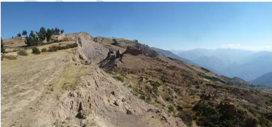
Fotografía 6.15 Vista del deslizamiento de Chilcapite, se observan los asentamientos del terreno en la corona.
