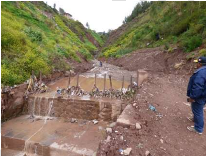
Fotografía 5.11 Flujos de detrito y lodo que se generan producto de derrumbes detonados en temporada de lluvias.
