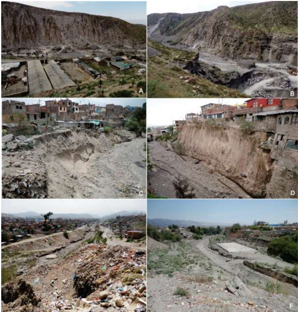
Figura 3.21 A) Erosión de laderas de tipo cárcavas y derrumbes en ambas márgenes de la quebrada San Lázaro (parte alta) aportan material suelto al cauce de la quebrada. B) Presencia de canteras en el cauce de la quebrada San Lázaro acumula material suelto. C y D) Viviendas se encuentran al borde del acantilado formado en la quebrada San Lázaro, algunas ya han colapsado. E). Desmonte y basura acumulada en la parte alta de la quebrada San Lázaro. F) Plataforma deportiva en terraza baja de la quebrada San Lázaro.
