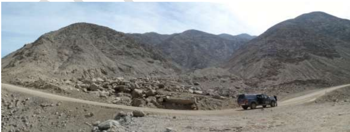
Fotografía 7.2 Flujo de detritos excepcional a la altura del km 34 de la carretera a Capillas y Tantará
