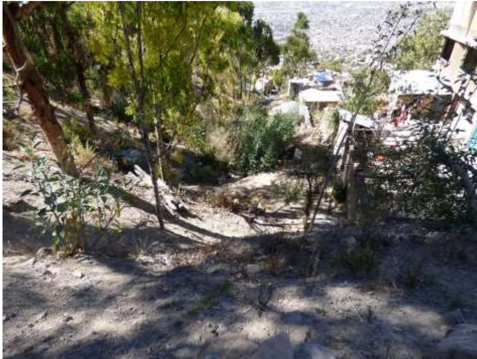
Fotografía 4.2 Viviendas en el sector Pueblo Joven La Libertad, asentadas sobre depósitos de flujos antiguos
