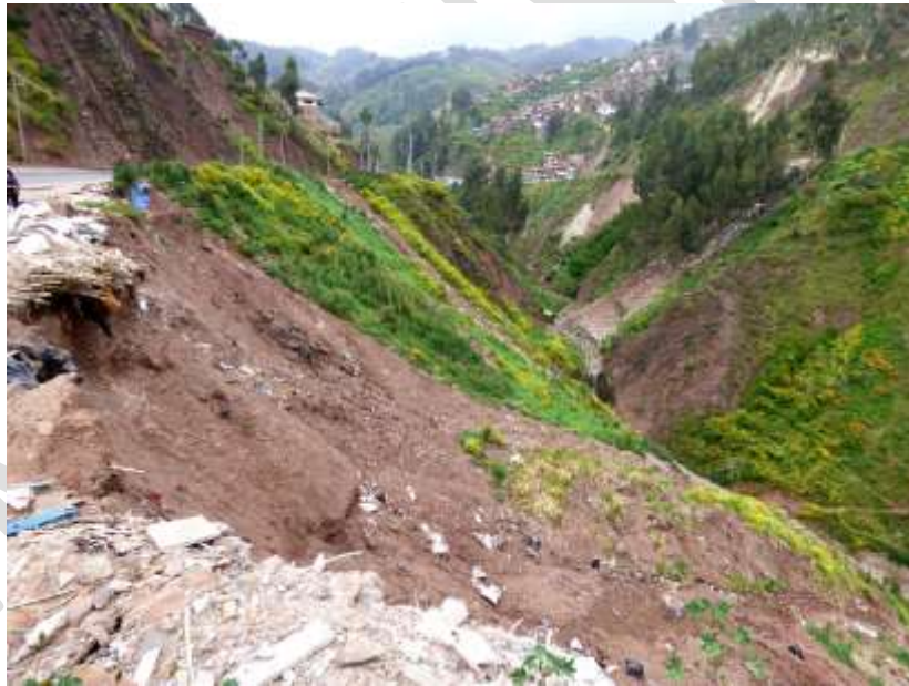
Fotografía 5.17 Caída de rocas y derrumbe
