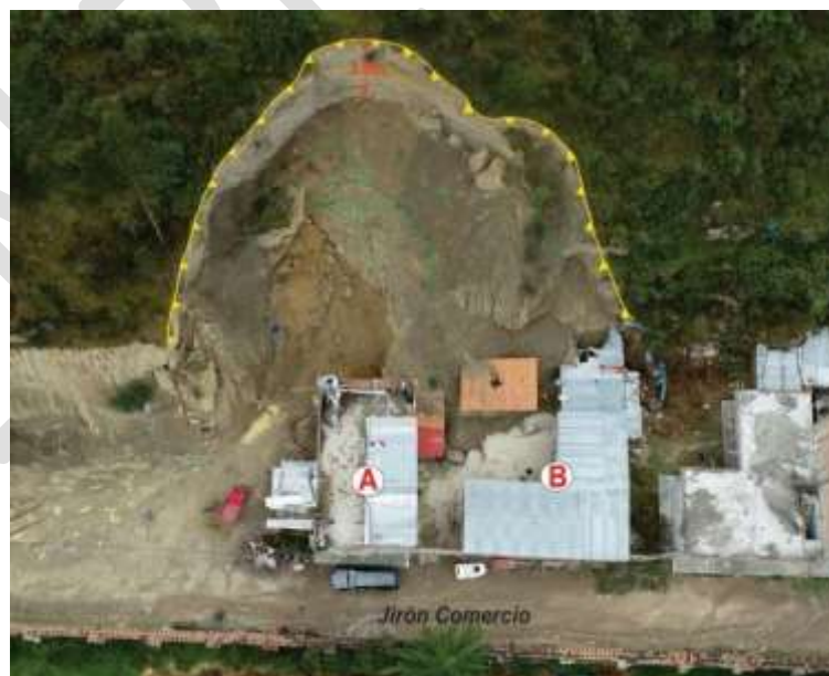
Figura 2.2 Vista tomada con el dron, donde se puede visualizar las grietas transversales con longitudes de hasta 13 m (líneas punteadas de color verde); emanación de agua subterránea (punto de color azul) y se puede ver la afectación a las dos viviendas ubicadas al pie del deslizamiento Comunidad campesina Pairaca.
