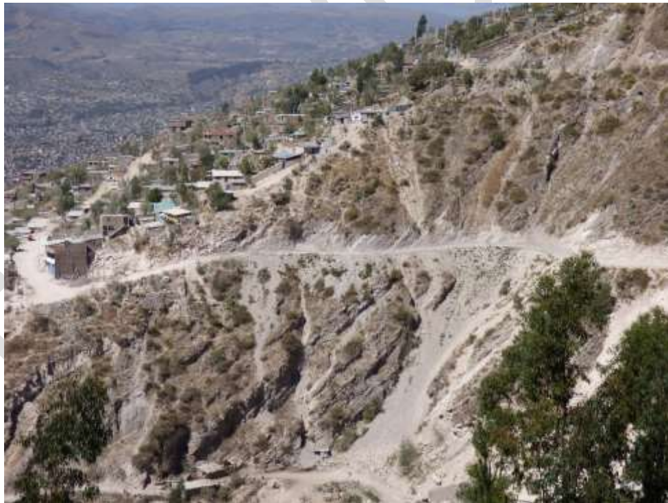
Fotografía 4.5 Corte de talud para accesos y asentamiento de viviendas de la Asociación Señor de Palacio en el lateral derecho del área afectada por cárcava
