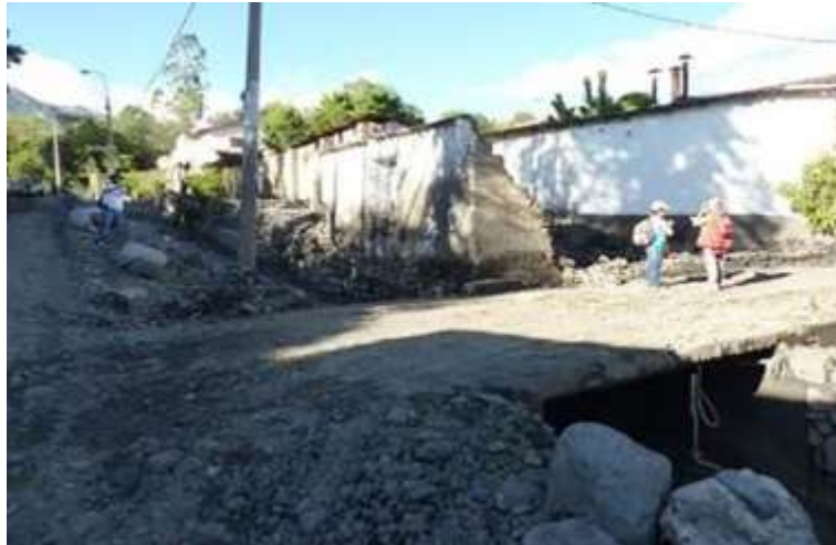
Fotografía 2.5. Destrozo de pared de vivienda por el flujo de detritos de la quebrada Sahuanay en el sector de Podocarpus (Fuente: INGEMMET, 2012).
