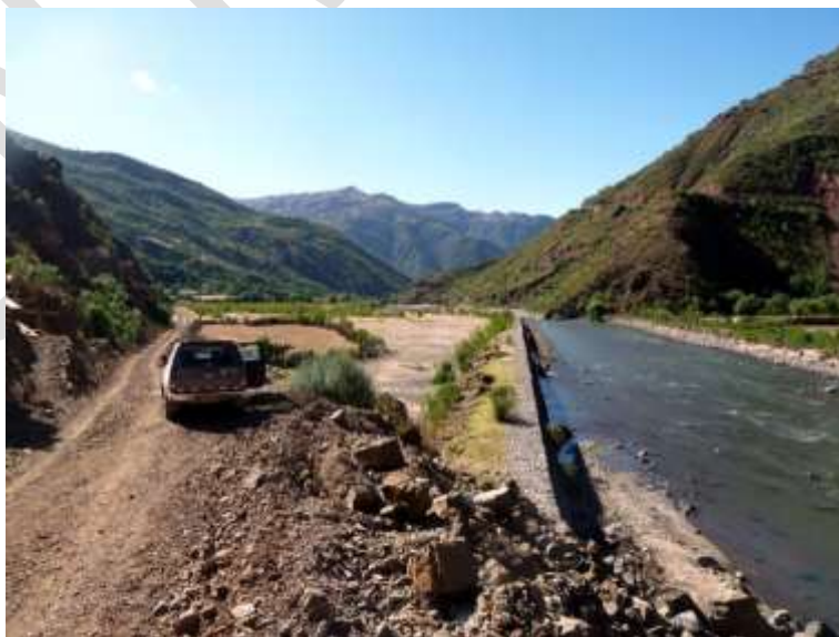
Fotografía 6.20 Muros de gaviones para encausar el río Cachi y controlar la erosión en el poblado de Antaparco.
