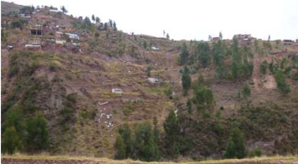
Fotografía 5.7 Ladera del cerro Taucaray en la margen izquierda de la quebrada La Rinconada cortada por cárcavas y ocupada por nuevas viviendas que para ser construidas se realizan cortes en la ladera que desestabilizan el terreno.
