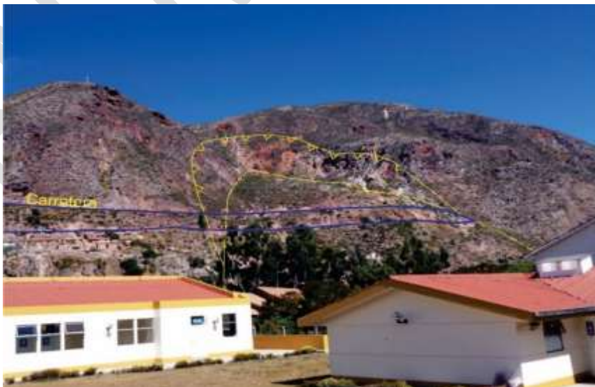
Figura 5.11 Deslizamiento que produce el asentamiento de la carretera que permite el acceso a Urubamba.
