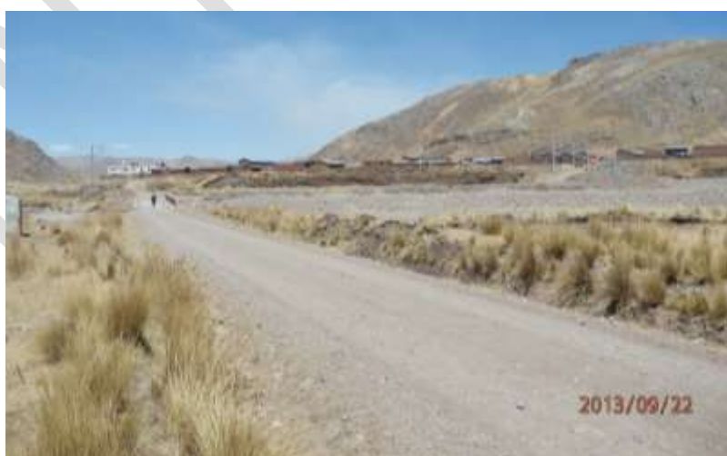
Fotografía 10.3 Vista panorámica del poblado Larimayo susceptible a flujo de detritos, inundación y erosión fluvial, que afecta tramo de carretera y viviendas que se encuentran a la ribera del río.
