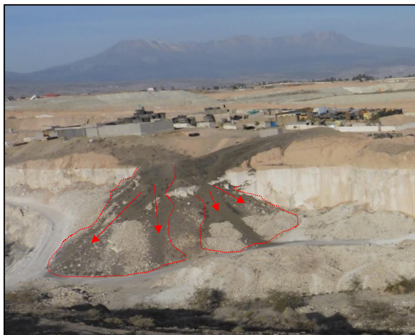
Figura 20. Derrumbes en el sector Ruta del Sillar, Quebrada Añashuayco, (coordenadas UTM WGS84: 220949E, 8189189N)
