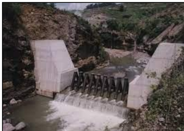
Figura 28. Presas tipo SABO de sedimentación escalonada para controlar la fuerza destructiva de los lahares.
