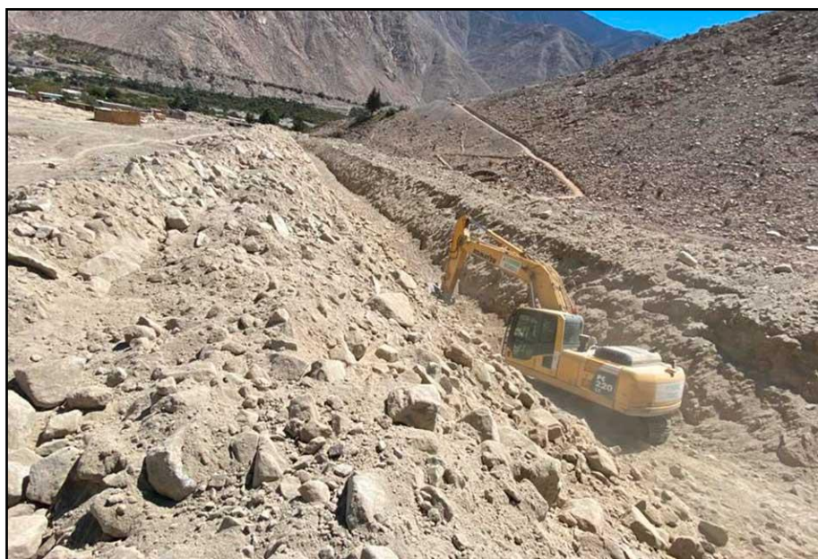
Figura 30. Limpieza de cauce de la quebrada.
