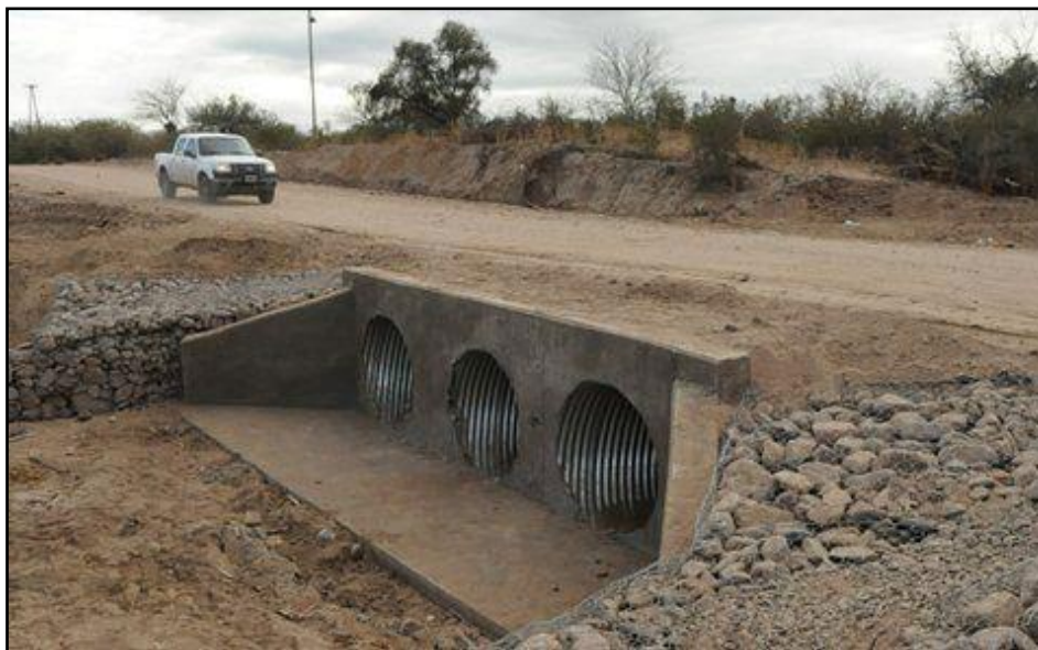
Figura 29. Obras de drenaje para redes viales (alcantarillas y pontones).
