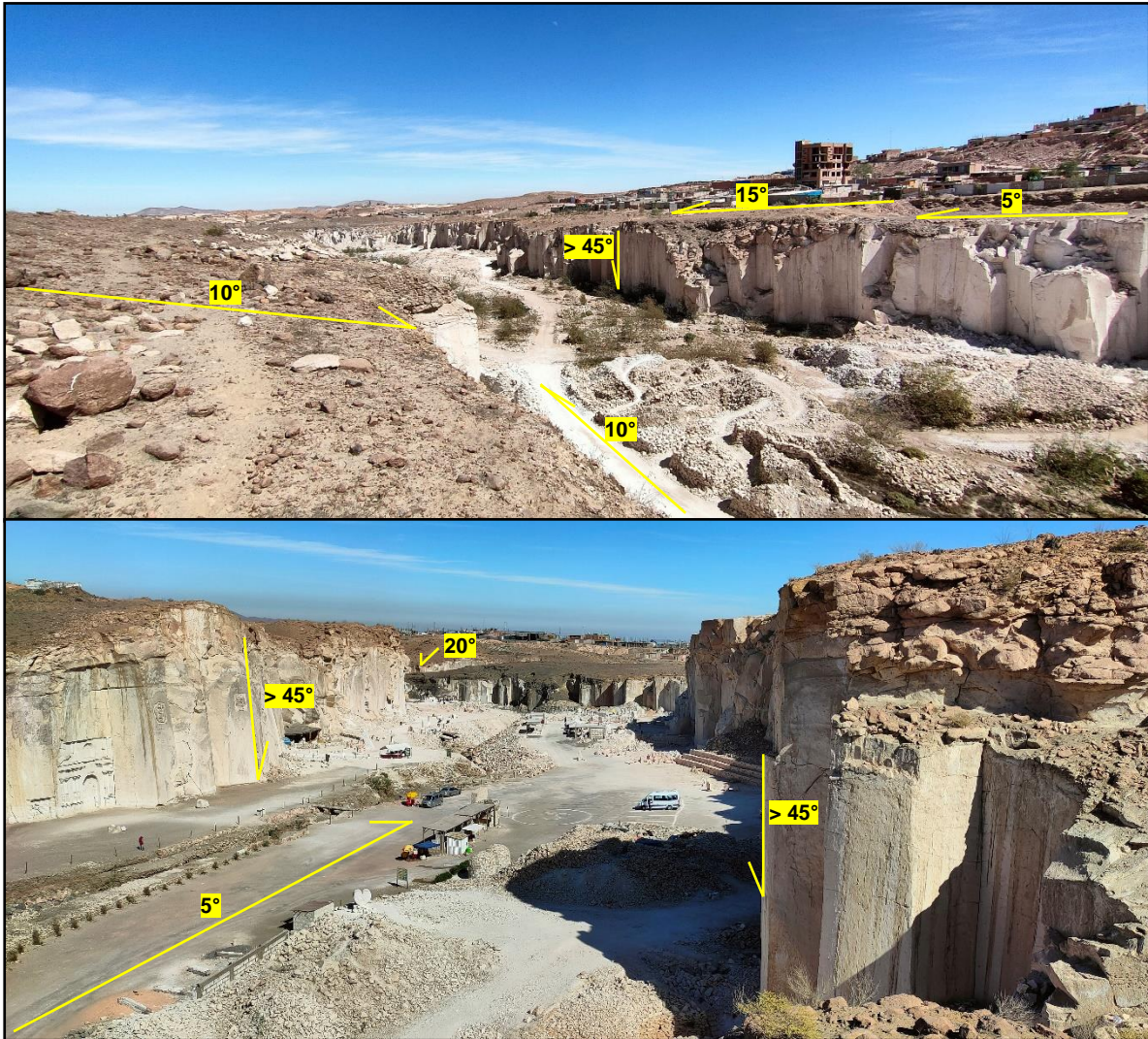
Figura 15. Tipo de pendientes del área de estudio en el sector Ruta del Sillar
