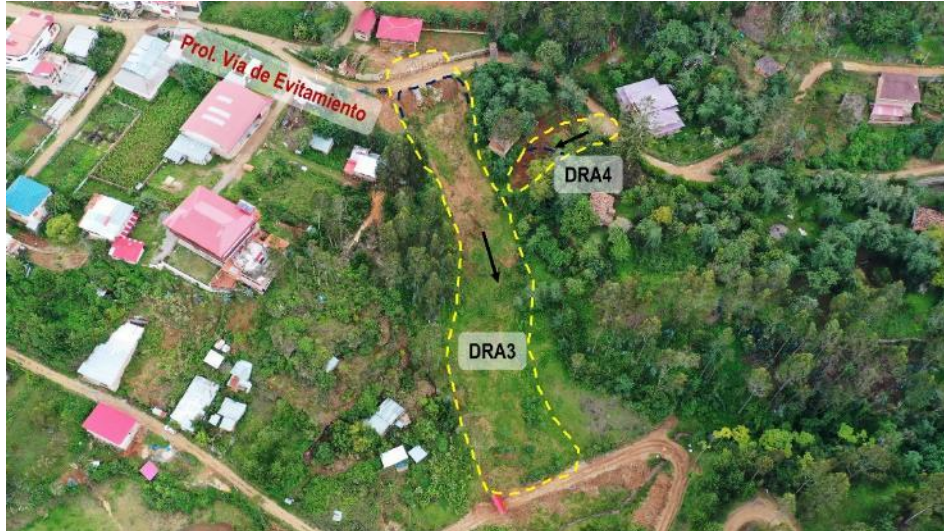
Figura 14. Vista de los deslizamientos DRA3 y DRA 4 en el sector Prolongación Vía de Evitamiento.
