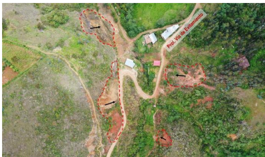
Figura 13. Derrumbes activos ubicados al sur del sector Prolongación Vía de Evitamiento.
