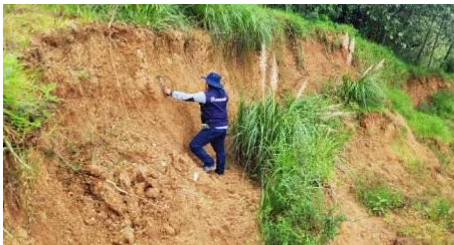
Figura 17. Salto vertical del escarpe principal del deslizamiento DRA3. Coordenadas: E: 182913; N: 9308904; Z: 2401.
