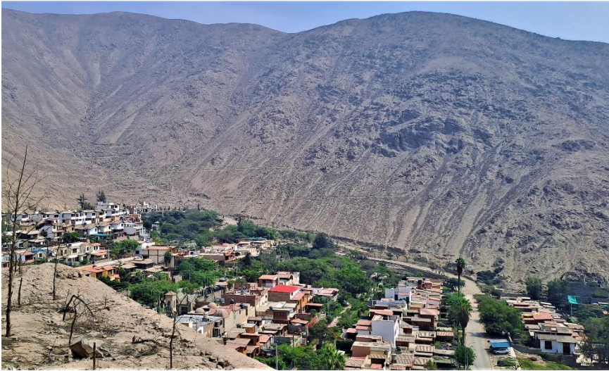
Fotografía 4. Vista panorámica de subunidades geomorfológicas de la urbanización El Cuadro conformado por montañas modeladas en rocas intrusivas y piedemonte proluvial. Coordenadas UTM: 304119.00 / 8673616.00, Zona 18.
