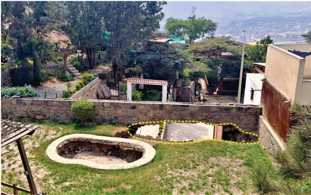
Figura 10. Con líneas discontinuas se muestra el agujero para desaguar aguas de lluvia durante el ciclón Yacu en la manzana G de la urbanización El Cuadro. Coordenadas UTM: 304222.05 / 8673756.54, Zona 18.
