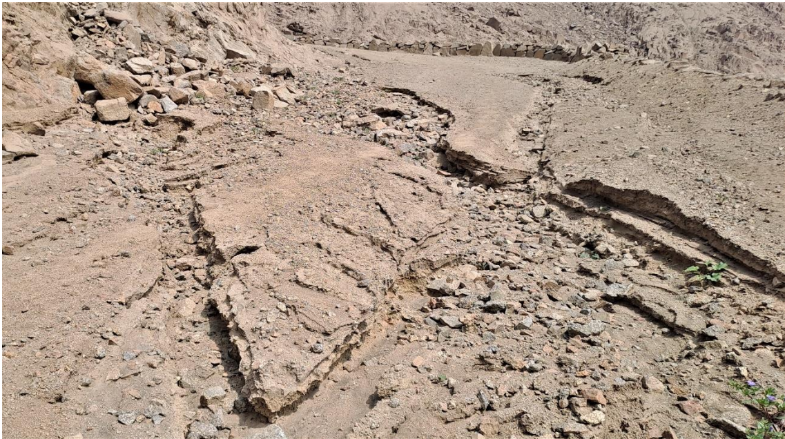
Fotografía 9. Rastros de generación de flujos de detritos durante el ciclón Yacu ubicado al noreste de la manzana I de la urbanización El Cuadro. Coordenadas UTM: 304513.00 / 8673148.00, Zona 18.
