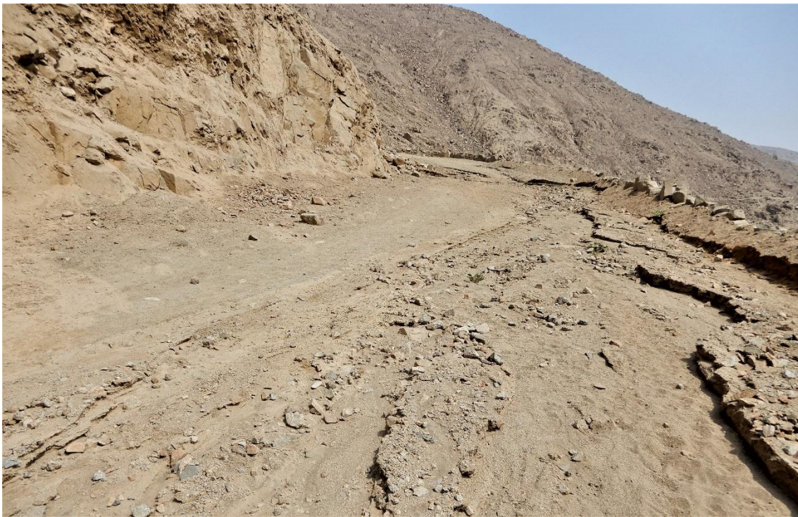
Fotografía 1. Huellas de la caída de precipitaciones pluviales ubicado al sureste de la manzana I de la urbanización El Cuadro.
