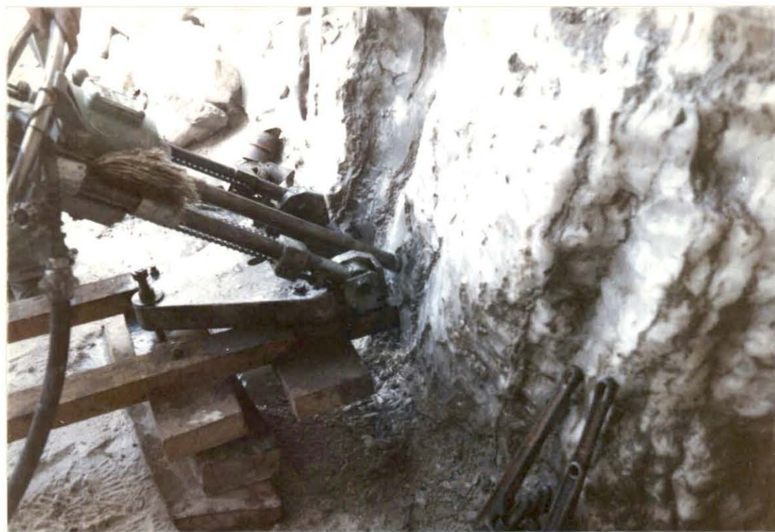
Foto 6.-Perforación inclinada con la maquina Winkie, un manto salino a la entrada de uno de los almacenes en la labor 4.
