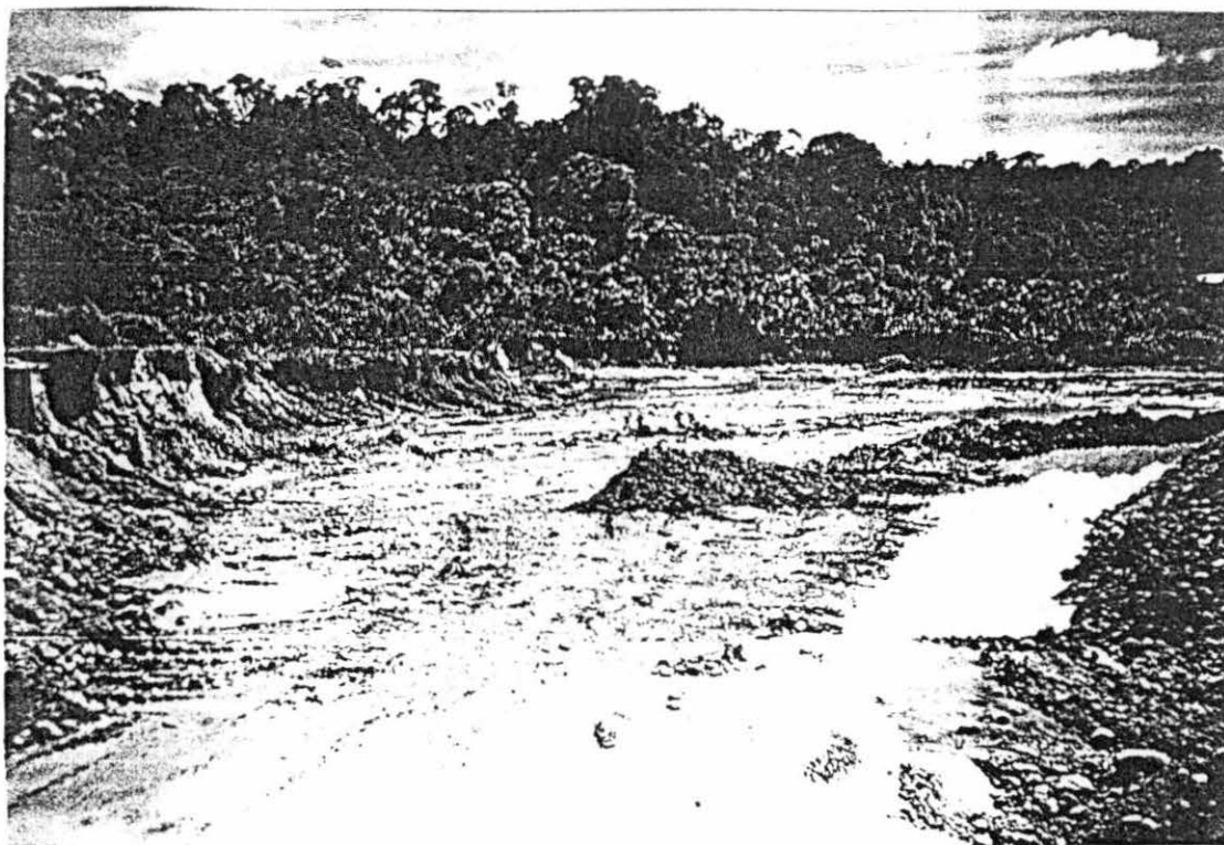
FOTO 5 : DESTRUCCION DE LAS CAPAS DE MATERIAL ORGANICO
