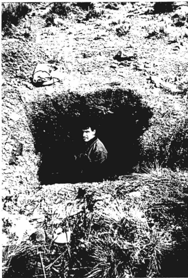
FOTO N°4 Trinchera N°8, a 2 mt. de profundidad, se obtuvo muestras frescas de la Fm. Chambará.
