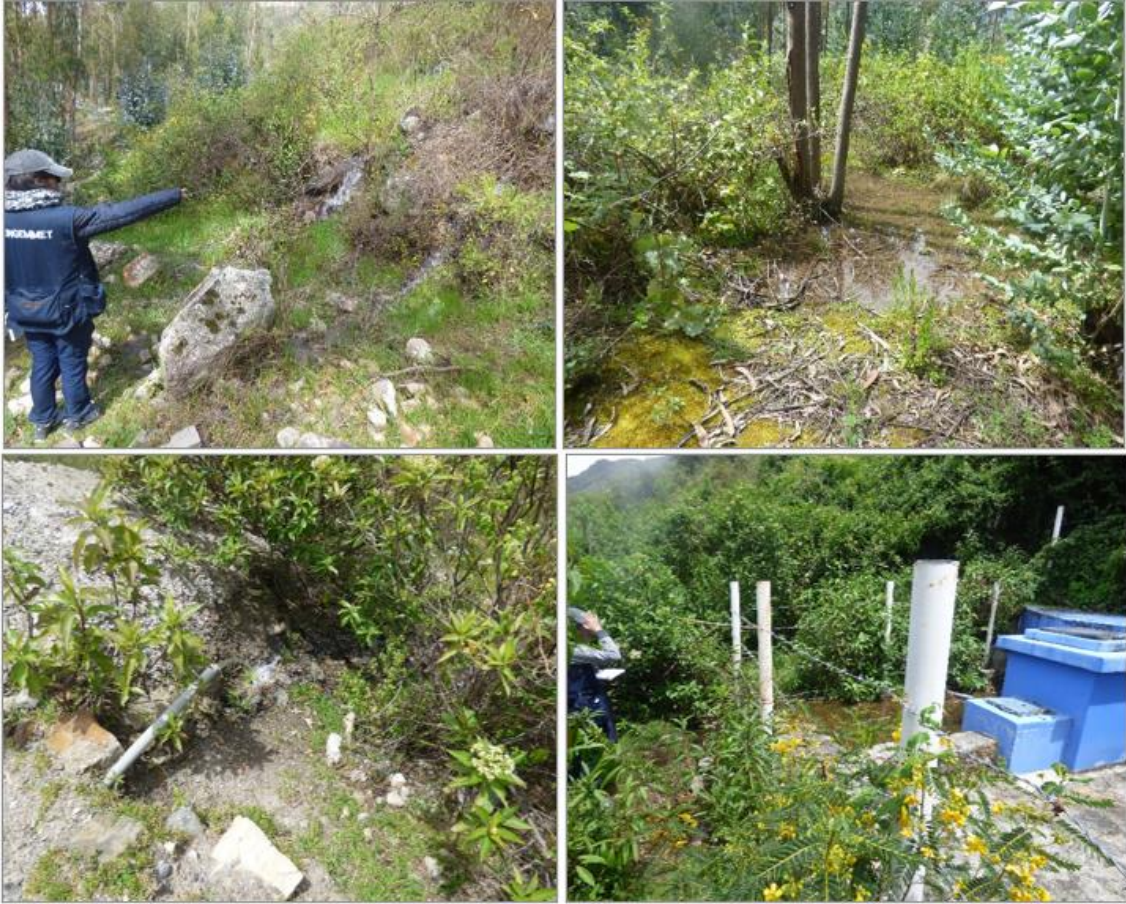
Figura 7: En la ladera se inventario 4 manantes de agua los cuales han sido captados para uso agrícola, sin embargo, parte del agua discurre por la ladera, llegando a infiltrarse pendiente abajo sobre el terreno.
