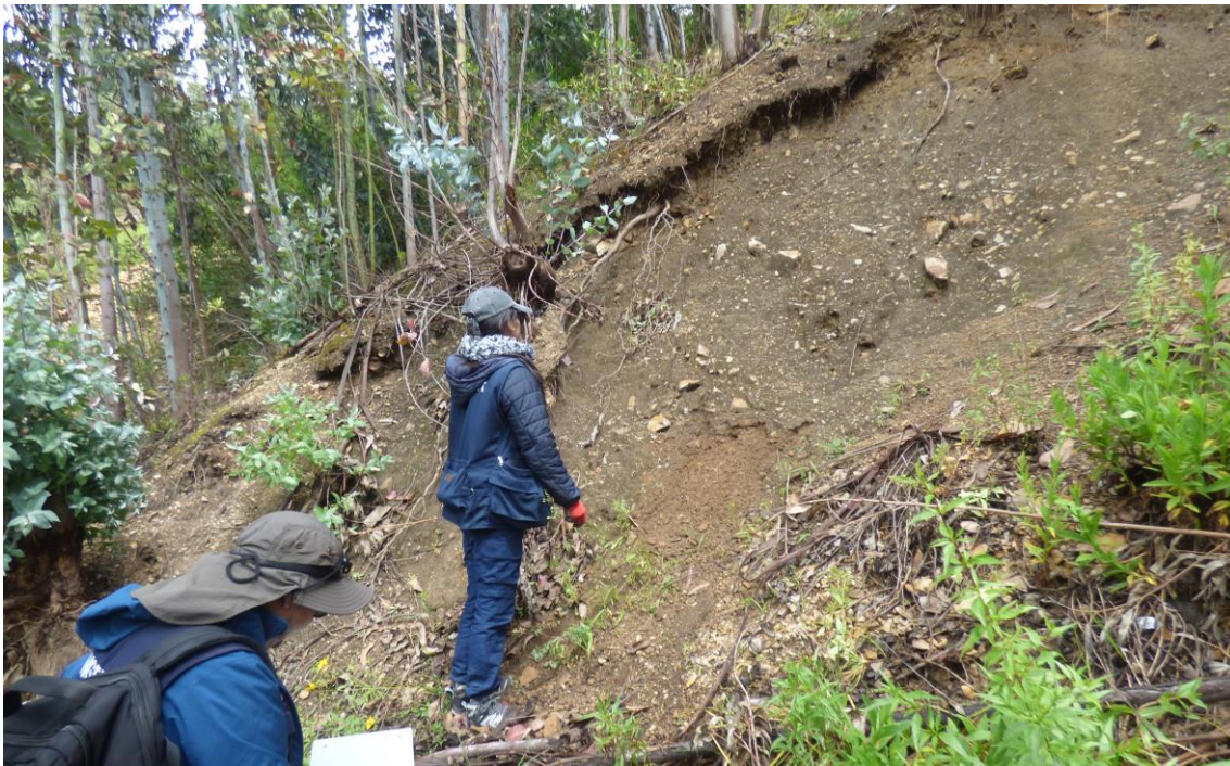
Fotografía 1: Vista del depósito coluvio-deluvial poco consolidado, compuesto por fragmentos de roca angulosos a subangulosos de tamaños variables (0.04 a 0.40 m), envueltos en una matriz limo-arenosa. Granulometría: 10% gravas, 25% gránulos, 30% arenas, 25% limos, y 10% arcillas.
