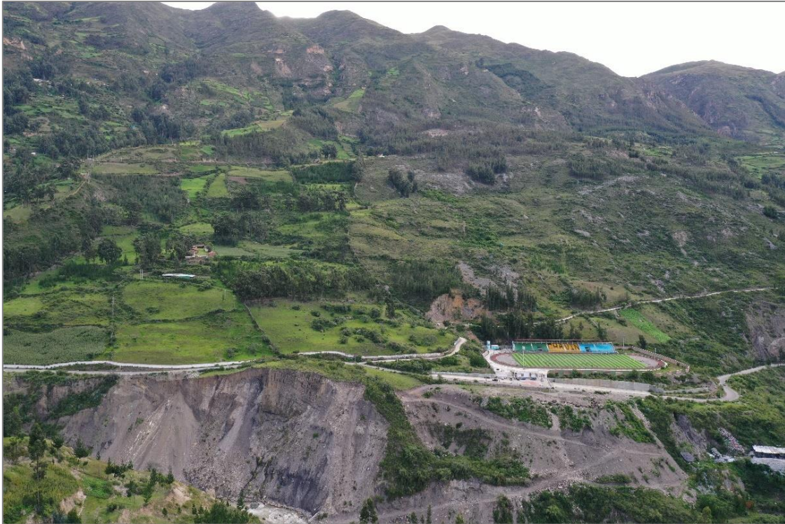
Fotografía 2: Vista de relieves ondulados por encima del estadio municipal y alrededores, aspectos indicativos de procesos de movimientos en masa como deslizamiento, derrumbes y avalanchas de rocas antiguos, activos y reactivados, ubicados en la margen izquierda del río Mosna.
