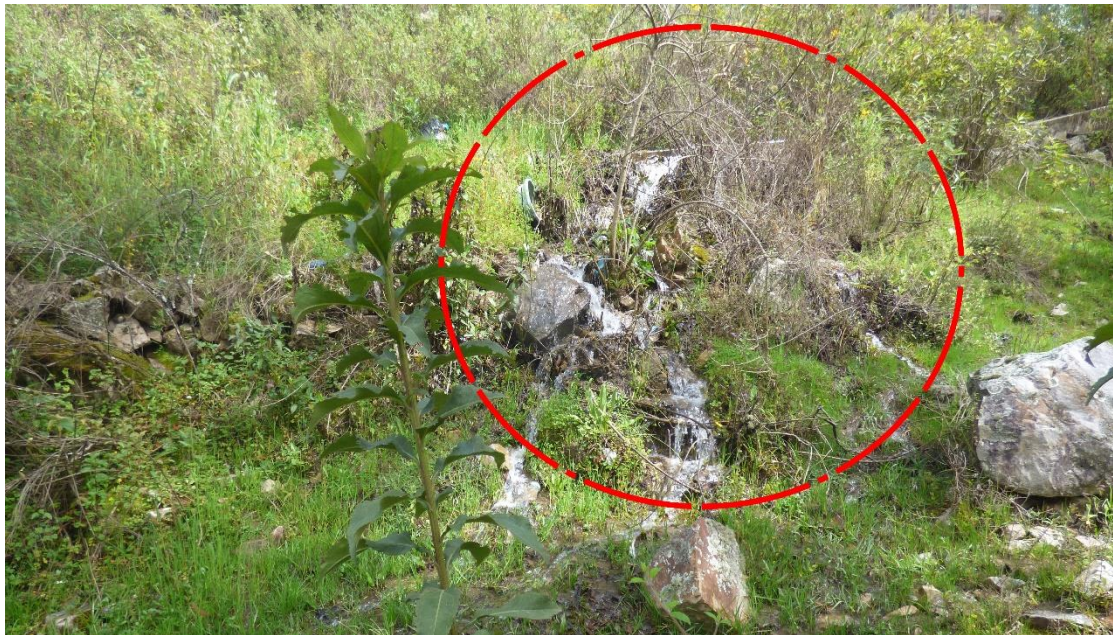
Figura 8: Canal de riego revestido hasta media ladera, lo que hace que el agua continúe su recorrido por la ladera hasta infiltrarse. Coordenadas referenciales: UTM WGS84 Zona 18S 260618 E, 8942627 N
