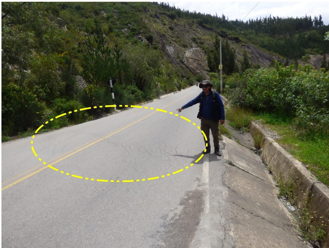
Figura 6: Deformación y agrietamientos milimétricos en la carretera Chavín de Huántar-San Marcos. Estas evidencias son indicativas de reactivaciones del deslizamiento por encima del estadio Municipal Chavín de Huántar. Coordenadas referenciales: UTM WGS84 Zona 18S 261326 E, 8942403 N.
