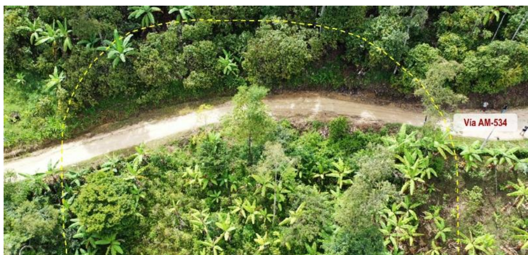
Figura 11. Vista del tramo de la vía AM-534 afectado por deslizamiento (demarcado en línea amarilla).
