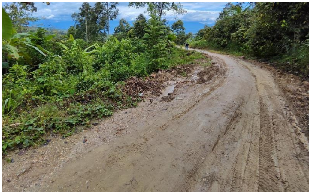
Fotografía 3. Vista de arcillas sobresaturadas en el tramo afectado por deslizamiento. Ubicación: E: 787820; N: 9378040; Z: 1308.
