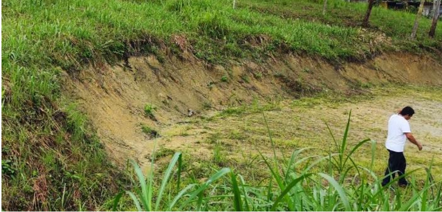
Fotografía 4. Talud excavado reciente en la parte alta de la IE 16283. Ubicación: E: 787846, N: 9378311, Z: 1322.
