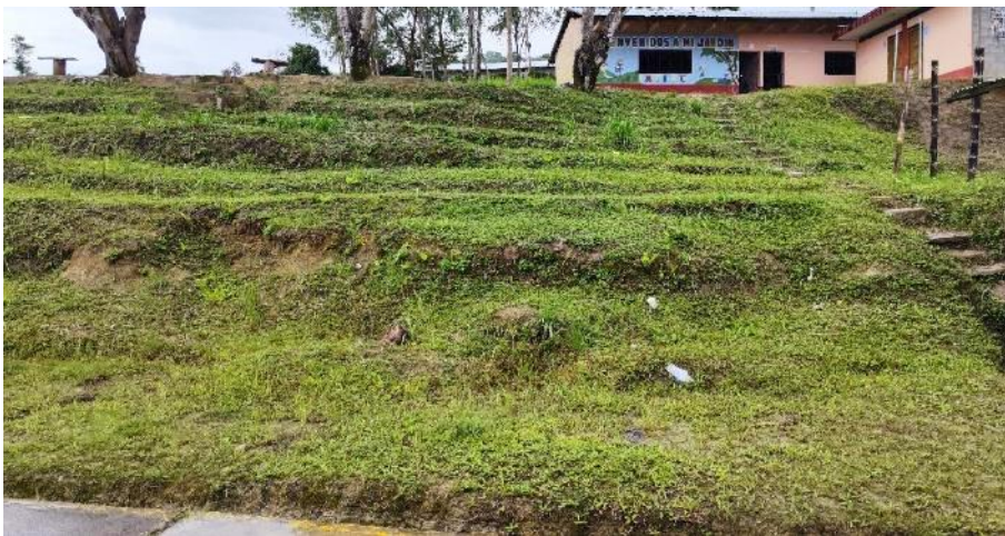
Fotografía 5. Talud excavado antiguo en la parte central de la IE 16283. Ubicación: E: 787849, N: 9378278, Z: 1318.
