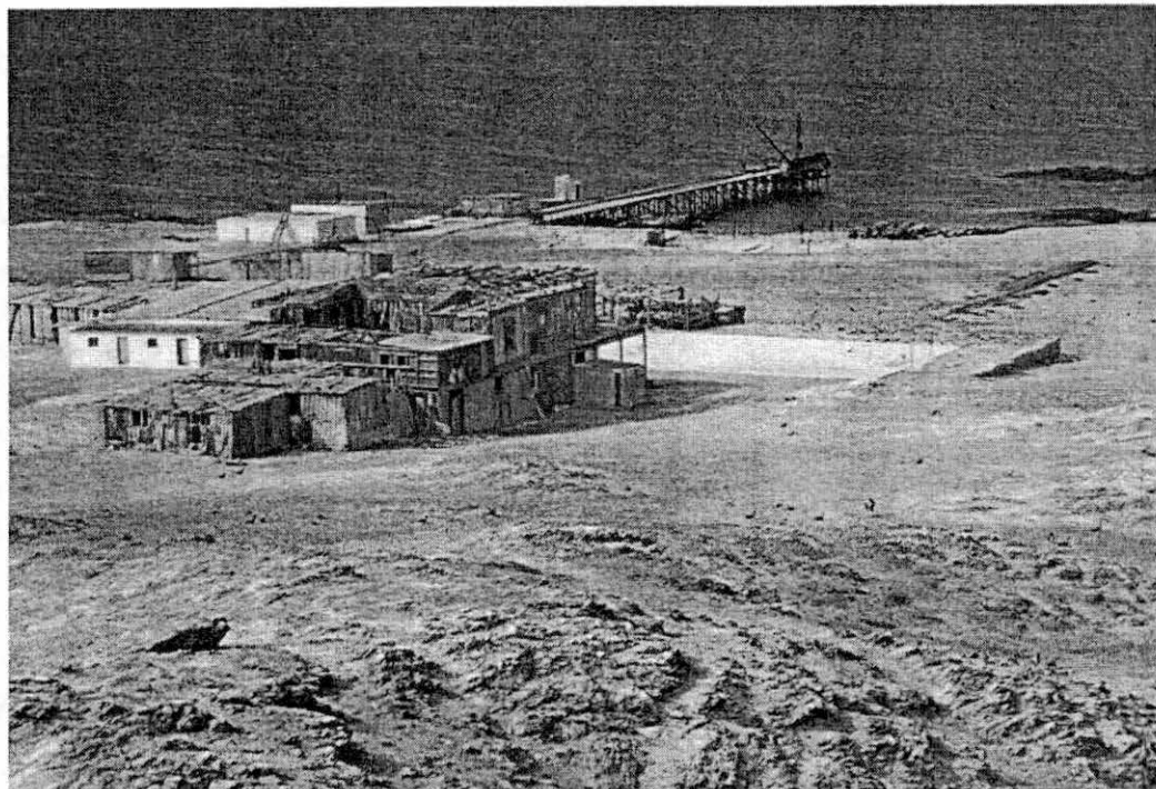
FOTO 04.- Vista panorámica del campamento de PROABONOS el que se encuentra casi al nivel del mar.
