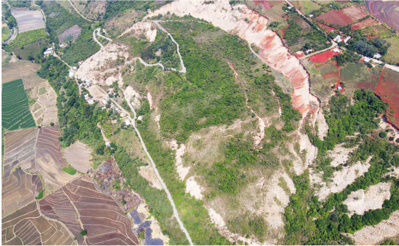
Fotografía 19. Deslizamiento en el sectr de Cunía (Chirinos-Cajamarca).
