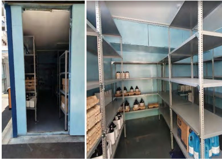
Figura 108. Almacén de insumos químicos fiscalizados
