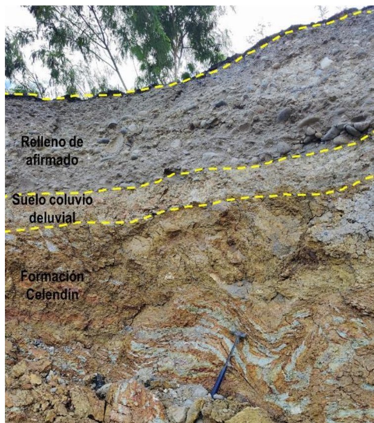
Figura 20. Detalle del escarpe principal del deslizamiento-flujo 1. En el corte se aprecia la profundidad del relleno afirmado, el suelo coluvio deluvial y la Formación Celendín infrayacente.
