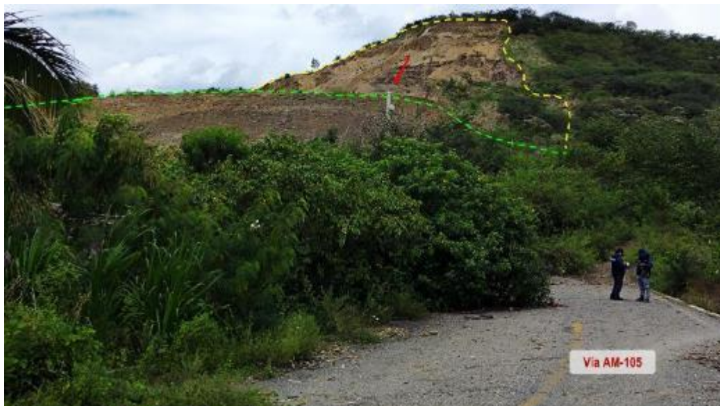
Figura 14. Vista del escarpe secundario (en línea amarilla) desde la vía AM-105 afectada por el deslizamiento; también se aprecia el material acumulado y que se encuentra en movimiento (en línea verde).
