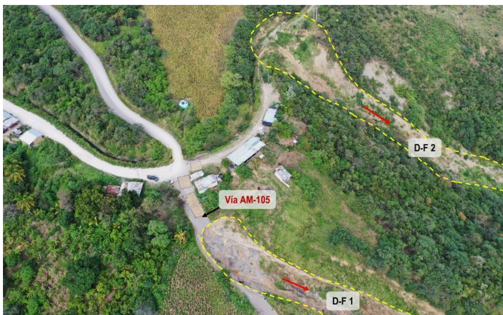
Figura 18. Vista de los deslizamientos flujos 1 (D-F 1) y 2 (D-F 2).
