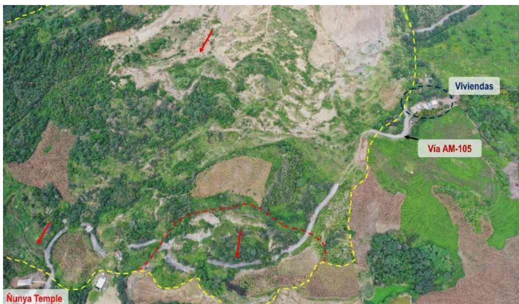
Figura 15. Parte baja del deslizamiento Ñunya Temple, se aprecian varios tramos de la vía AM-105 destruidos; el cuerpo del deslizamiento está delimitado en amarillo y el cuerpo de un escarpe secundario en rojo.
