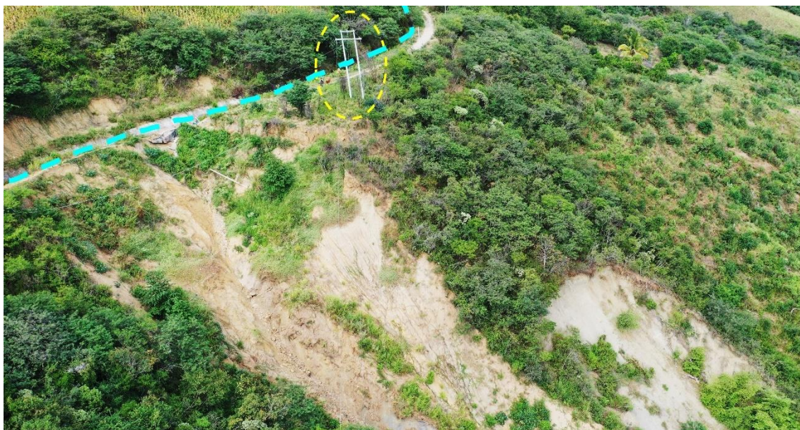
Fotografía 8. Detalle de la parte alta deslizamiento-flujo 2, donde se aprecia un canal de regadío (en línea celeste), postes de fluido eléctrico (resaltados en línea amarilla) que podrían ser afectados de continuar el movimiento.
