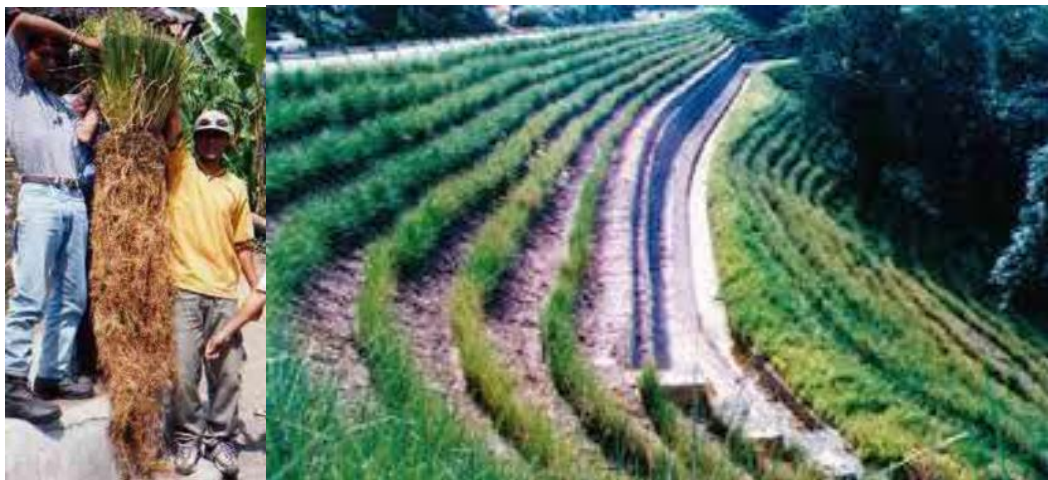
Fotografía 9. Ejemplo de bioingeniería con arbusto (vetiver) en taludes de materiales sueltos.
