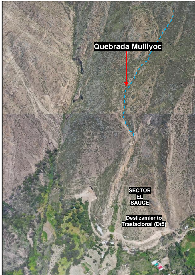
Figura 25. Quebrada Mulliyoc, ubicado en la parte alta del deslizamiento Dr5.
