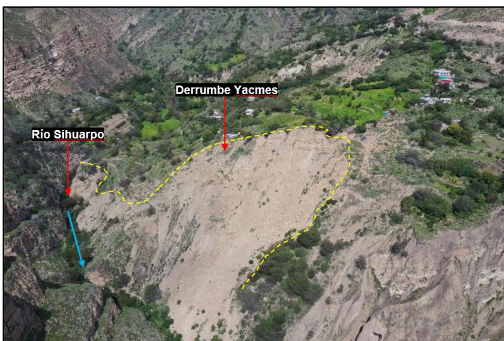
Figura 23. Vista de la zona de derrumbe en la parte baja del sector Sauce.
