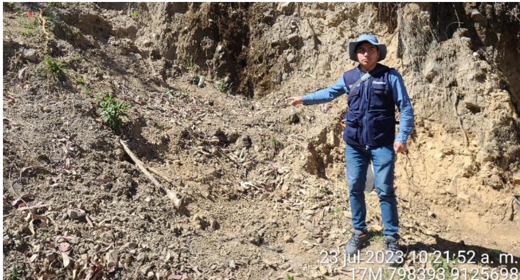
Fotografía 2. Suelos coluvio deluviales compuestos por bloques en una matriz de arenas y limos.
