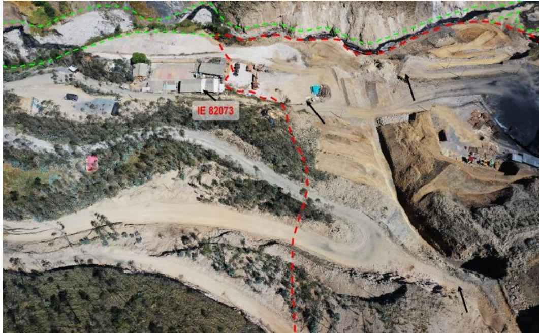
Figura 15. Vista de la parte baja del movimiento complejo La Victoria, el área afectada está delimitada en rojo, además se muestra el cauce del río Perejil (en verde) donde discurren constantes flujos de detritos.
