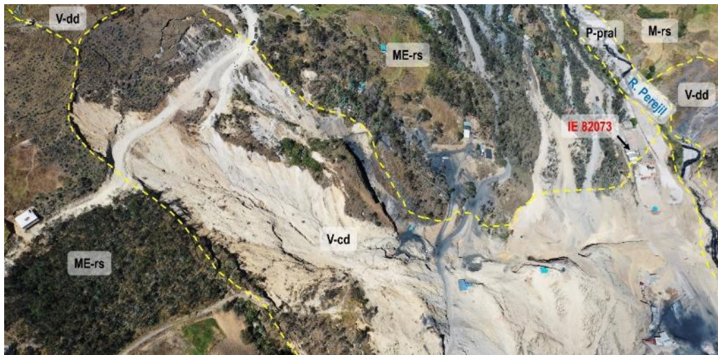
Figura 7. Geoformas cartografías en la localidad de La Victoria: Montaña estructural en roca sedimentaria (ME-rs), montaña en roca sedimentaria (M-rs), vertiente coluvio deluvial (V-cd), vertiente con depósito de deslizamiento (V-dd), piedemonte proluvial o aluvio torrencial (P-pral).
