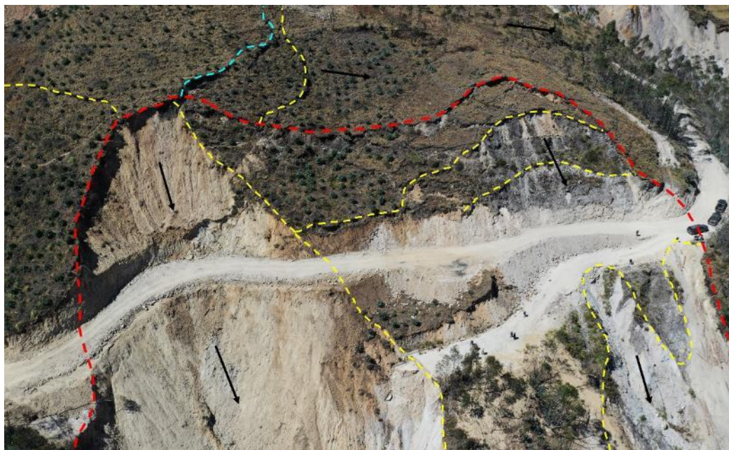
Figura 14. Vista de la parte alta del movimiento complejo La Victoria, se aprecia la corona principal del movimiento (en rojo) además de escarpes secundarios (en amarillo) y la corona de un deslizamiento (en celeste) que tiene una dirección de movimiento divergente.
