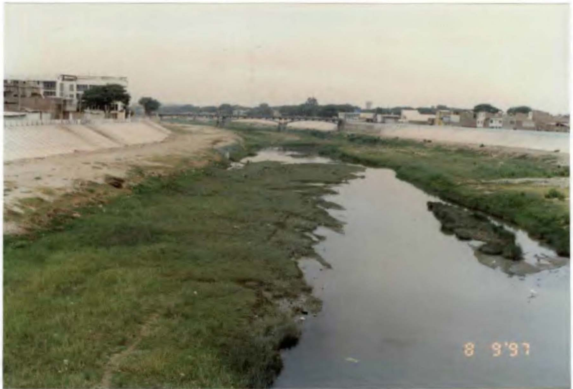
Foto N° 73. Vista tomada desde el Puente Bolognesi al Piura, obsérvese el estado del lecho del río y las aguas negras retenidas que desaguan por pequeños colectores.
