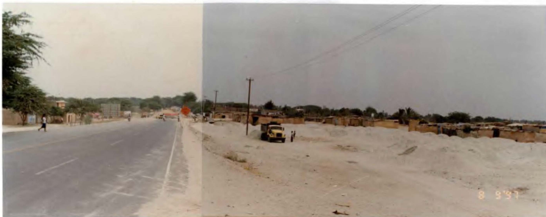
Foto N° 91. Relleno con material arenoso sin compactar en área donde se asientan los Pueblos Jóvenes Nazareno y los Jardines Norteños que posteriormente puede ser afectado por las lluvias.
