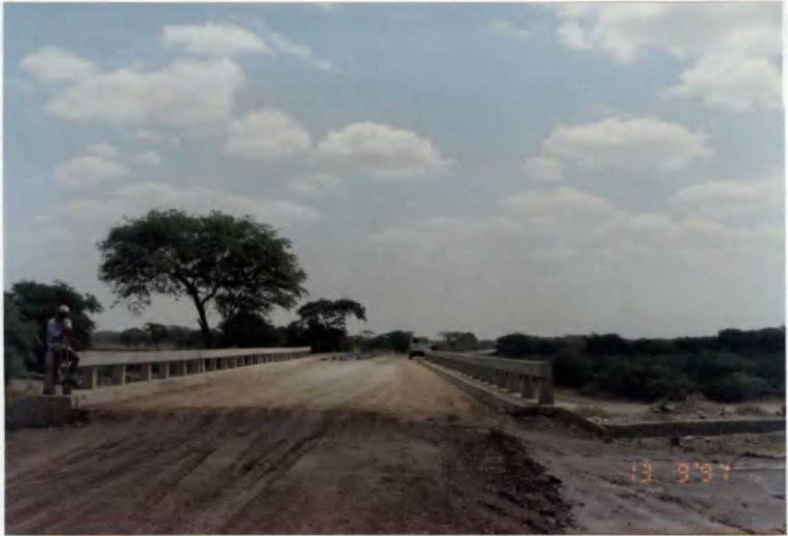
Foto N° 3. Puente Salitral donde los accesos están en proceso de asfaltado.
