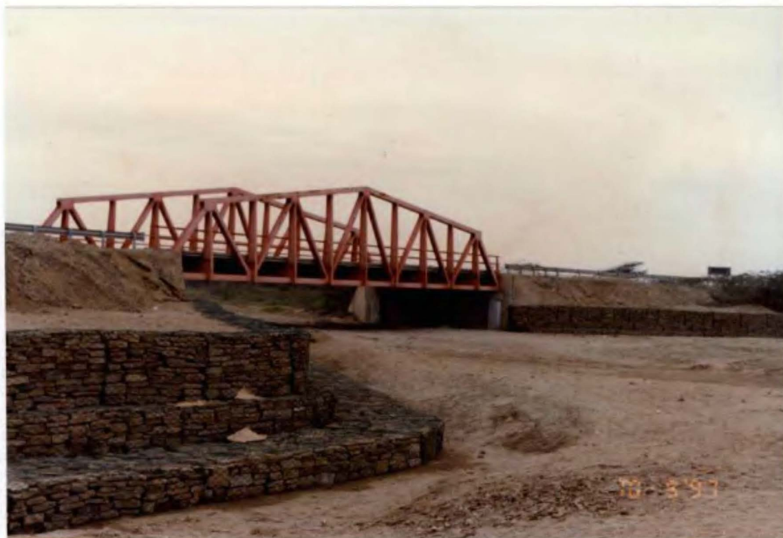
Foto N° 38. Puente El Rubio (km 1209.500 Panamericana Norte).
