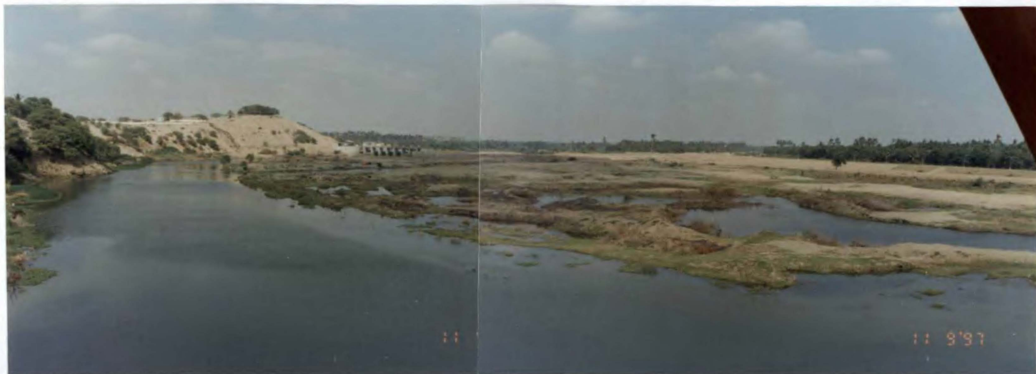
Foto N° 19. Vista tomada desde el nuevo Puente Sullana hasta la Presa de Desviación del río Chira; obsérvese el estado actual del lecho del río.
