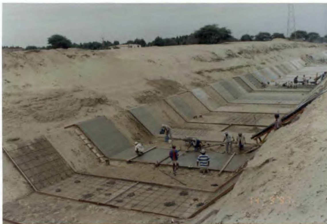
Foto N° 85. Vistas que muestran los trabajos de vaciado en el Canal La Legua, antes de llegar al Puente del mismo nombre.
