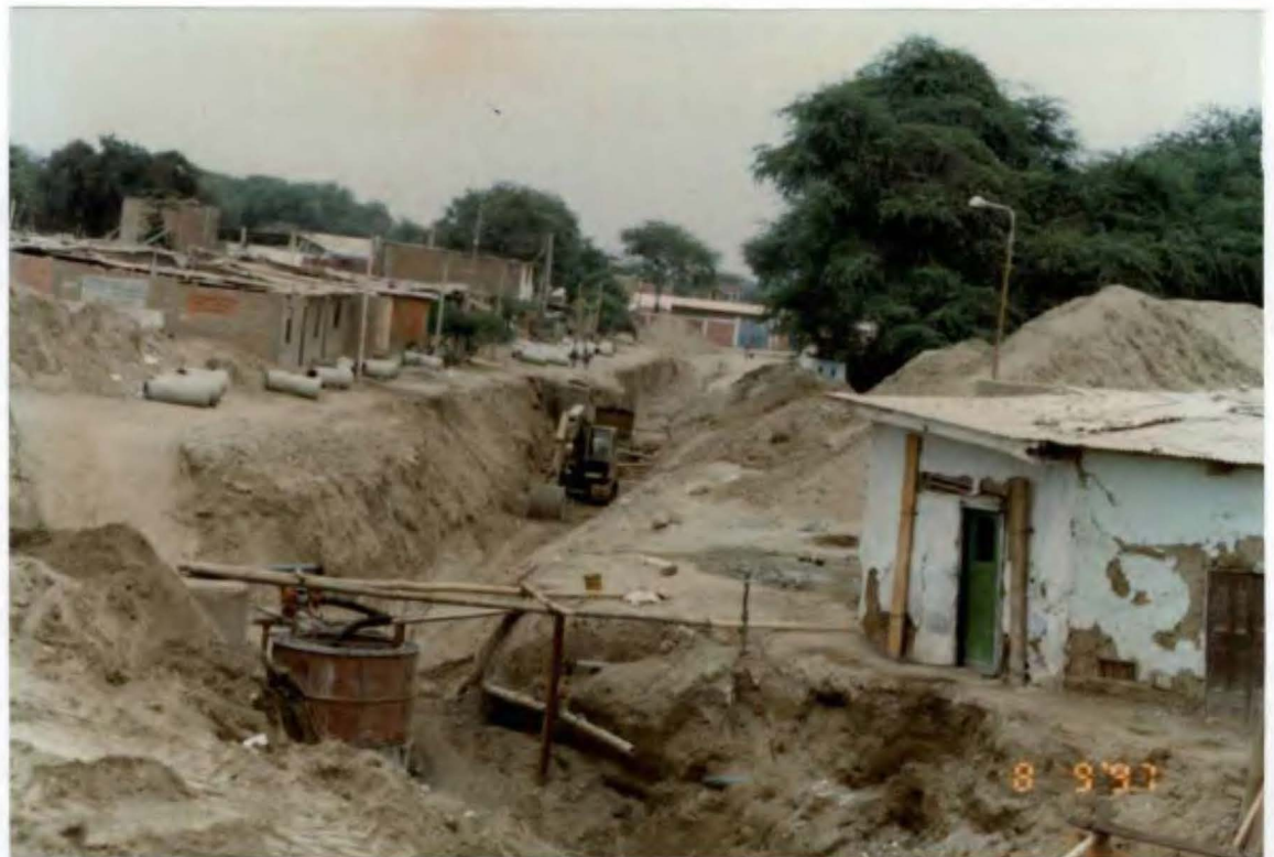
Foto N° 68. Dos vistas al estado de los trabajos en el colector de la Av. Circunvalación - Piura.
