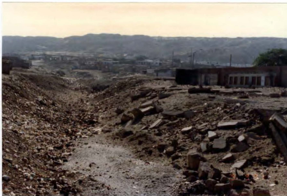
Foto N° 23. Vista del estado actual de la quebrada ubicada en el lado izquierdo del Politécnico Taboada por donde en 1983 discurrió agua que afectó sus instalaciones.
