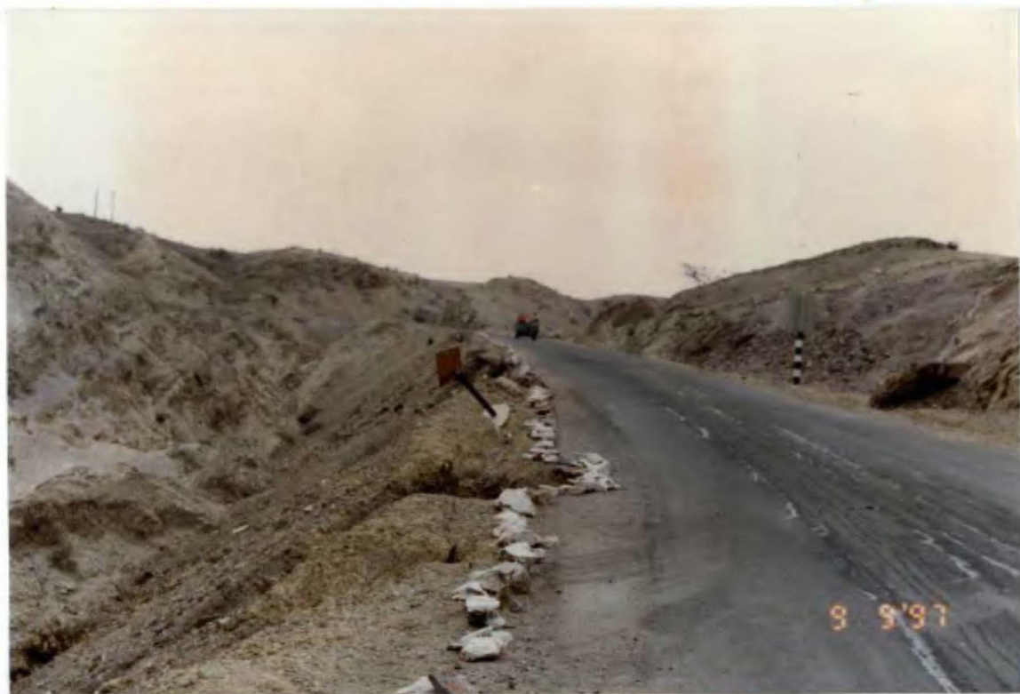
Foto N° 97. Vistas a la vía de acceso al Centro de Entrenamiento Pesquero de Paita, afectada por problemas de geodinámica externa (agrietamientos) que se intensifica en épocas de lluvias.
