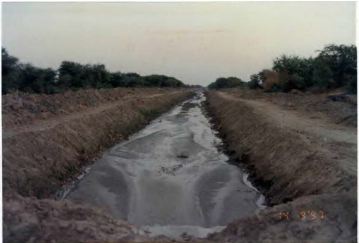
Foto N° 88. Area del km 916 de la Panamericana Norte donde se construye una batería de alcantarillas para ampliar el dren Panamericana.
