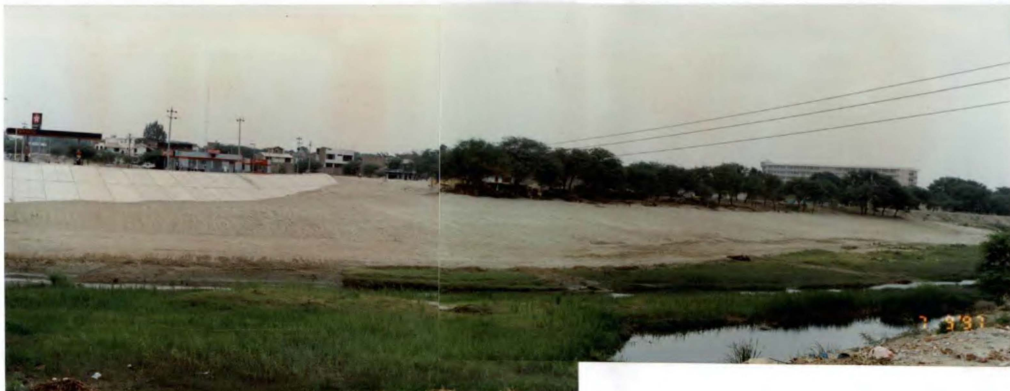
Foto N° 71. Limpieza efectuada en la margen izquierda del Río Piura, entre el Puente Mariscal Cáceres y el Hospital Cayetano Heredia. El lecho del río sin limpiar.
