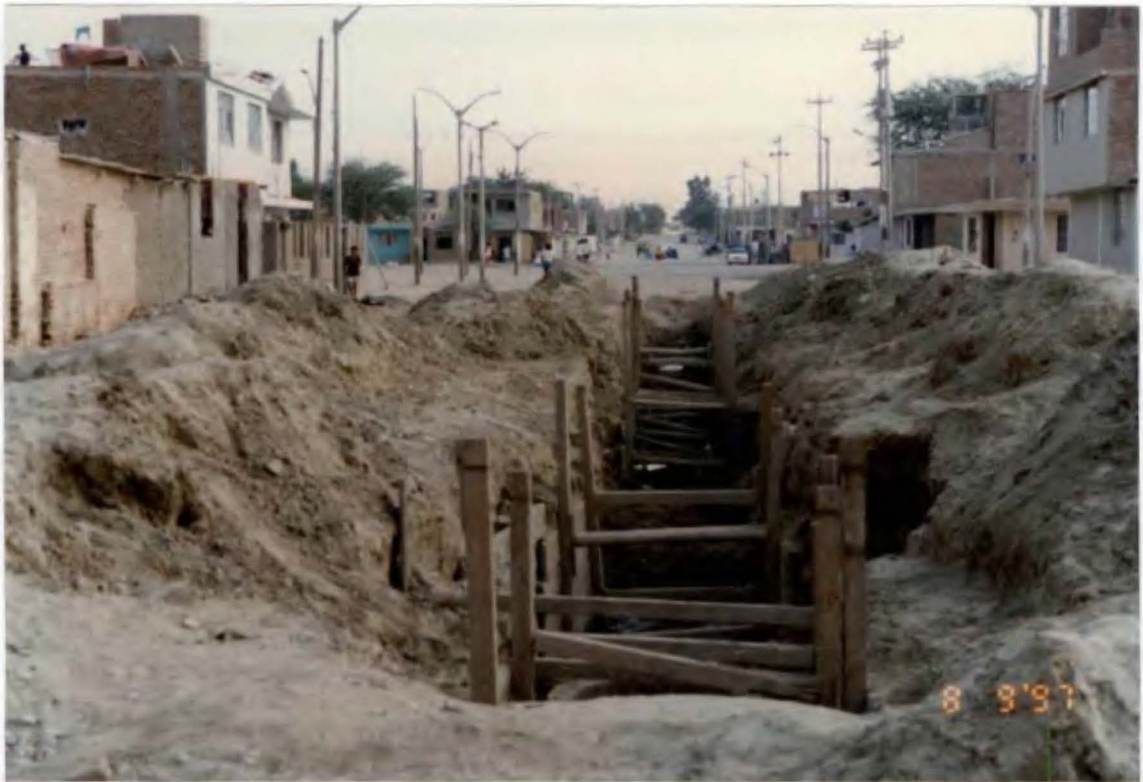
Foto N° 69. Colector en intersección Av. Circunvalación con R. Cushingier. El avance es lento.
