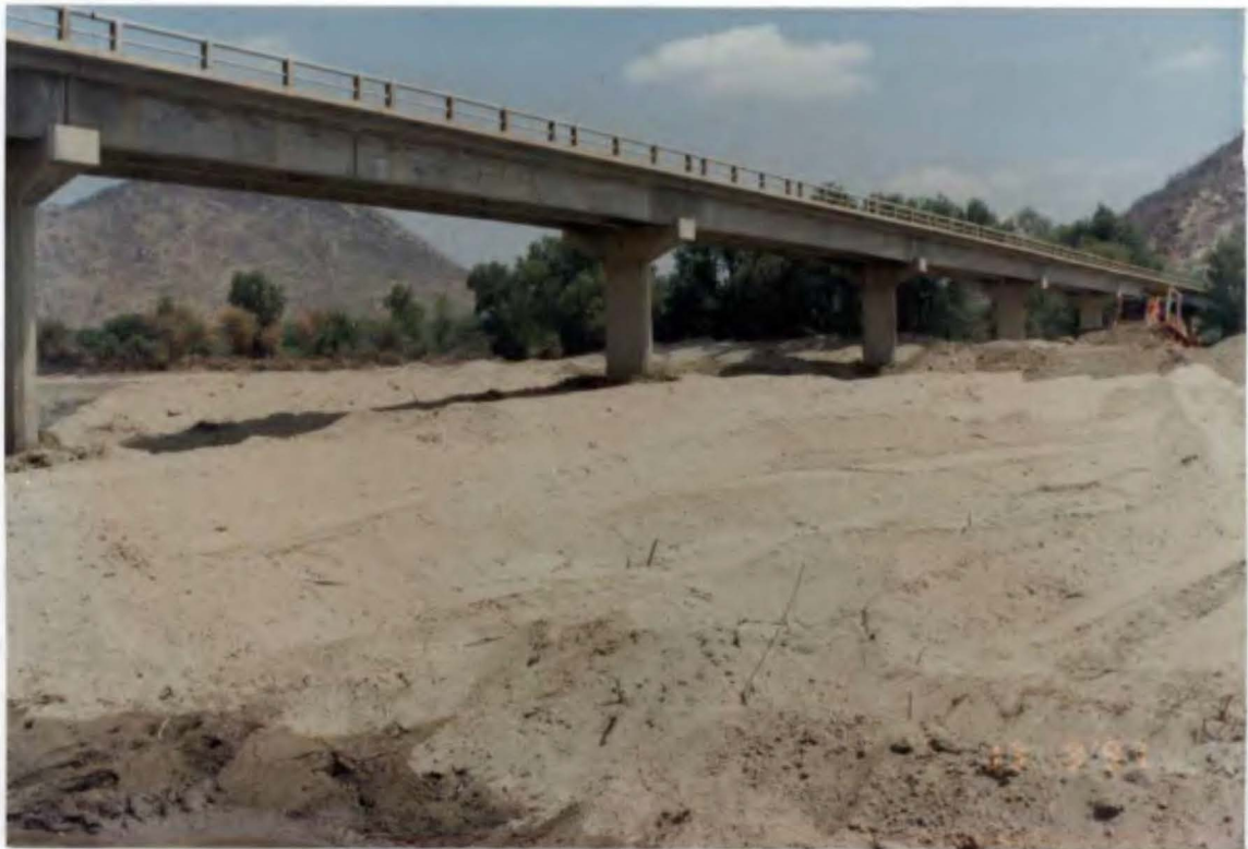
Foto N° 4. Puente Carrasquillo sobre el río Piura a la altura de Morropón donde se estaban efectuando obras de limpieza.
