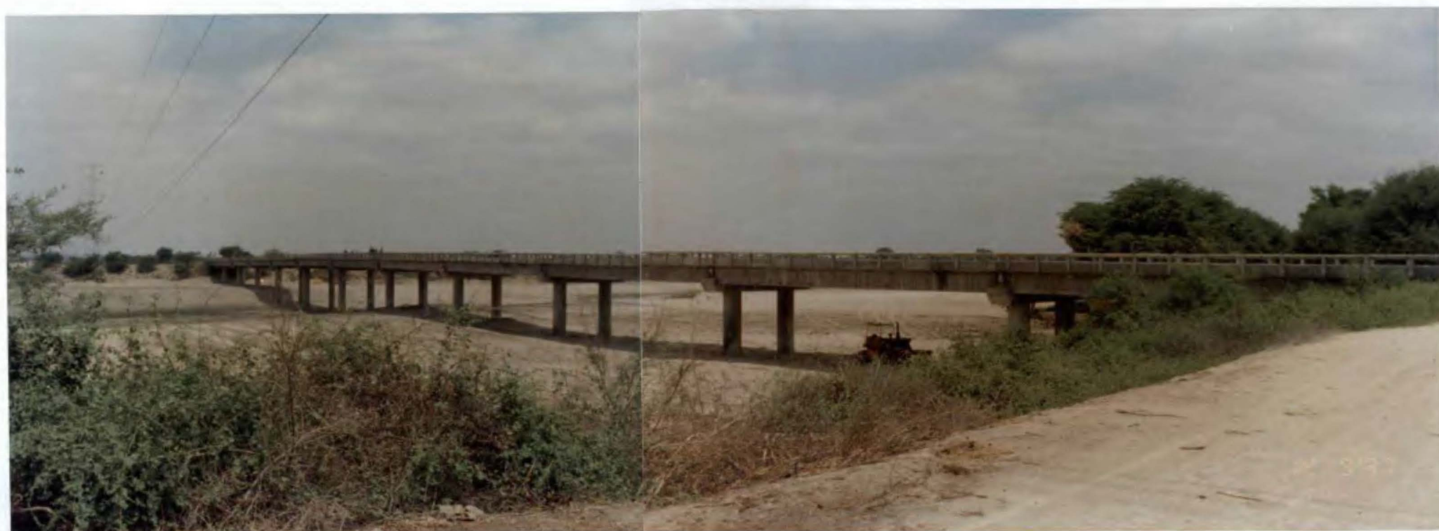
Foto N° 10. Vista de los trabajos de limpieza que se están efectuando en el Puente Grau, en la carretera Panamericana Norte.
