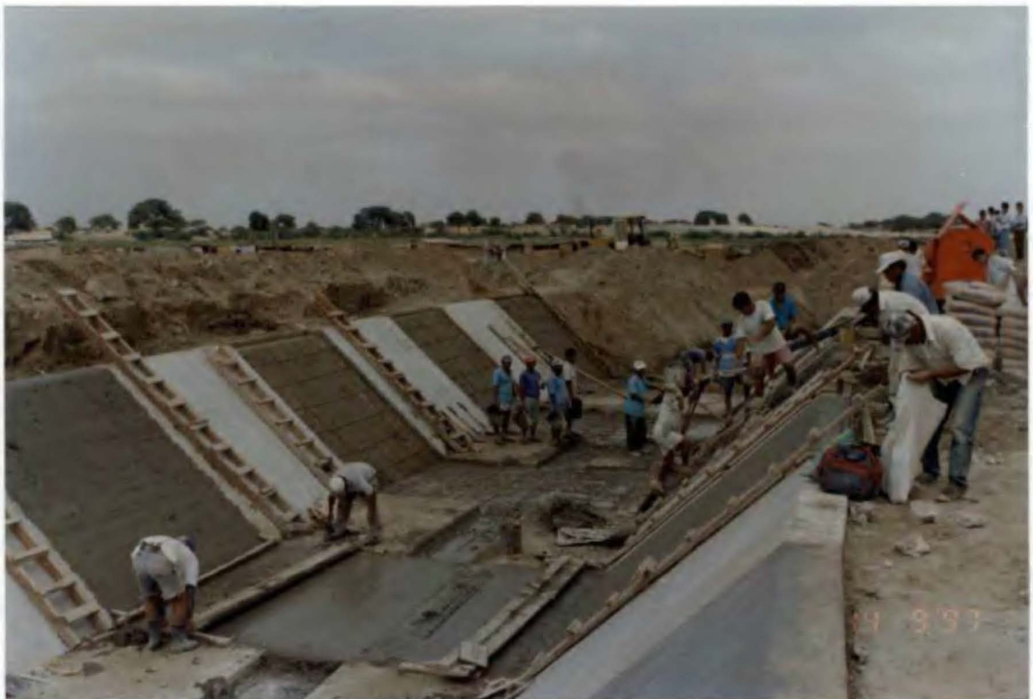
Foto N° 84. Trabajos de colocación de loza en el Canal La Legua.
