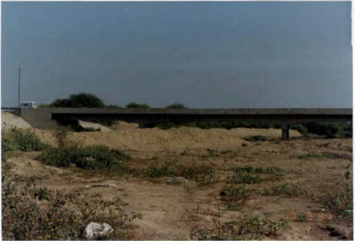
Foto N° 46. Estado del Puente Héroes del Cenepa N° 1 (km 1271 Panamericana Norte). Se ha efectuado limpieza aguas arriba.
