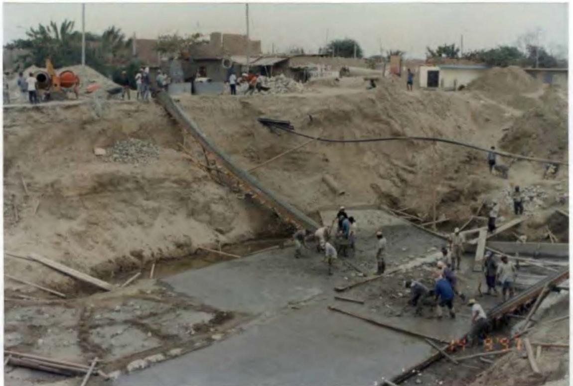
Foto N° 80. Dos secuencias de trabajos de vaciado de loza en el Pontón que se construye en la vía a Chulucanas, en lo que vendría a ser el paso del dren La Legua.
