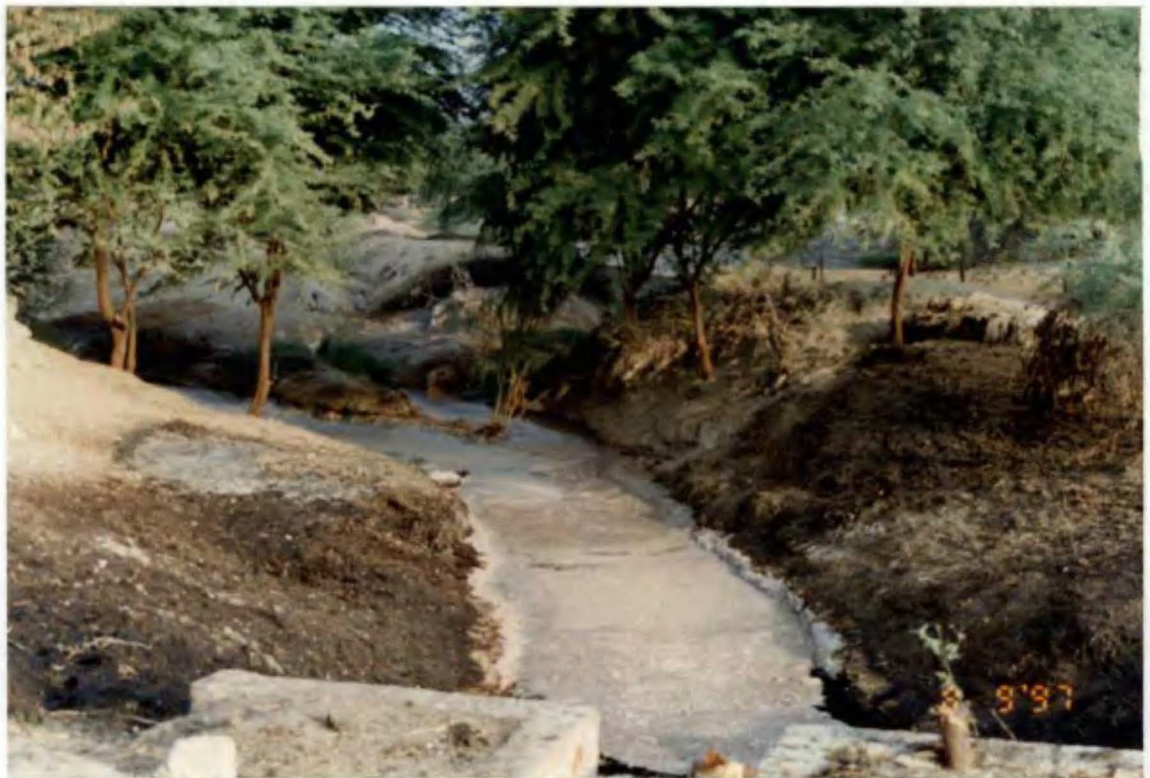
Foto N° 89. Agua contaminada de la Fabrica de aceites, jabones San Jacinto (Alicorp) que van a desembocar al dren Sechura, necesita un tratamiento especial.
