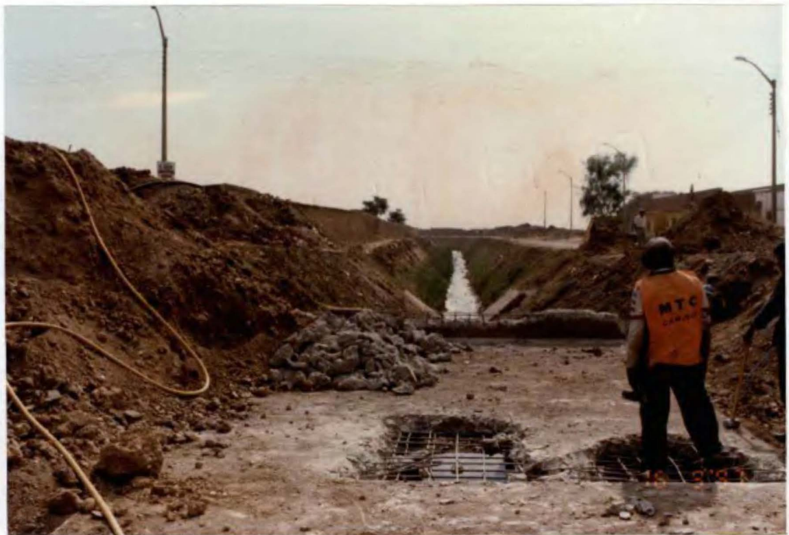
Foto N° 61. Trabajos que ejecuta el MTC en la carretera Panamericana - Sector Chacupe, donde un dren sin revestir la cruzada de este a oeste, se colocará una alcantarilla de tres ojos.
