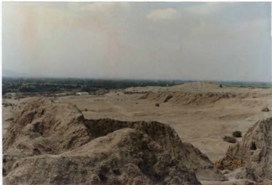
Foto N° 57. Vistas que nos muestran el estado de las Pirámides de Tucumé, zona que no está preparada para soportar un intenso periodo de lluvias como los del fenómeno del Niño.
