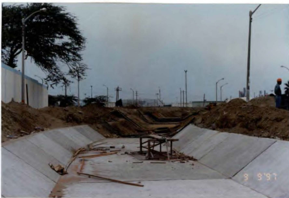
Foto N° 98. Vistas que nos muestran el estado de avance del colector de desagüe en construcción en Talara entre el Colegio Ignacio Merino y el ex Hotel Royal.
