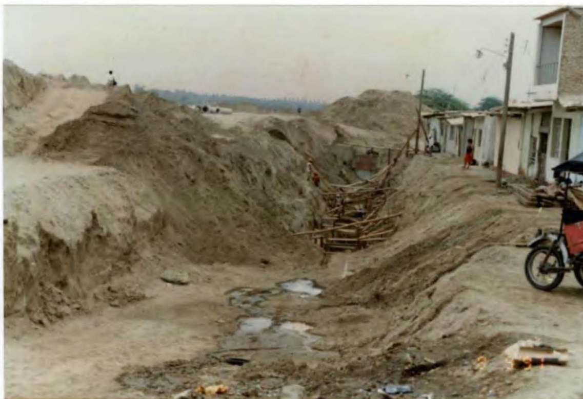
Foto N° 67. Estado del trabajo de instalación de tubería de desagüe en la Av. Circunvalación, que debe terminar a mediados de Octubre y que es necesario acelerar.
