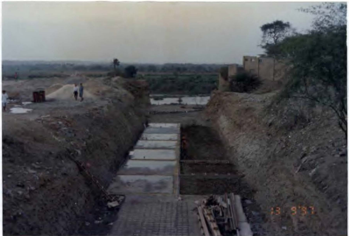
Foto N° 93. Estado de los trabajos de la parte terminal del Canal Vía Sullana de una longitud aproximada de 135 metros. Hasta la entrada al río tendrá 180 metros.
