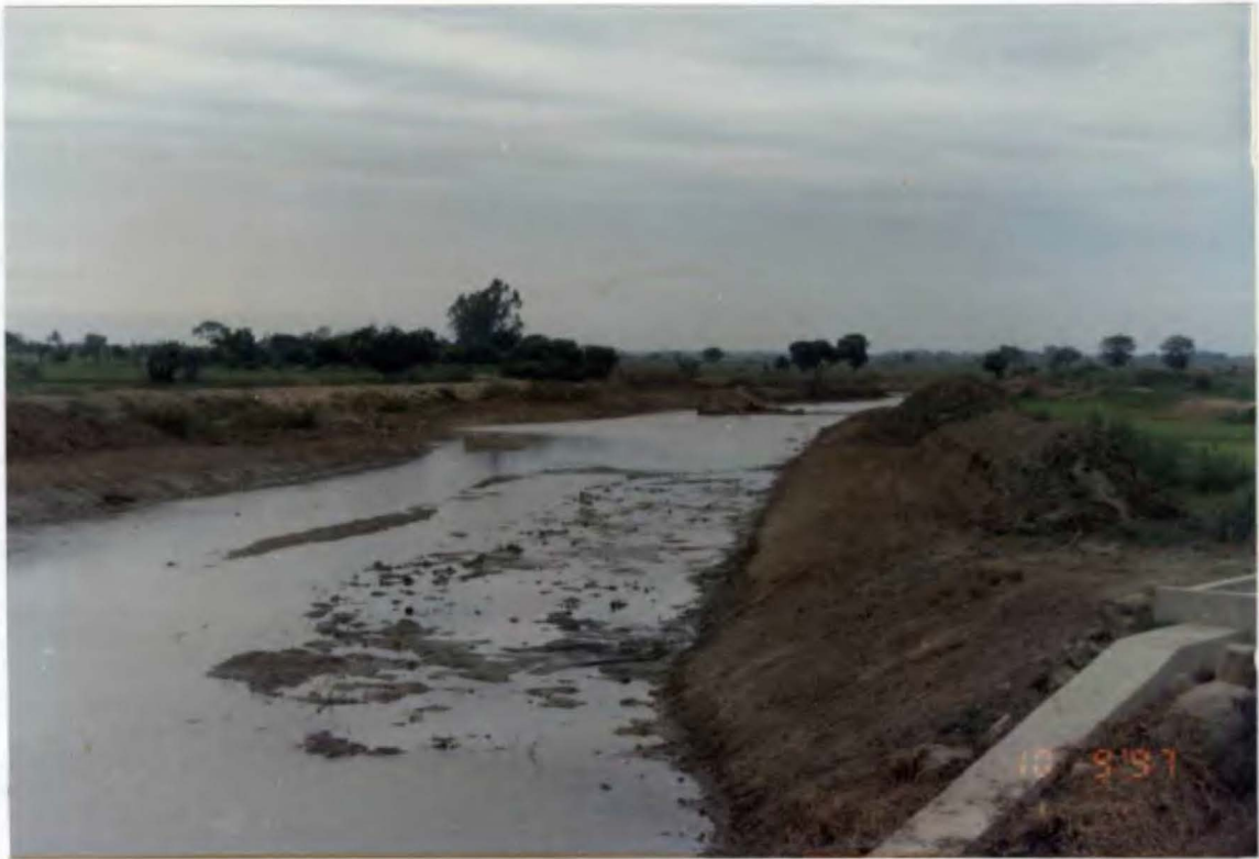
Foto N° 42. Trabajos de canalización en el Puente El Piojo.
