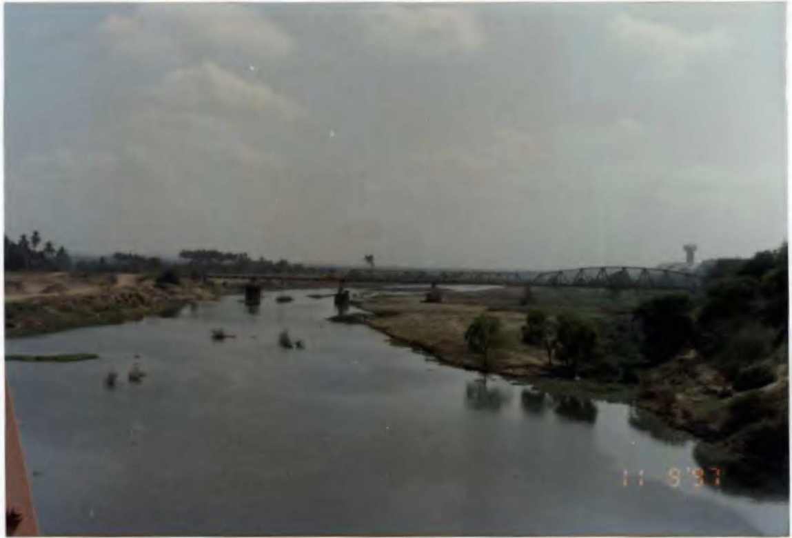
Foto N° 20. Lecho del Río Chira, aguas arriba del Nuevo Puente Sullana.
