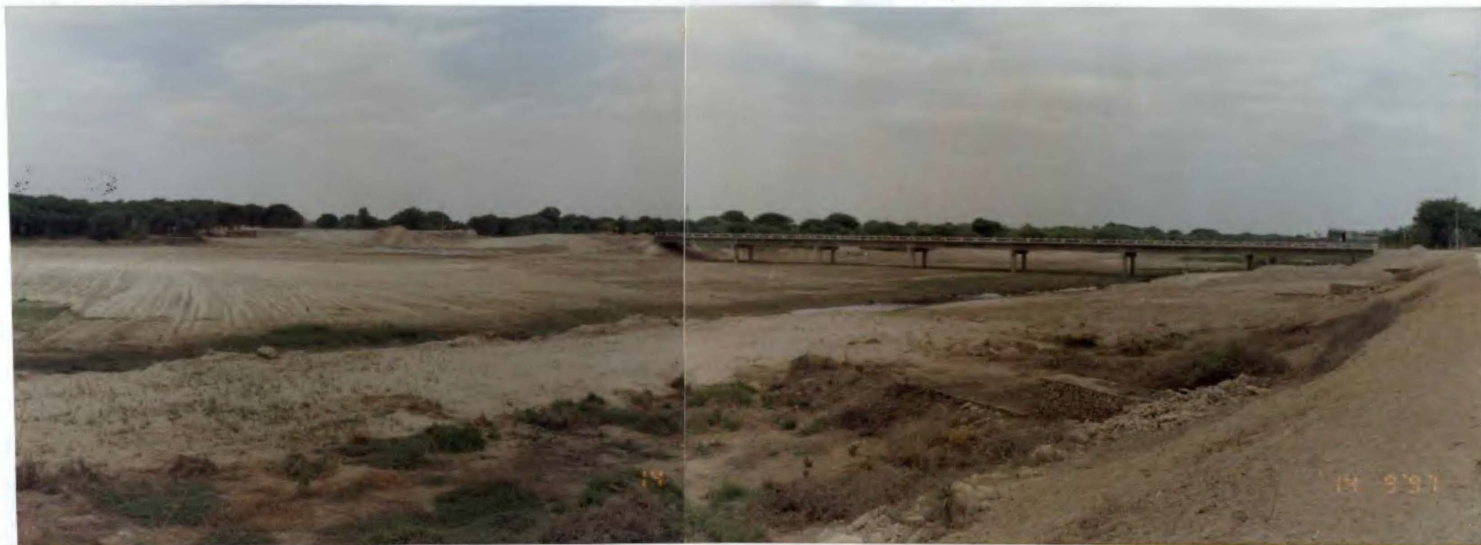
Foto N° 9. Vista al Puente Independencia en la carretera Piura - Chulucanas, donde se están efectuando obras de defensa en la margen izquierda del río Piura.
