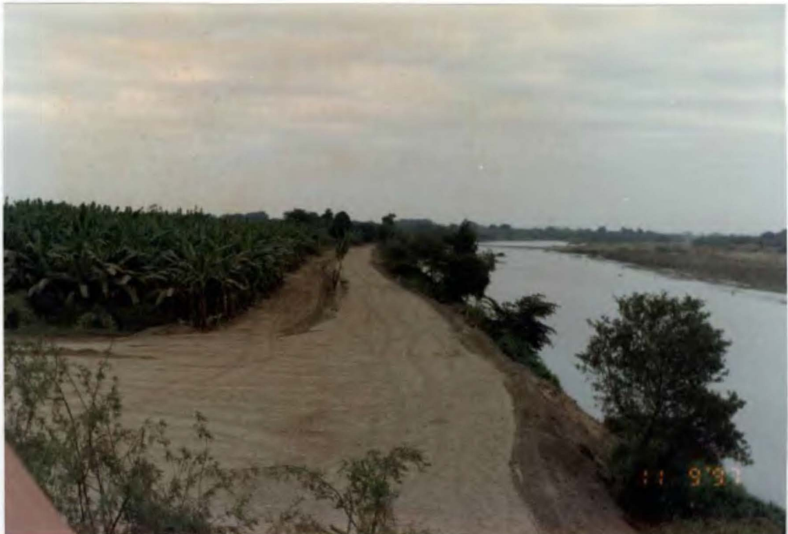
Foto N° 43. Dique de tierra en la margen izquierda del Río Tumbes, aguas abajo del puente.
