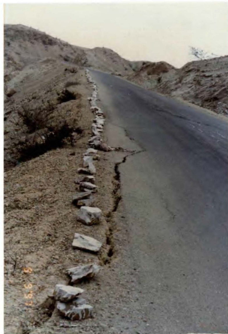
Foto N° 97. Vistas a la vía de acceso al Centro de Entrenamiento Pesquero de Paita, afectada por problemas de geodinámica externa (agrietamientos) que se intensifica en épocas de lluvias.
