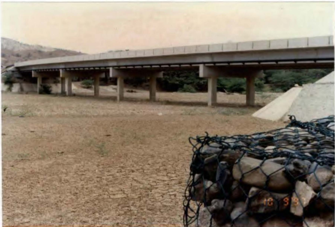
Foto N° 33. Puente Carpita (km 1182.700 Panamericana Norte). Vista de aguas arriba hacia aguas abajo.
