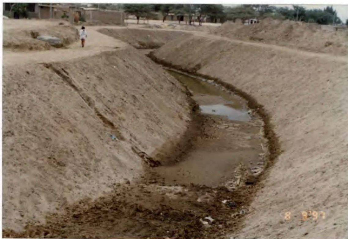
Foto N° 79. Estado del dren La Legua pasando la carretera Panamericana con dirección a La Legua.
