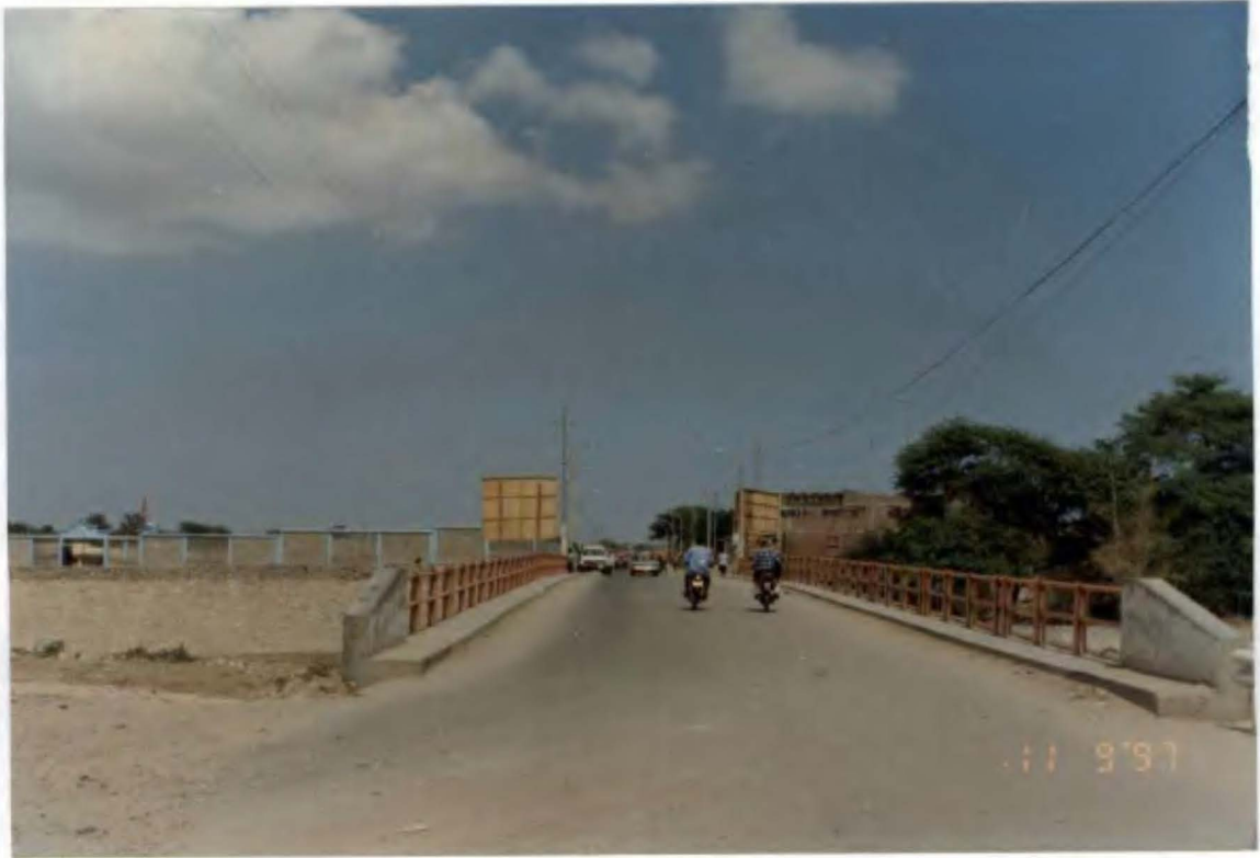
Foto N° 54. Puente Bolsico a la entrada de Zarumilla.
