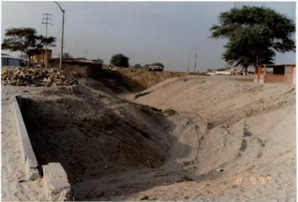
Foto N° 86. Vista al Dren La Legua en el sector del Puente La Legua; al fondo área hasta donde se encontraba el avance de los trabajos que viene del este.
