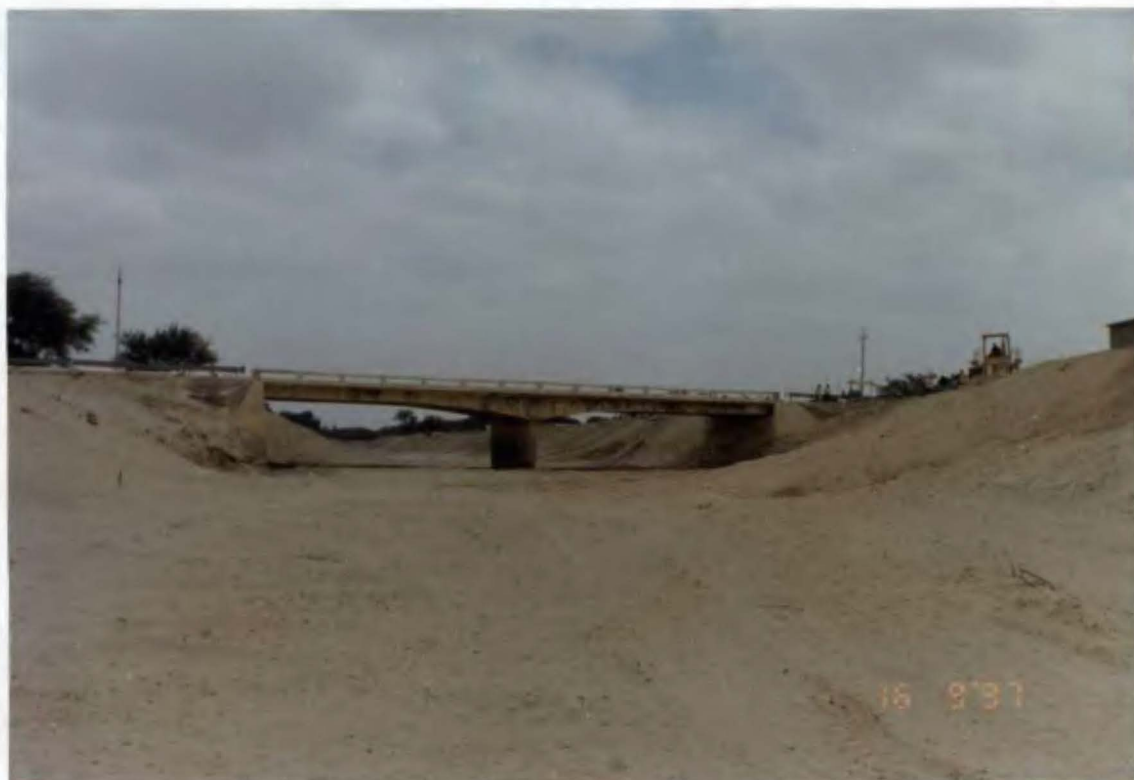
Foto N° 1. Puente La Leche (km 26.500 de la carretera Lambayeque - Olmos), donde se ha efectuado limpieza de cauce.
