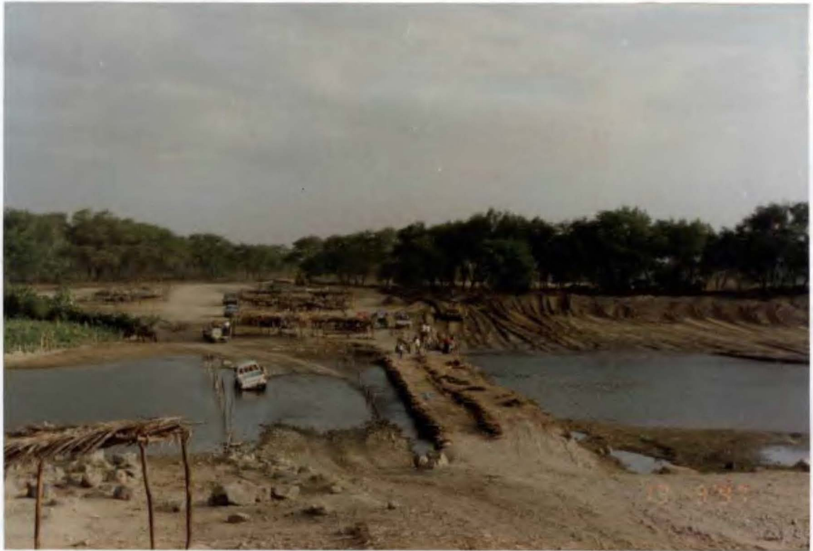
Foto N° 8. Puente provisional sobre el río Piura en Tambogrande en una trocha que comunica a este pueblo con el km 21 de la carretera Piura - Chulucanas.
