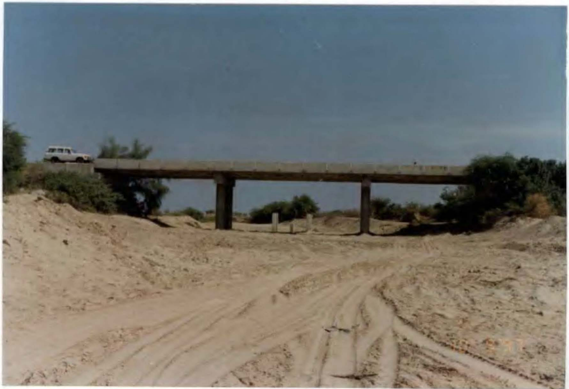
Foto N° 49. Estado de los trabajos ejecutados en el Puente Tronco Seco. (km 1279.800 Panamericana Norte).
