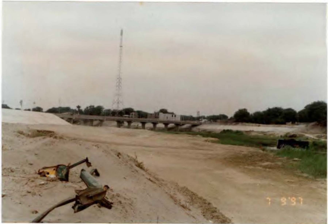
Foto N° 14. Puente Mariscal Cáceres - Piura (tomada de aguas arriba a aguas abajo)
