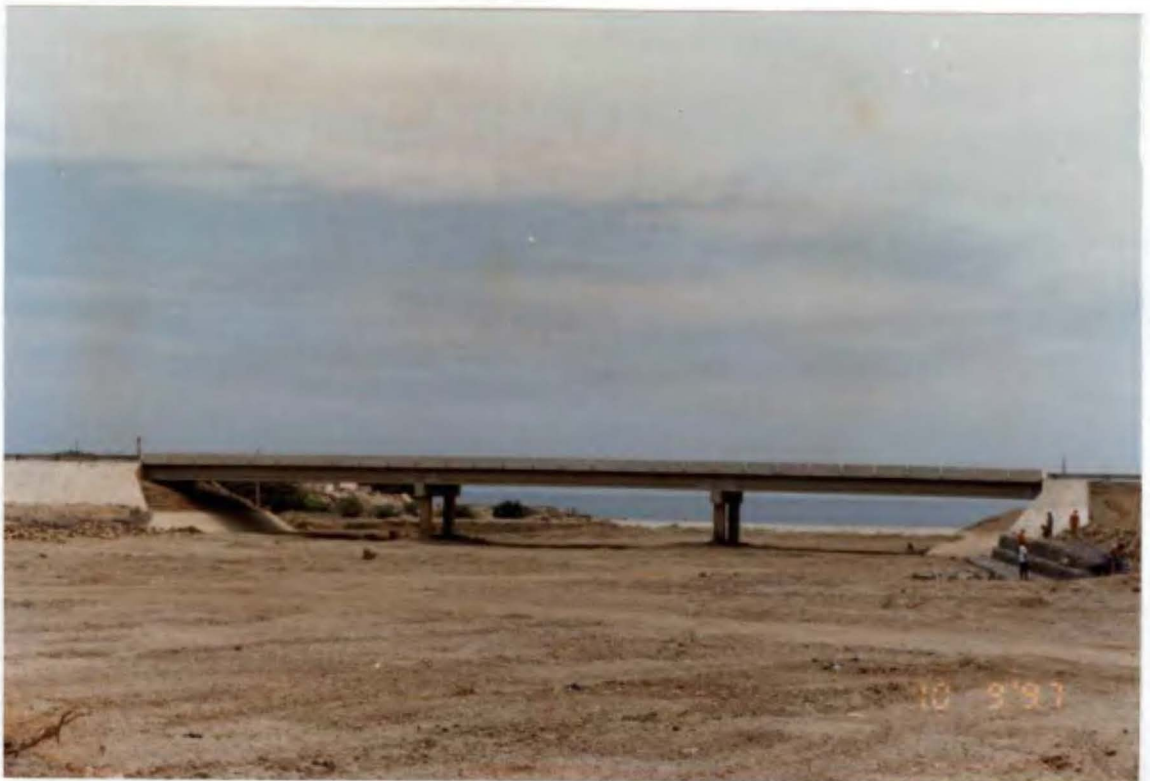
Foto N° 31. Puente Mancora, se ha limpiado el cauce y se están colocando gaviones en ambas márgenes.
