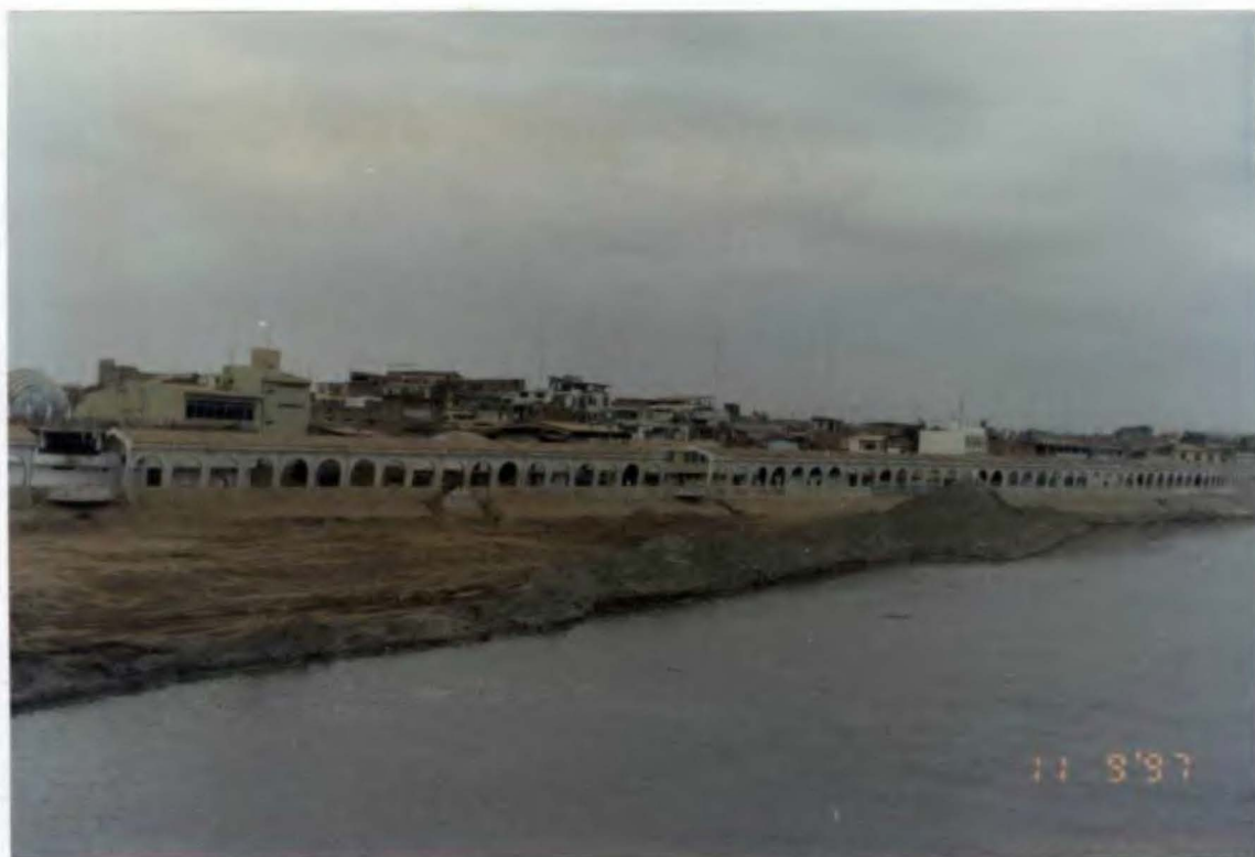
Foto N° 44. Trabajos de limpieza de material sedimentado en la margen derecha del río Tumbes, aguas arriba del Puente.
