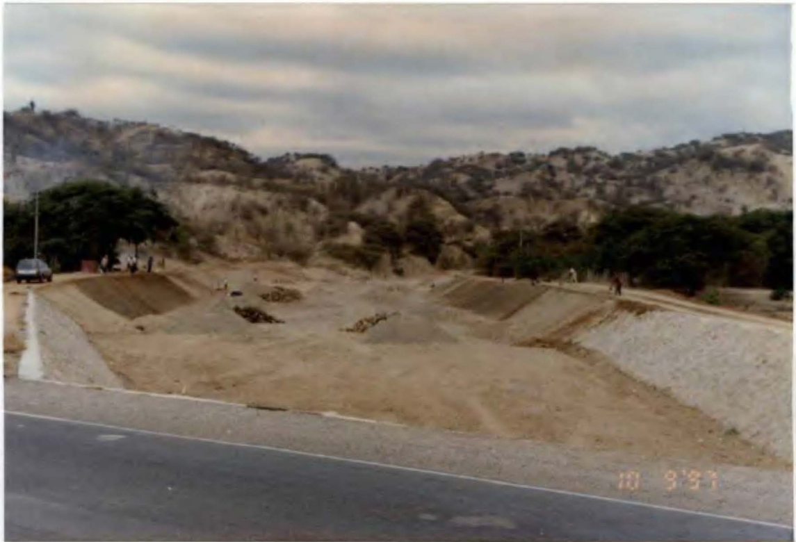
Foto N° 40. Canal La Jota con muros ciclópeos en el área de acceso a la alcantarilla. Se están alistando los taludes de las márgenes, lecho limpio.
