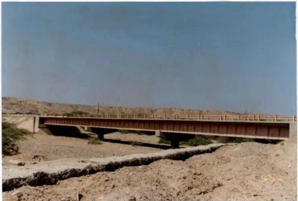
Foto N° 25. Vista al Puente Pariñas Norte protegido en su margen derecha (aguas arriba) por un muro de gaviones.
