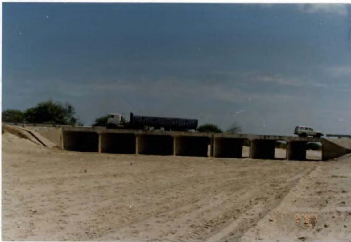
Foto N° 52. Vista de aguas abajo hacia aguas arriba donde se muestra el estado del área del cauce del Puente Lagarto (km 1287.200); tiene gaviones de defensa aguas arriba.
