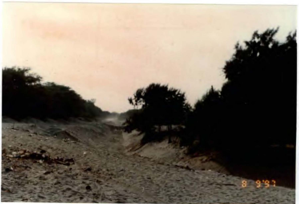
Foto N° 87. Otra vista al Dren La Legua en proceso de descolmatación para soportar las lluvias.
