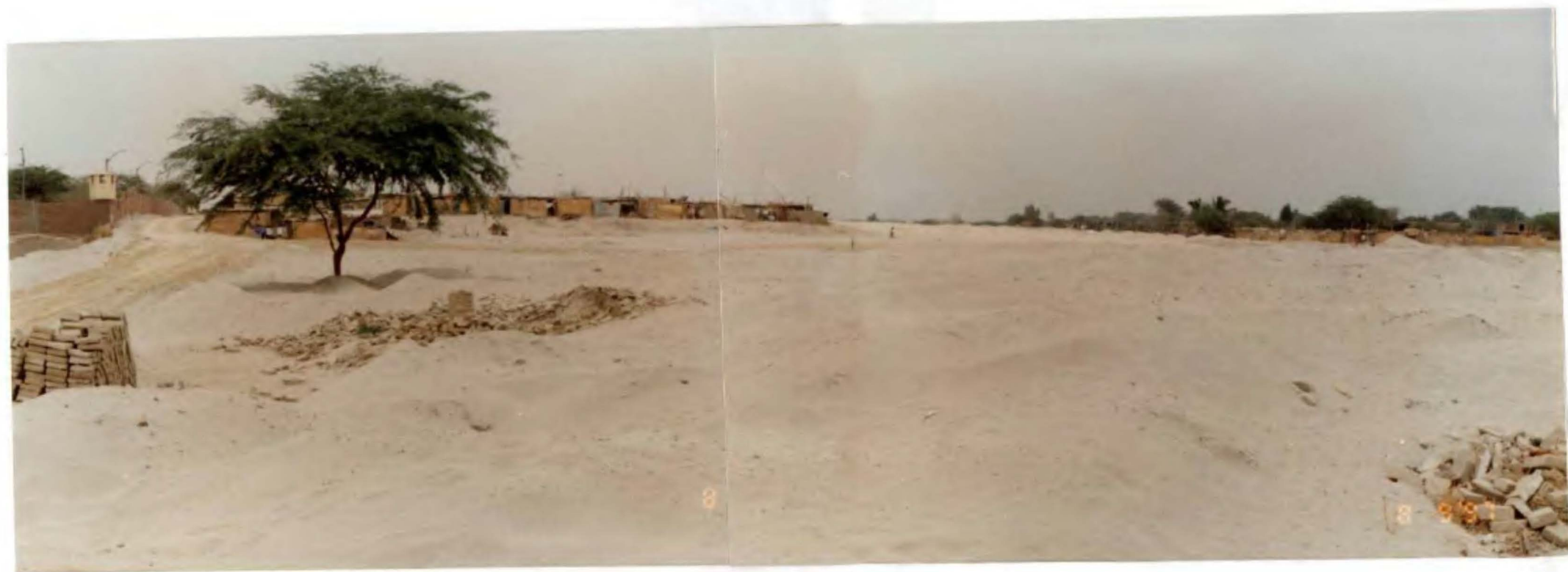
Foto N° 92. Area del pueblo joven Nuevo Norte donde el Organismo regional está depositando arena para luego cubrirla con una capa de lumaqueles y ser posteriormente ocupada por el Asentamiento Humano u obras comunales.
