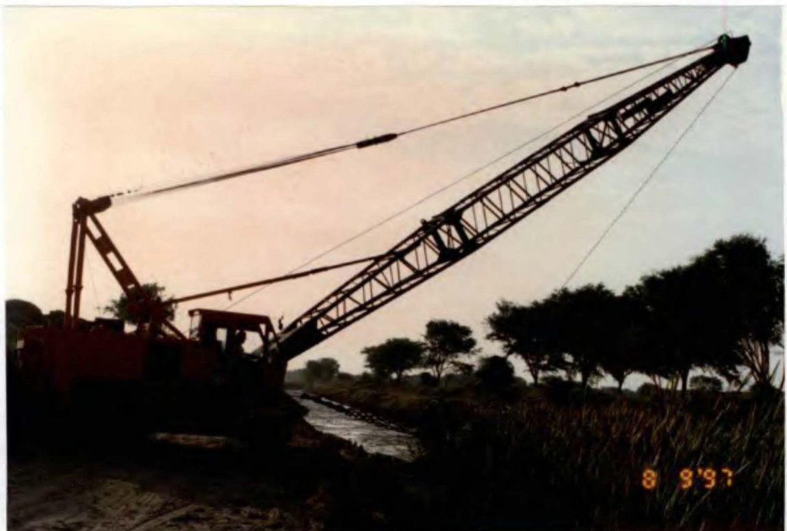
Foto N° 70. Dren Sechura en proceso de descolmatación.
