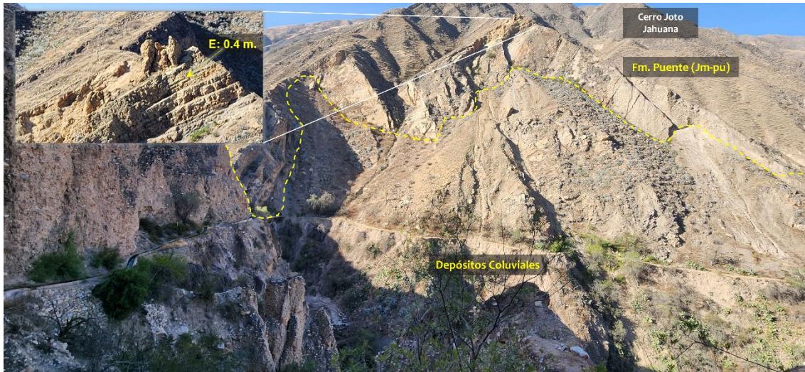
Figura 7. Sustrato rocoso de la Formación Puente – Sector Samana. Se observan afloramientos de areniscas pardas que están moderadamente meteorizadas y tienen estructuras medianamente fracturadas con espaciamentos entre 0.3 a 1 m.
