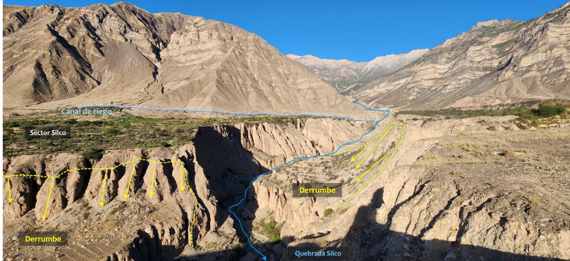
Figura 27. Se evidencia derrumbes en las laderas de la quebrada Silco. Vista hacia el oeste.
