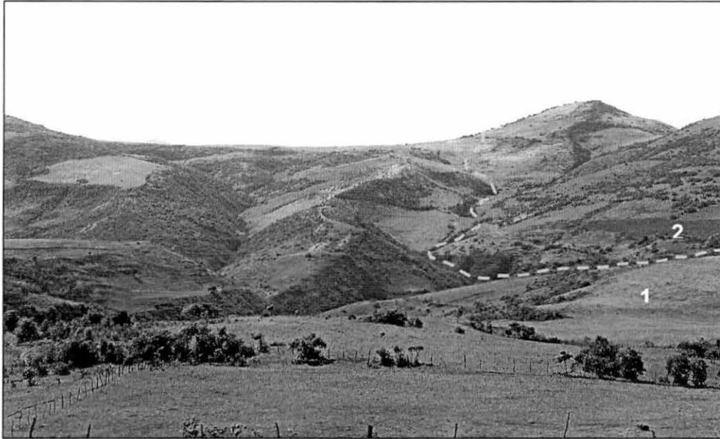
Fotografía 24. Flujos piroclásticos del Complejo volcánico Anchipan-Mutis (1) que sobreyacen rellenando una paleoquebrada labrada en la secuencia El Suro (2). Localizados en el río Pencayo.
