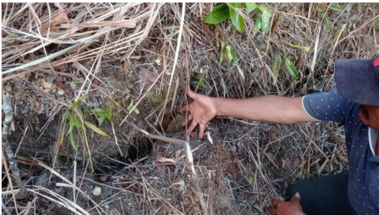
Fotografía 5. Agrietamientos en la ladera NE del cerro 1 (adyacente al caserío de Uctubamba). Fuente: registro de morador del caserío de Uctubamba, septiembre 2023.
