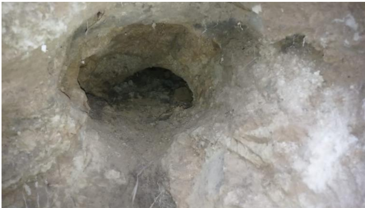
Fotografía 6. Acanaladuras subterráneas de agua en la ladera NE del cerro 1 (adyacente al caserío de Uctubamba). Fuente: registro de morador del caserío de Uctubamba , septiembre 2023.
