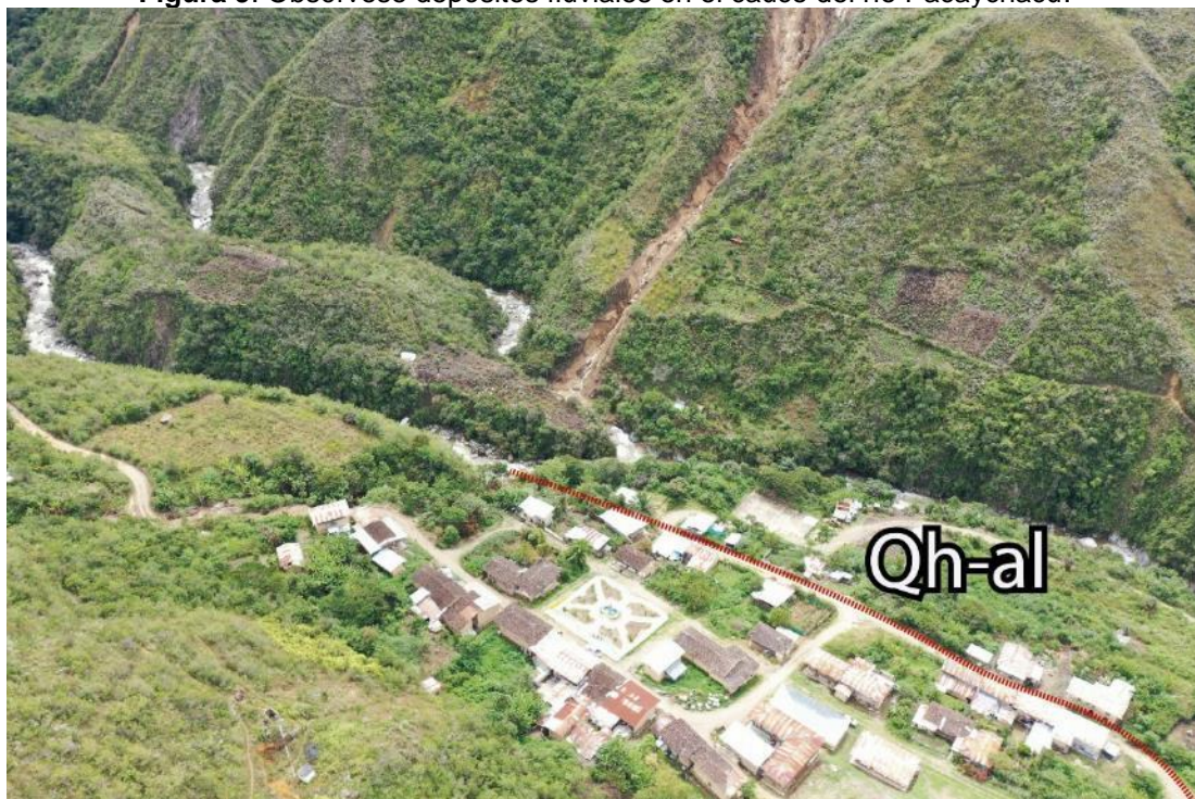
Figura 10. Depósitos aluviales adosados a la margen derecha del río Pacaychacu.
