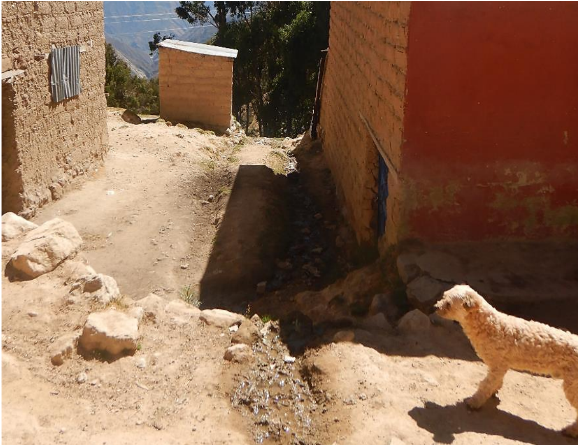
Fotografía 8. Viviendas con sistemas de desagüe inadecuados que direccionan sus aguas servidas hacia la ladera, lo que provoca la sobresaturación del terreno
